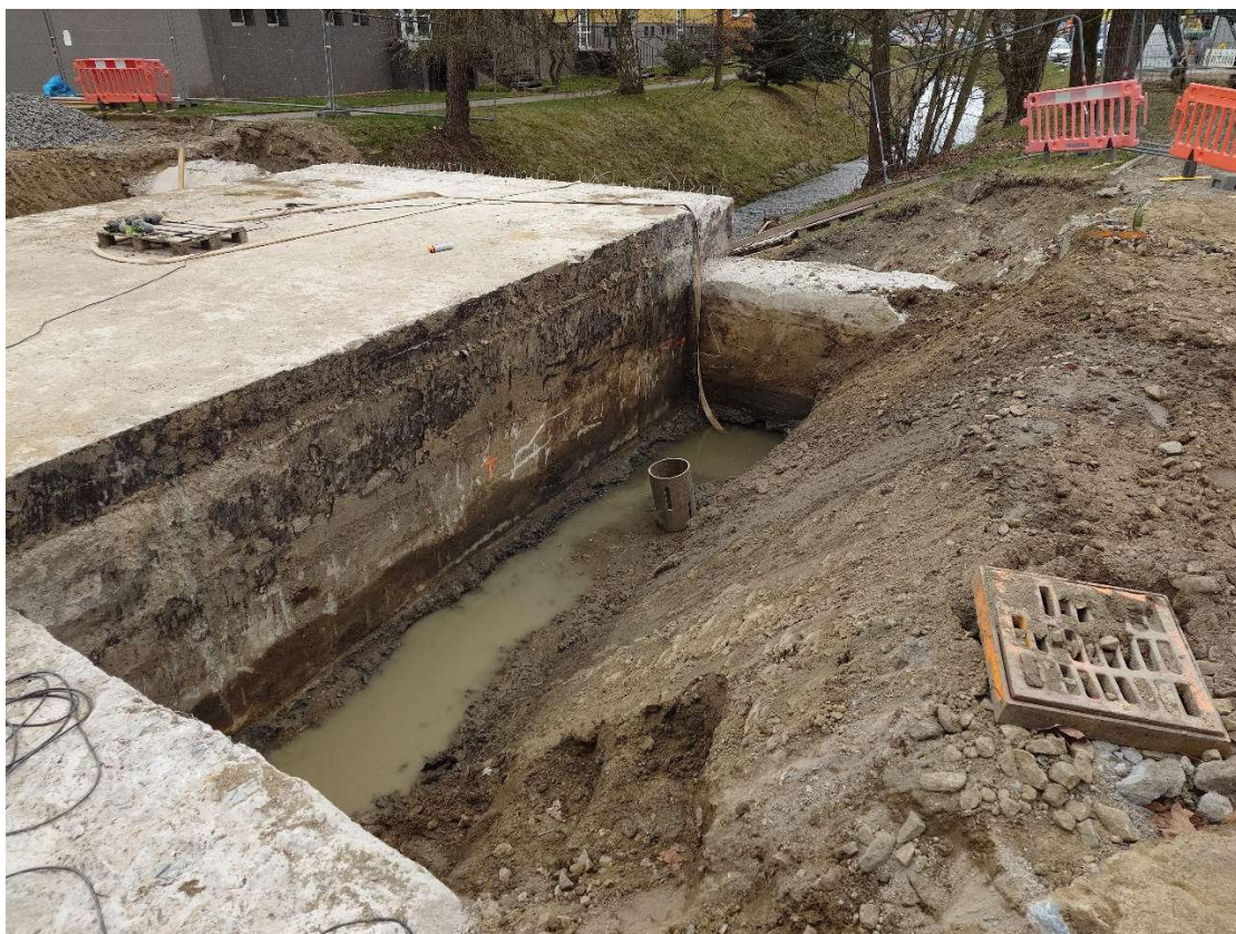
Foto č.6 – obnažené křídlo mostu a zeď
