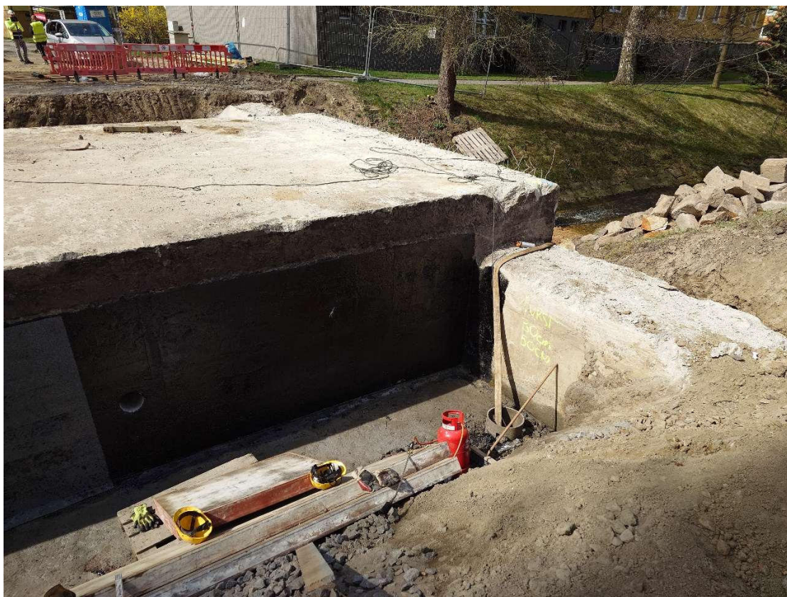
Foto č.6 – obnažené křídlo mostu a zeď
