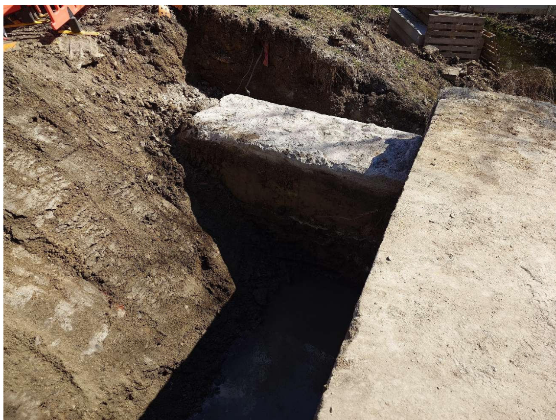
Foto č.4 – obnažené křídlo mostu
