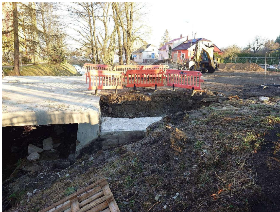
Foto č.4 – obnažené křídlo mostu
