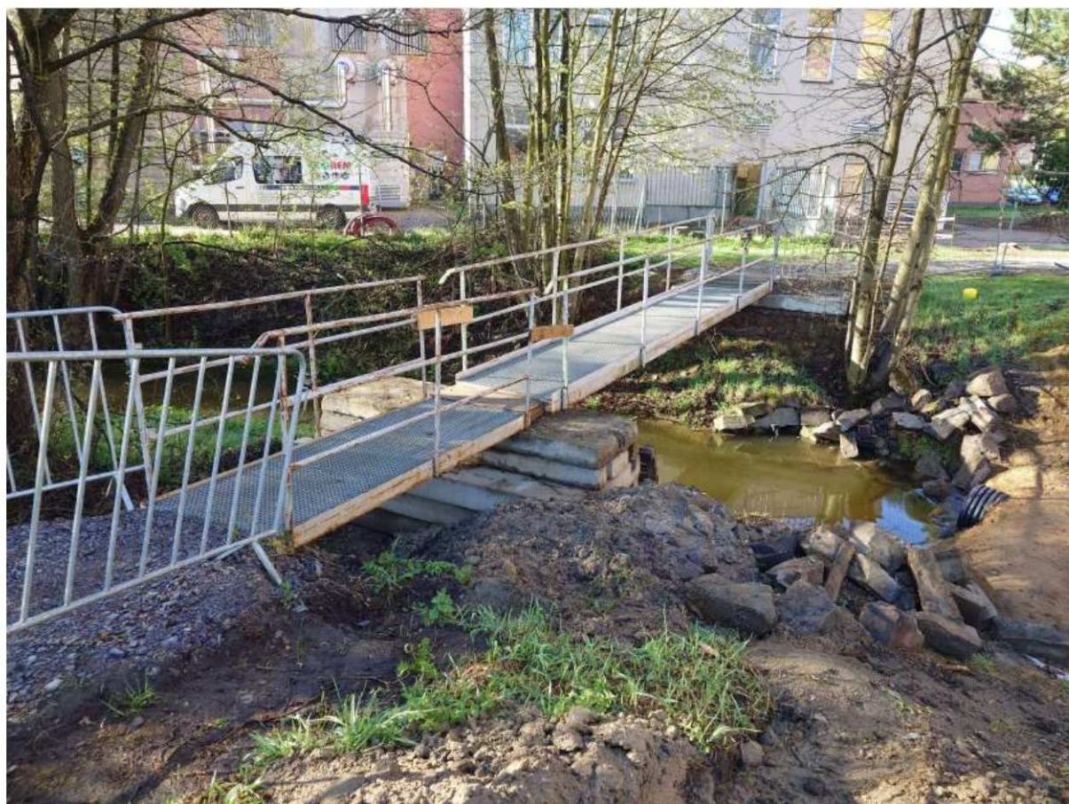
Foto č.2 – provizorní lávka přes vodní tok Staviště
