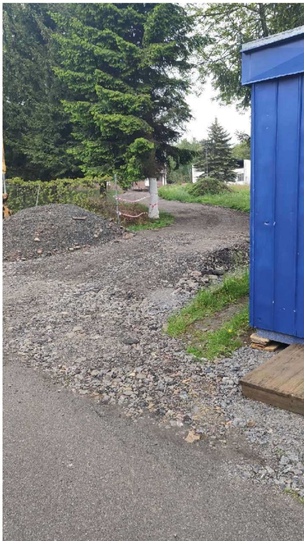
Foto č.1 – provizorní komunikace k areálu firmy SATT a.s.
