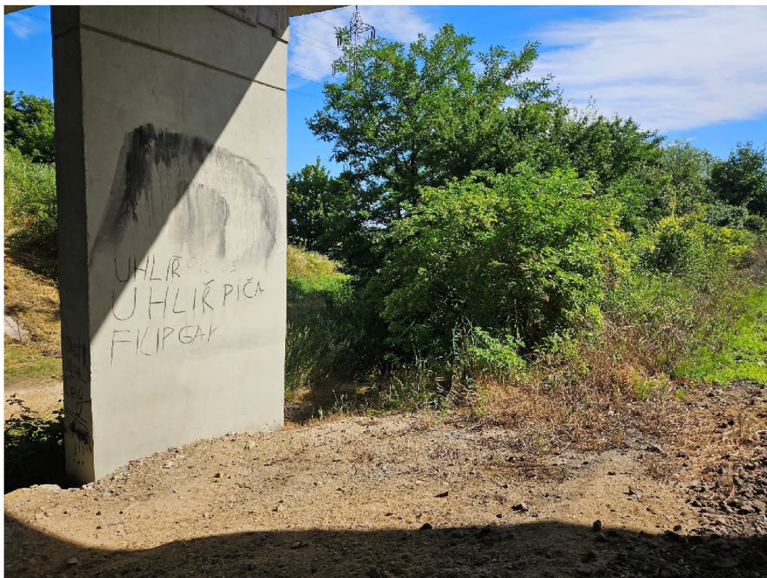
Foto 4 - Místo sondy DP438
