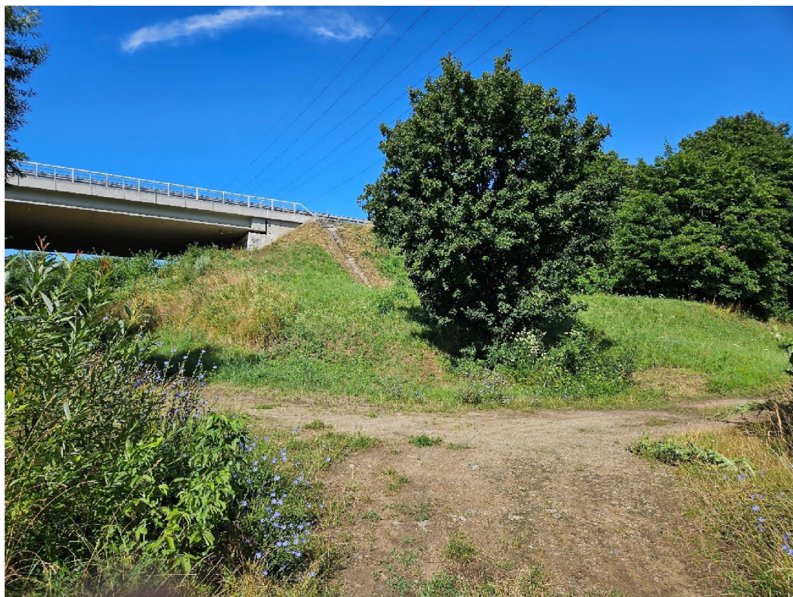
Foto 6 - DP437, SP457 - opačný směr pohledu JZ-SV
