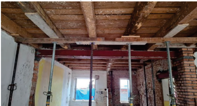
7. Průvlak nad 1.NP včetně podpírání konstrukce
