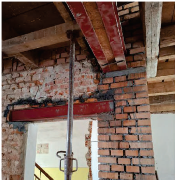
9. Uložení stropní konstrukce v 2.NP
