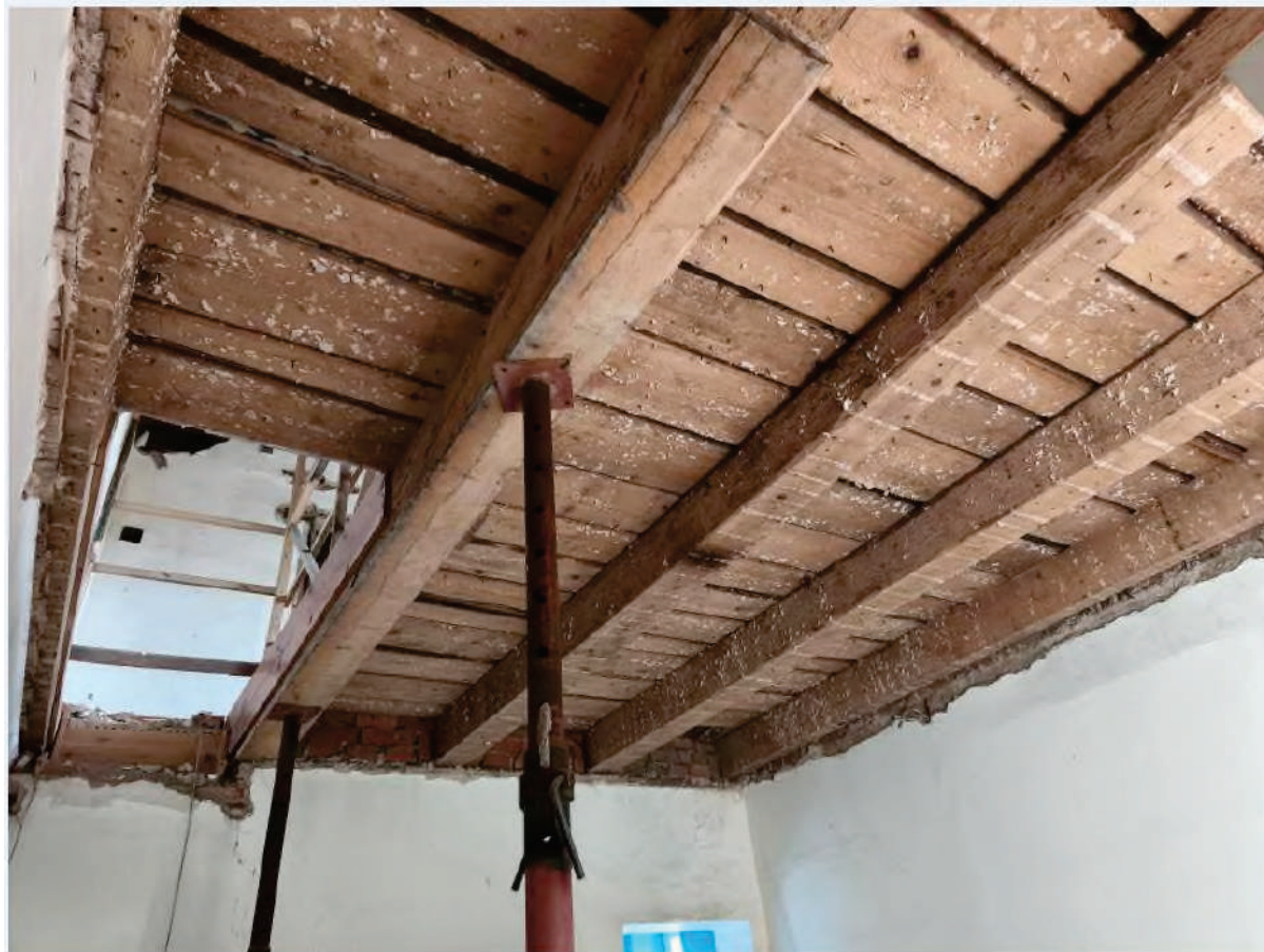
4. Strop nad místností č. 103 a 110
