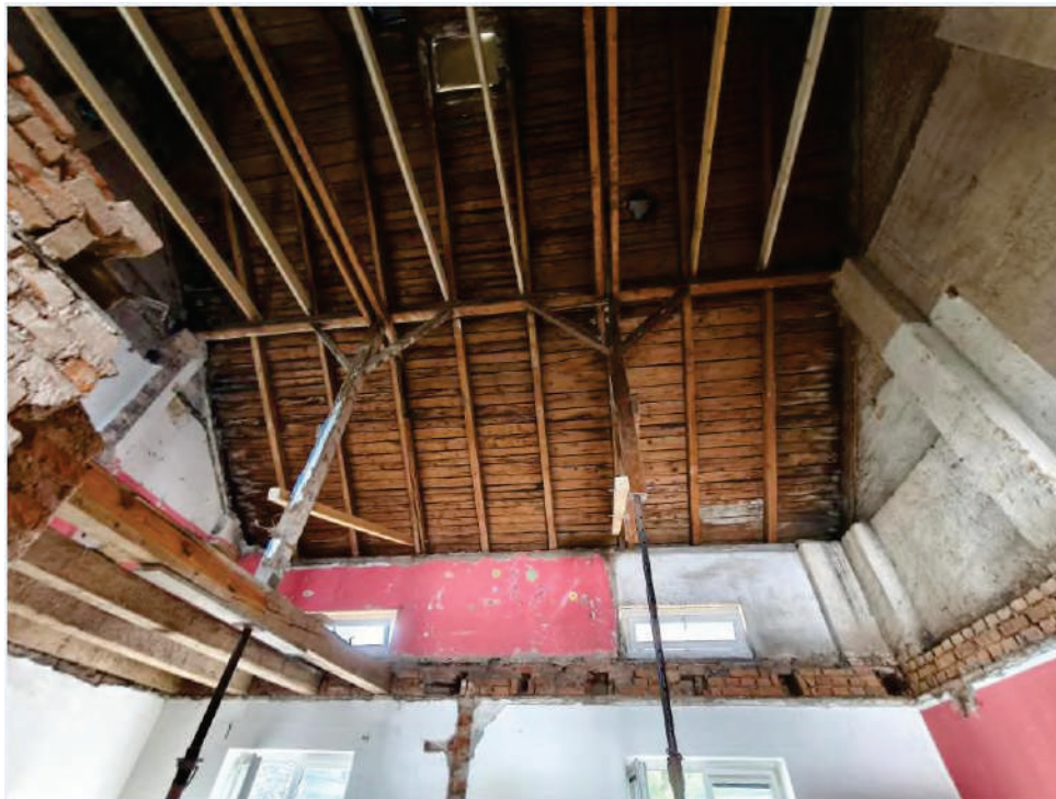
5. Stropní trámy nad místností č. 208 včetně podpírání stropních trámů a konstrukce krovu
