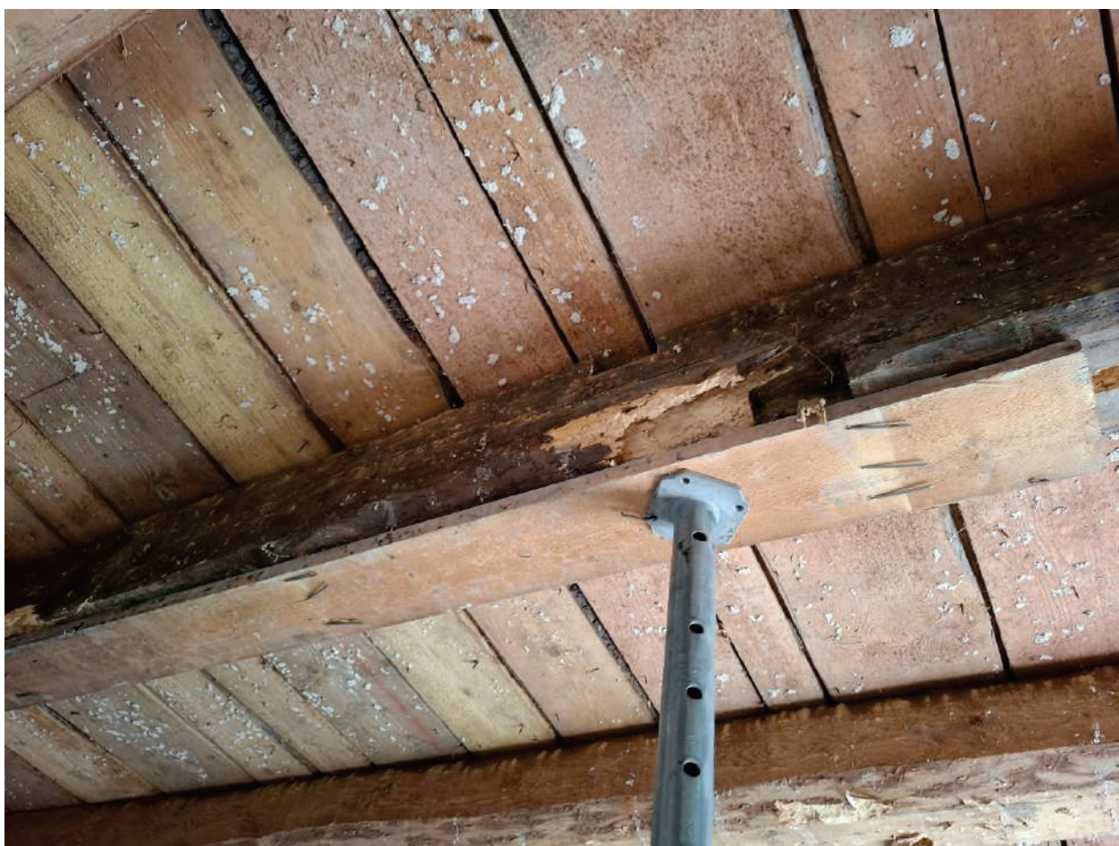
9. Uložení stropní konstrukce v 2.NP
