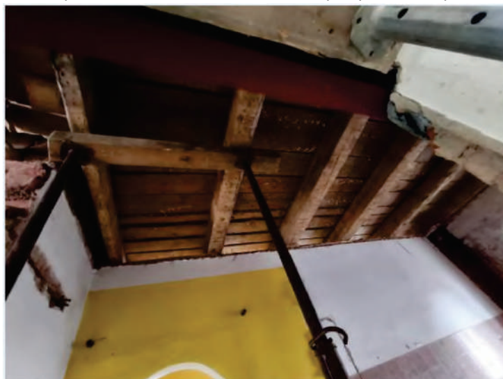
7. Průvlak nad 1.NP včetně podpírání konstrukce
