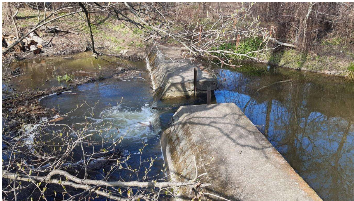
Obr. č. 5: Stávající příčný objekt v intravilánu města určený k úpravě.
