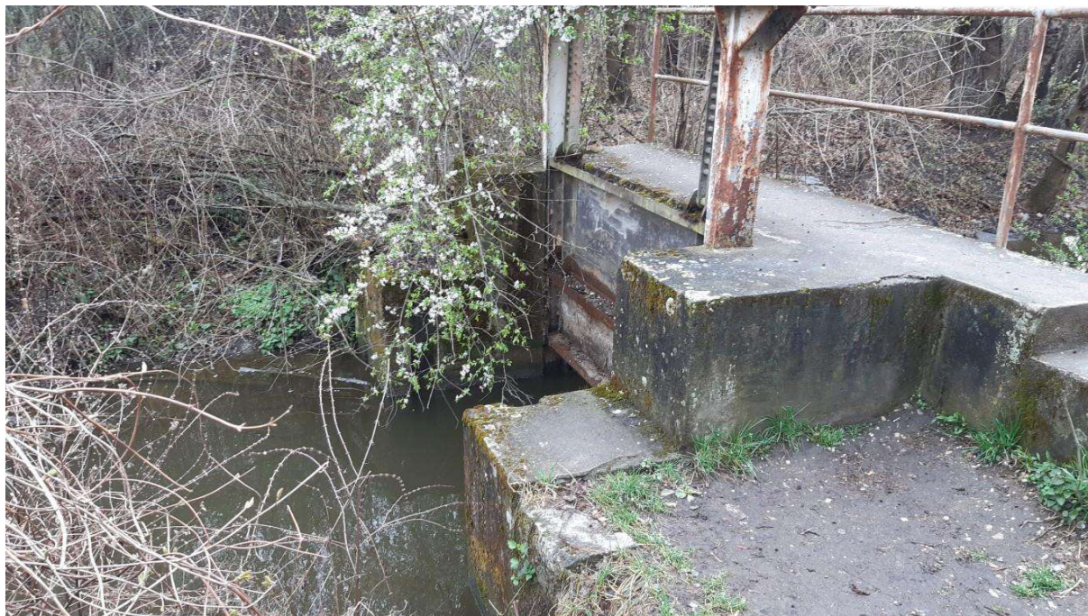
Obr. č.1: Manipulační objekt v ř. km 2,62 k odstranění
