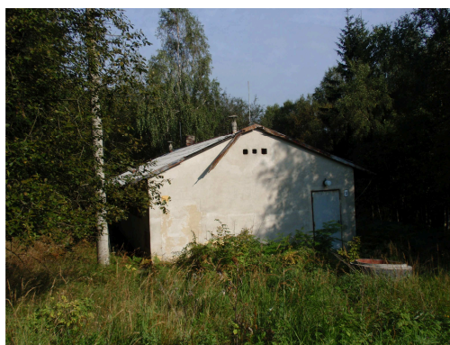
Objekt č.022 – WC
