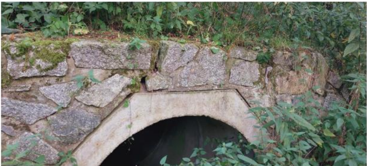
zdivo výtokového čela.
