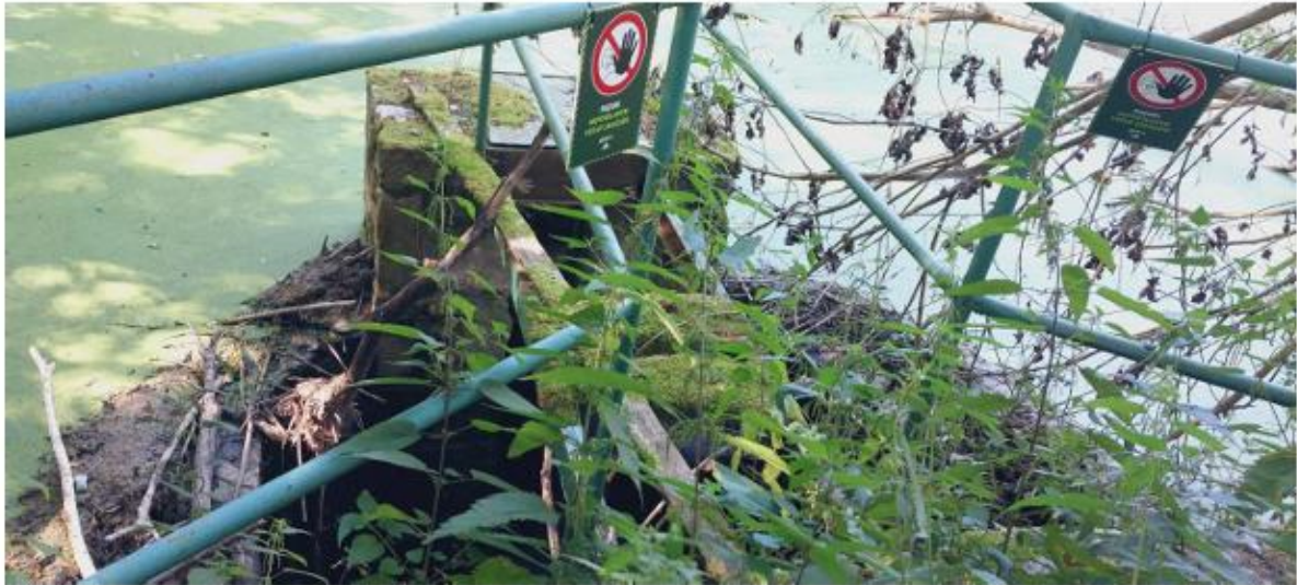
Pohled na lávku a sružený objekt.
