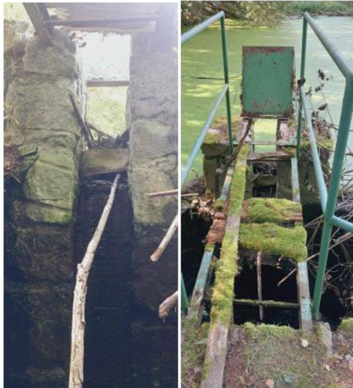
Pohled na dlužovou stěnu a požerák.
