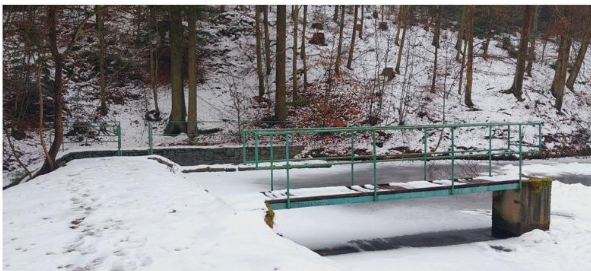
Zábradlí požeráku + přes BP
