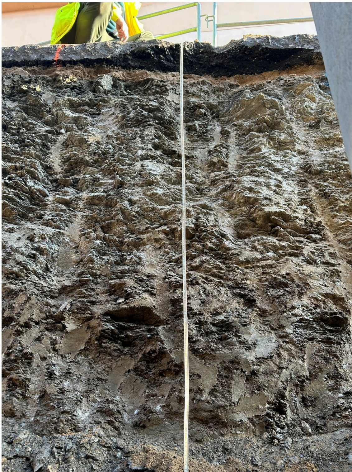
Obrázek 3. Horní část výkopu u ŠK2.
