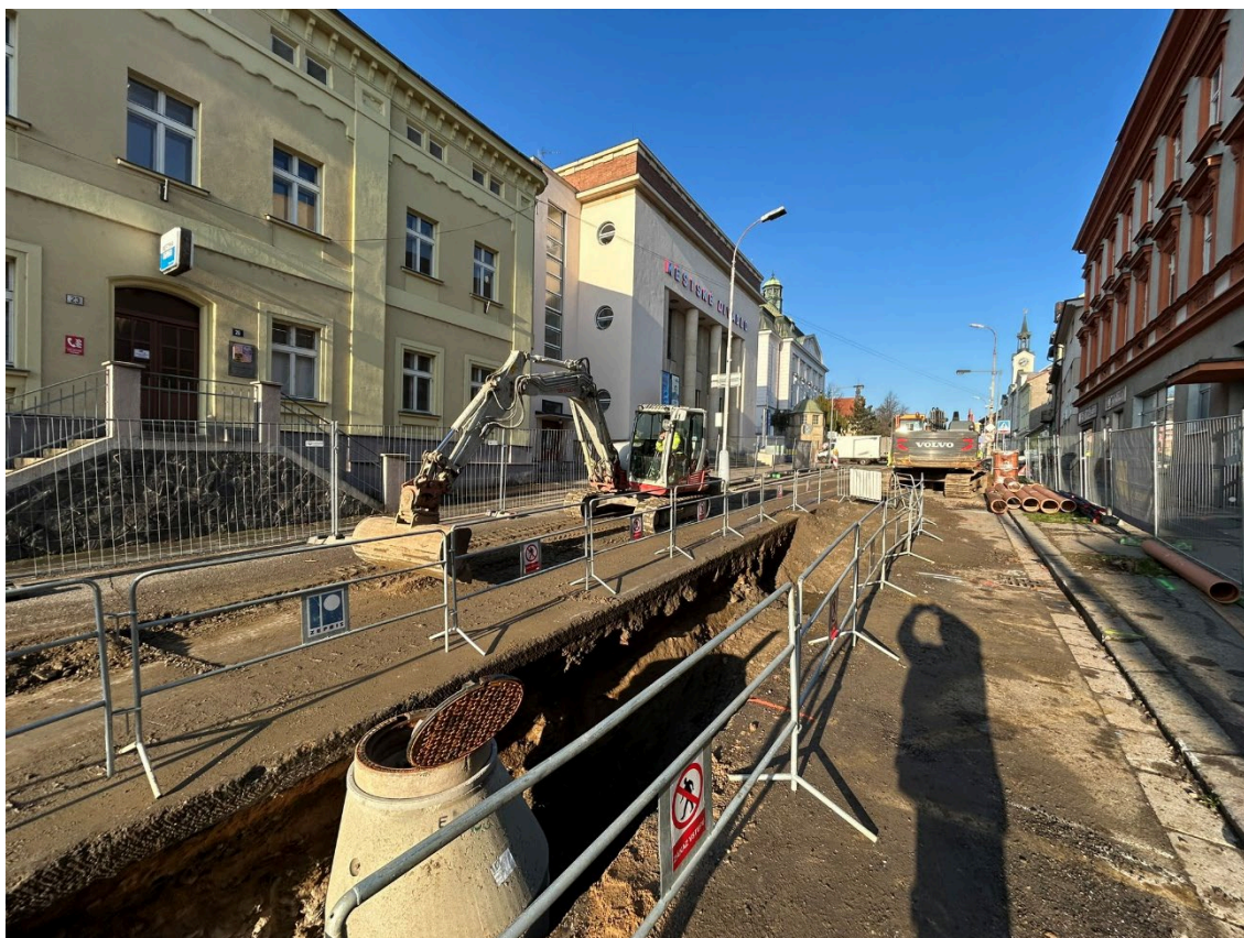
Obrázek 1. Celkový pohled na dokumentovaný výkop u ŠK2.
