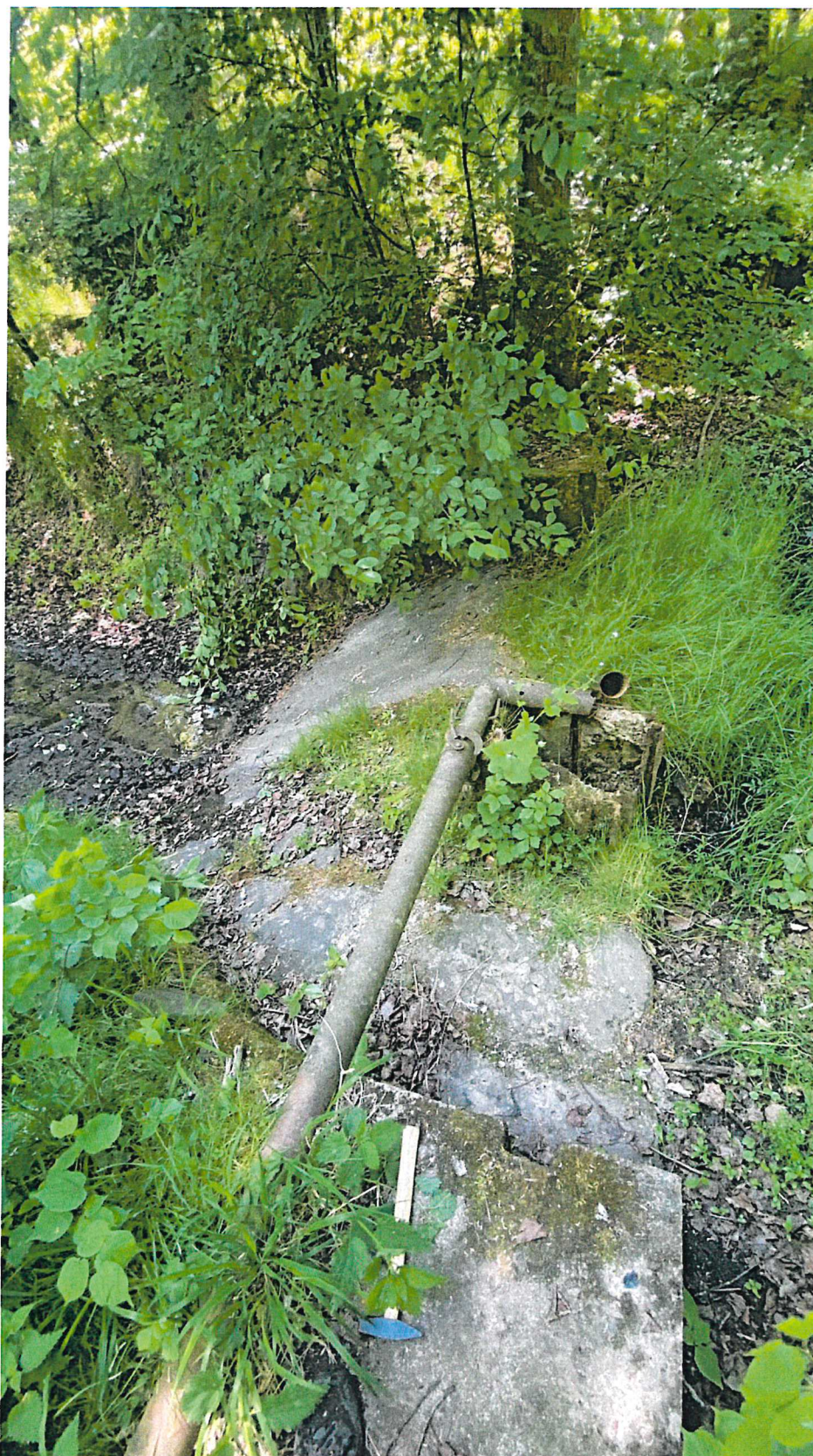
VN Obomí - betonový stupeň předzdrže
