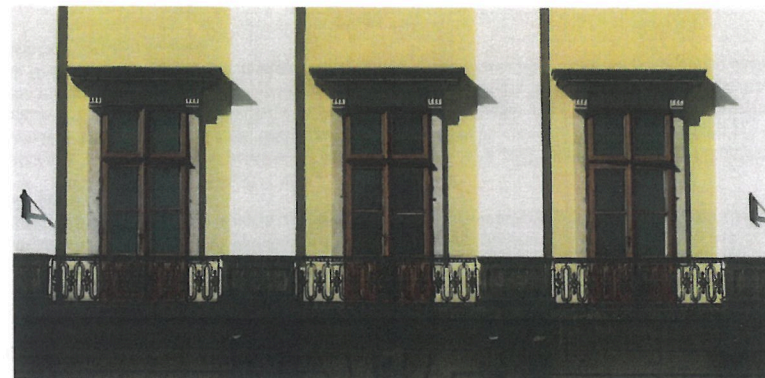
Obr.1: Fotografie 3 balkonových dveří – stávající stav (viz podmínka č. 1)
