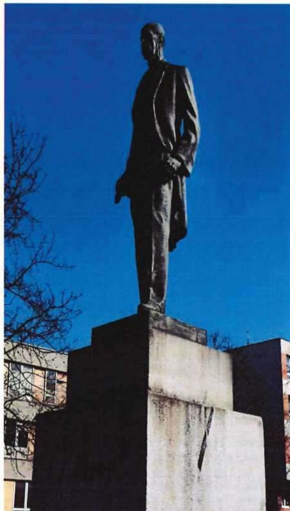
Povrchy kamene znečištěné usazenými prachovými depozity a skvrna ( kamenná žíla tmavého odstínu )
