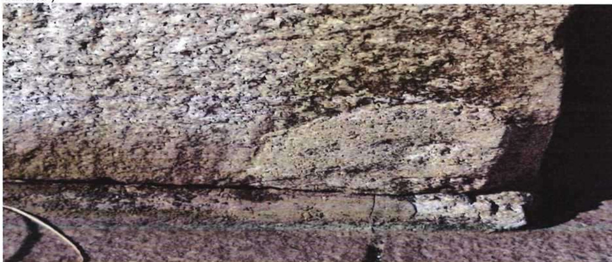
Povrchy kamene znečištěné usazenými prachovými depozity a skvrna ( kamenná žíla tmavého odstínu )
