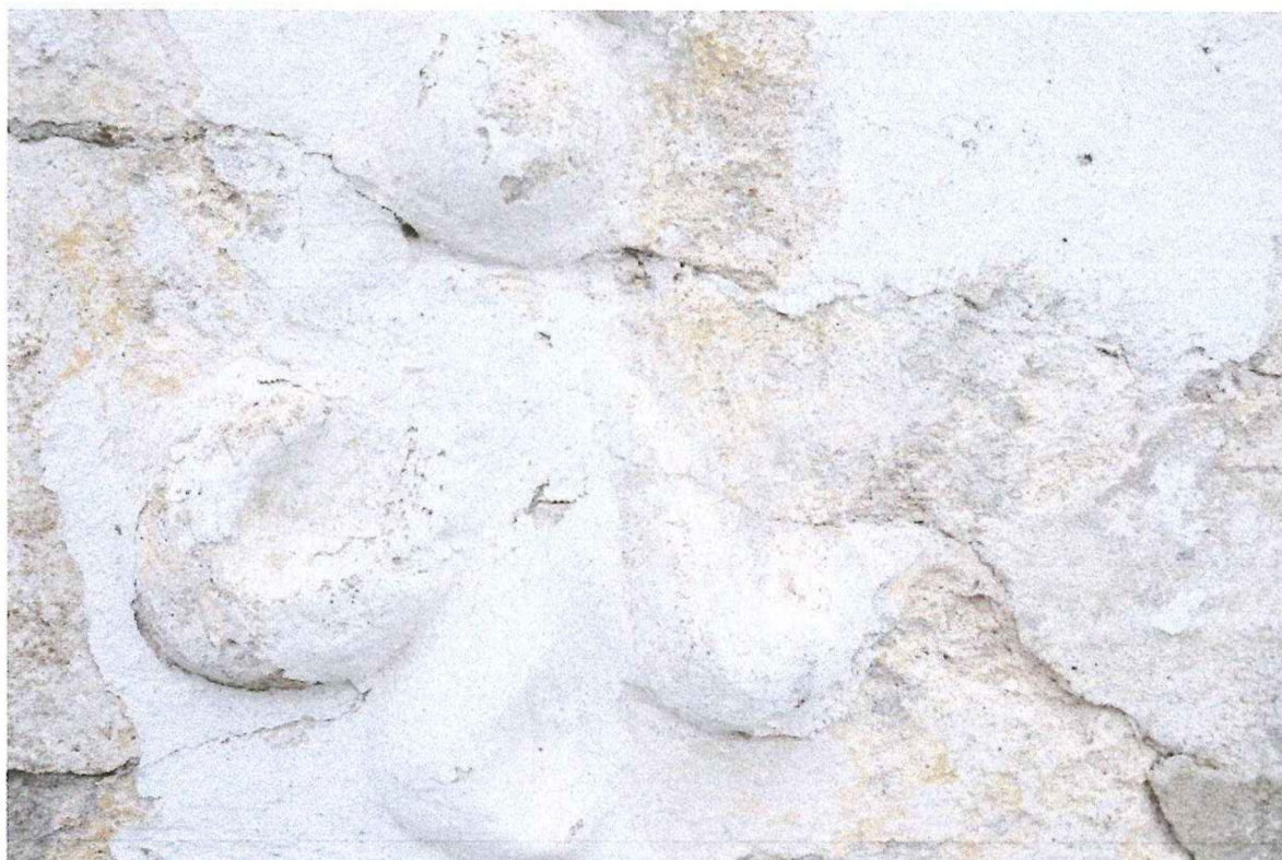
Obr.6/ Detail v místě plastické výzdoby s viditelnými poškozeními – trhliny mladší omítkové vysprávký. Šipkou je označen velmi malý fragment zelené barvy.
