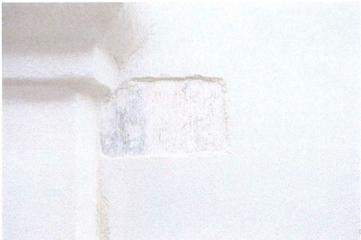
Obr.12/ V sondě odhalený fragment historické omítky s bílým vápenným nátěrem a blíže nespecifikovaným fragmentem barvy.
