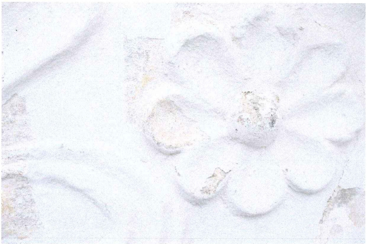
Obr.10/ Detail plastické výzdoby. Vystouplé prvky byly světlejší oproti okrovému pozadí, barva plastický prvků byla v odstínu lomená bílá (lomená do teplejšího tónu).
