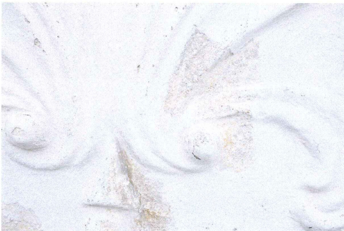
Obr.5/ Detail plastické výzdoby. Vystouplé prvky byly světlejší oproti pozadí. Povrch plastických prvků je poškozen.
