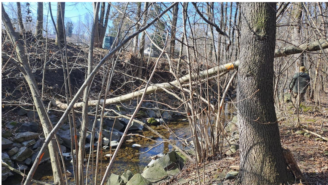
Strom č. 21 – vývrat přes koryto v ř. km cca 0,300
