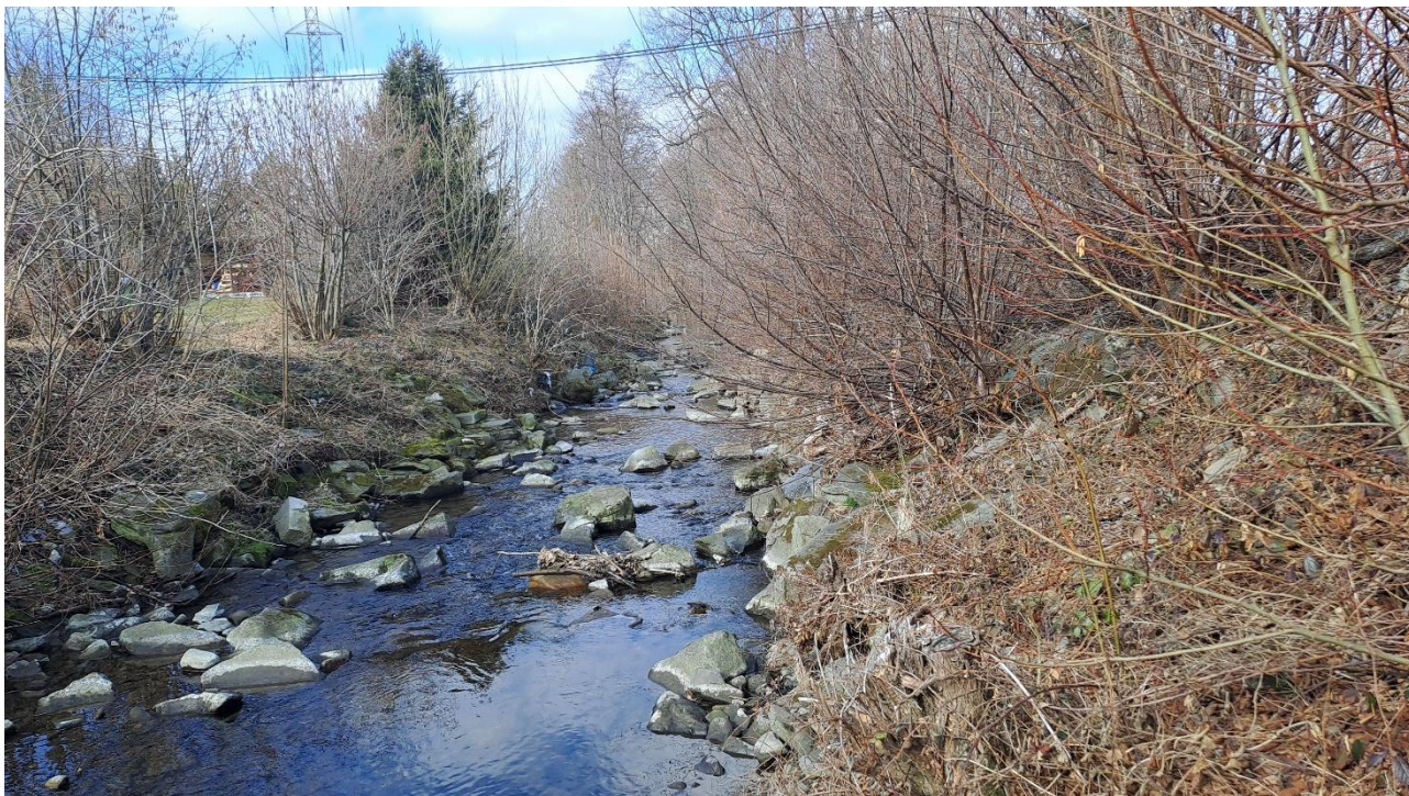
Zarůstající průtočný profil v km cca 1,550 (pohled z mostu dolů po proudu)
