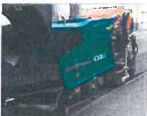
Asfaltová cesta v tramvajové kolejnici
