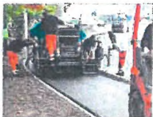
Stavba účelové cesty
