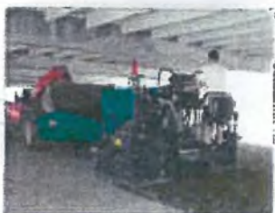
Výroba podkladu pro dlažbu
