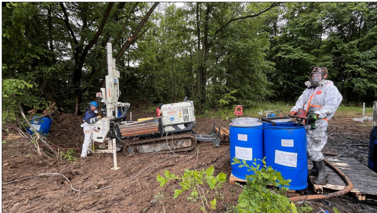
Obrázek 4: Příklad injektáže koloidního AU v rámci pilotního testu
