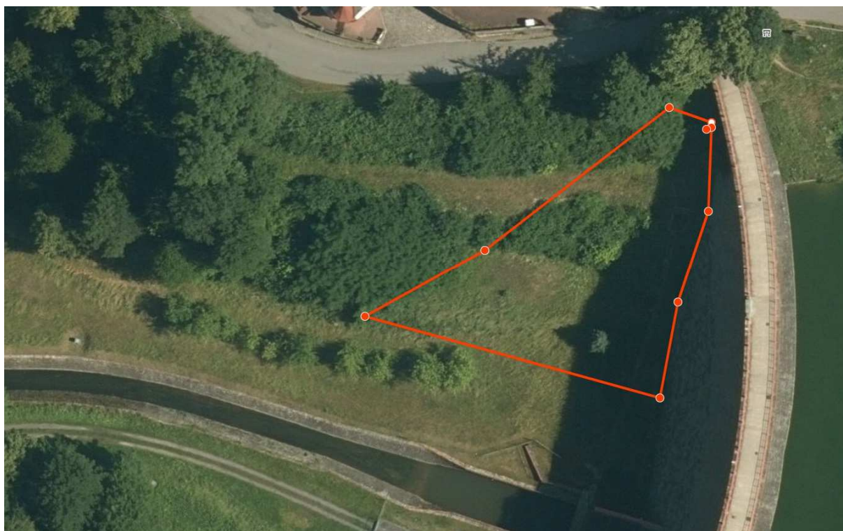
Vzdušná část hráze – pravý břeh.
