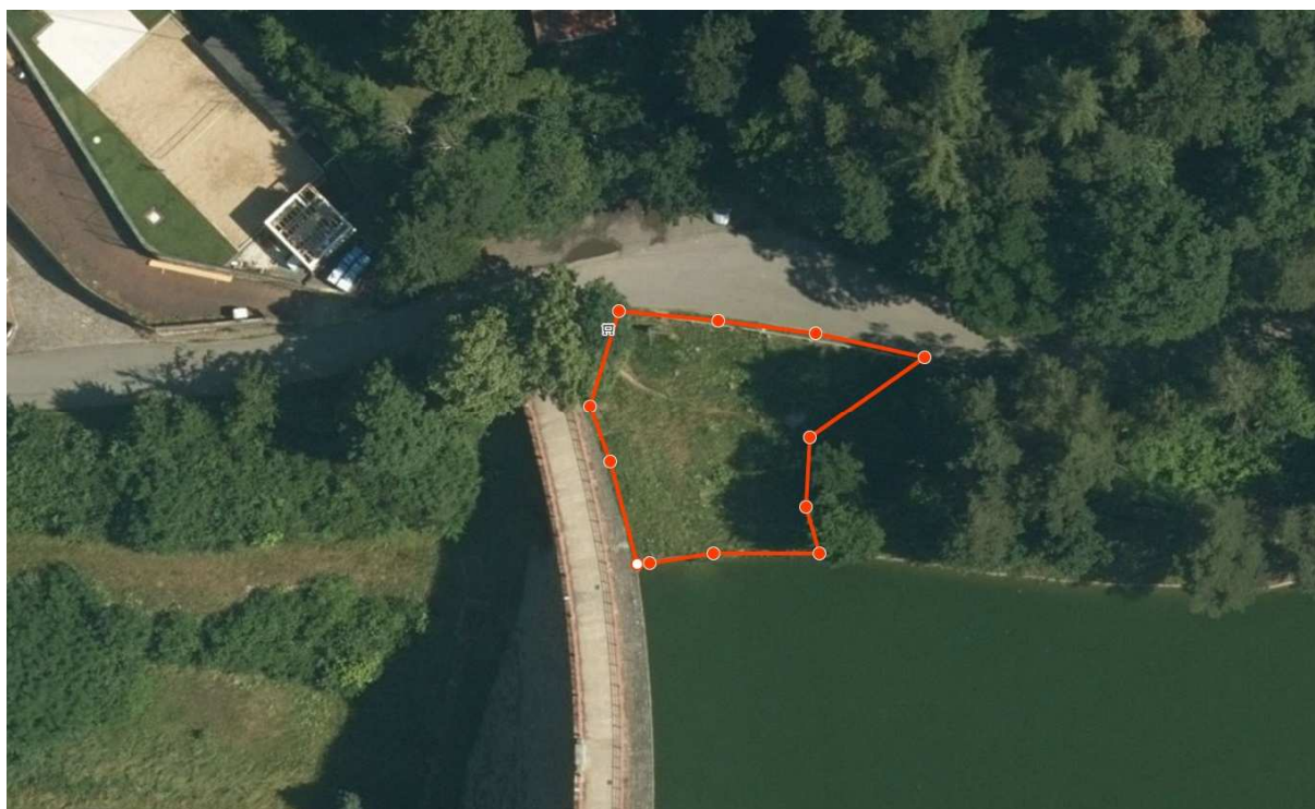
Návodní část hráze – pravý břeh.
