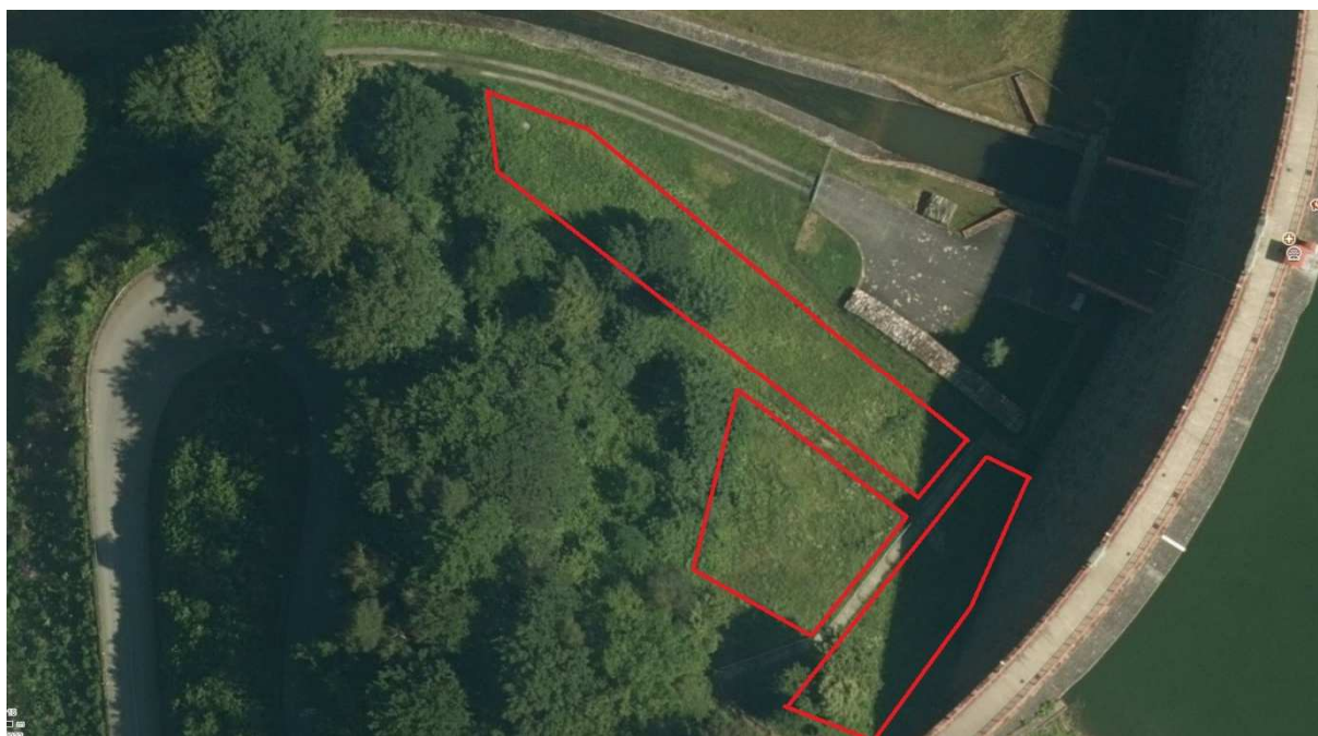
Vzdušná část hráze – levý břeh.
