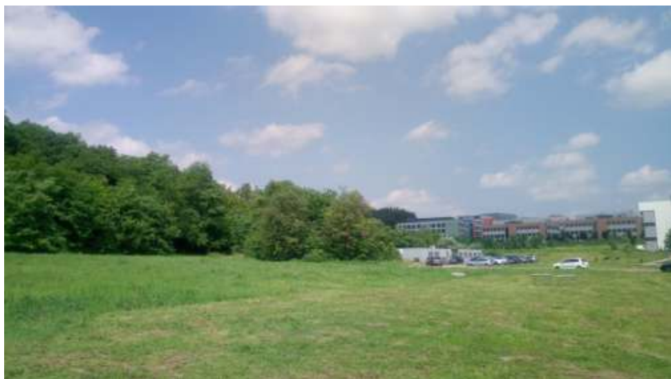
Střední a severní část území – část stávajícího porostu, louka a dočasné zázemí stavby s parkováním
