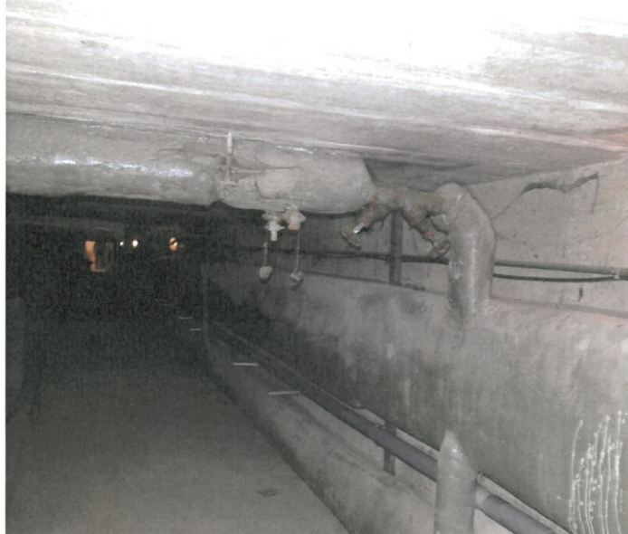
Stávající uzávěry stoupaček vytápění
