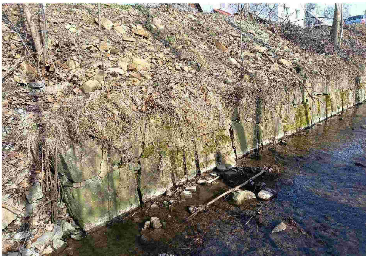
Podélné PB opevnění koryta nad stupněm v ř.km 1,150
