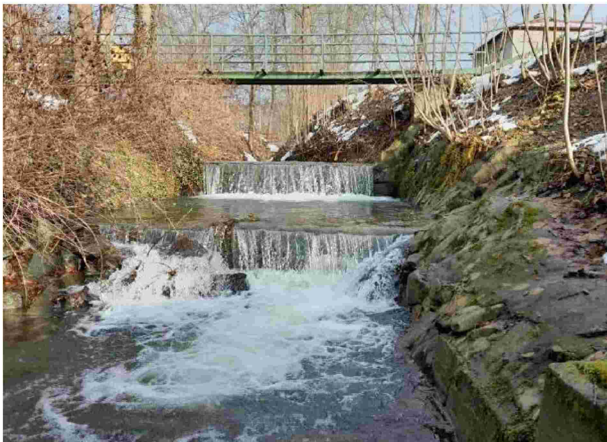
Stupeň ř.km 1,253 – pohled proti toku
