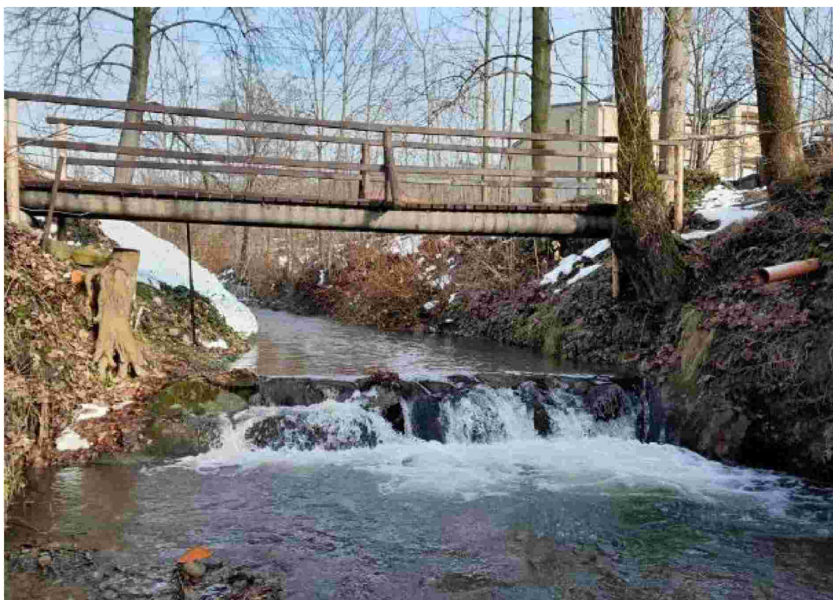
Balvanitý skluz ř.km 1,300 (zahlobení dna) – pohled z PB proti toku
