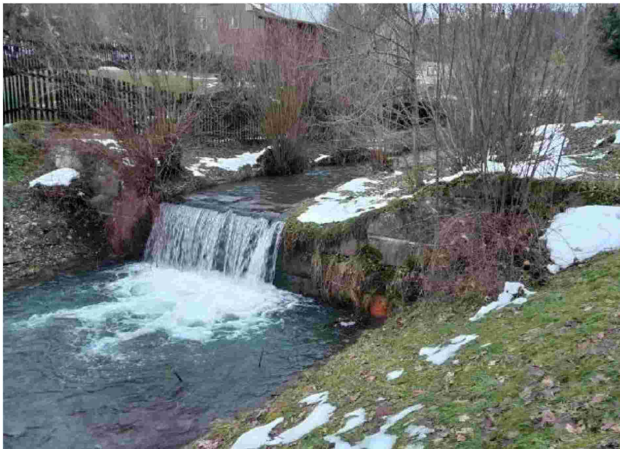
Stupeň ř.km 1,462 – pohled proti toku
