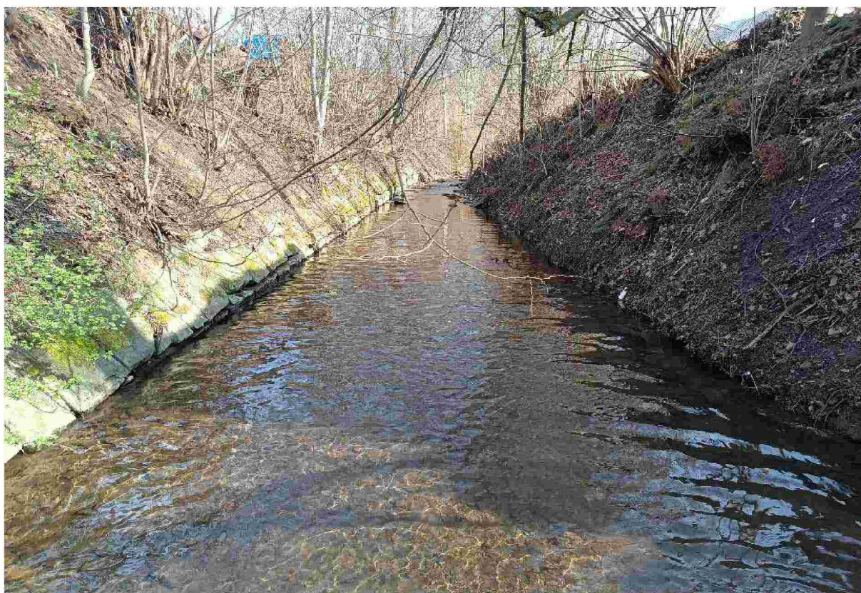
Podélné PB opevnění rovnaninou ř.km cca 1,210
