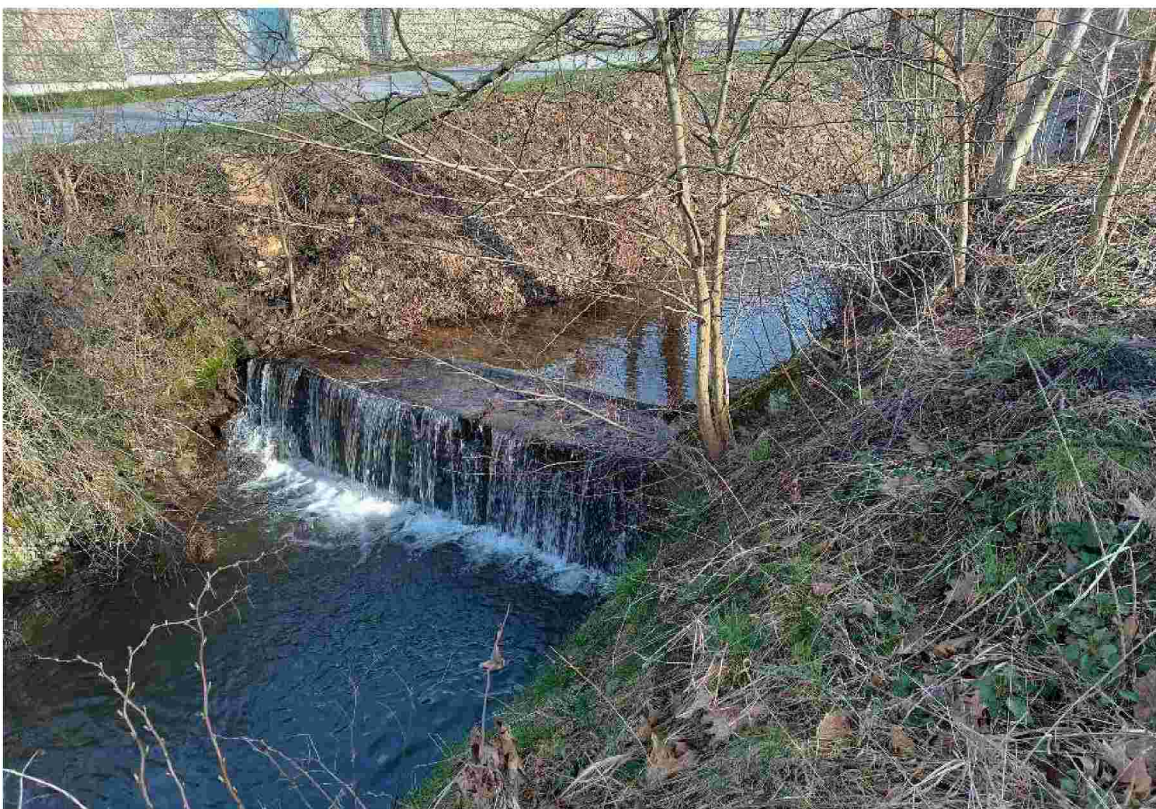
Stupeň ř. km 1,100 – pohled z LB proti toku
