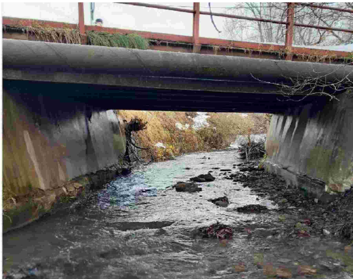
Silniční most ř.km 1,075 – pohled proti toku (začátek řešeného úseku)
