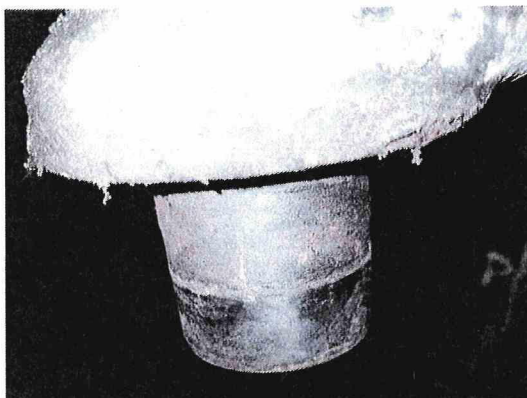
Koroze pravého spodního svislého čepu
