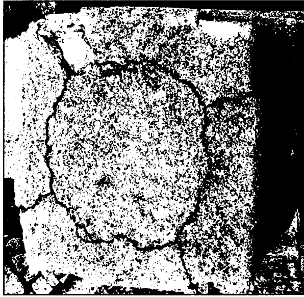
Poškození a degradace umělého kamene na architektuře základny pomníku
