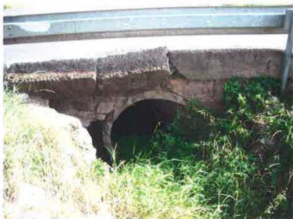
propustek na křiž. se sil. III/511
