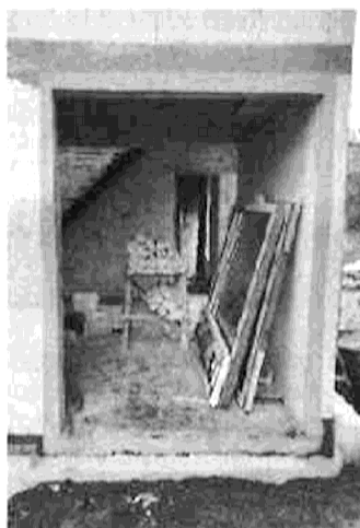
Obrázek č.2 Stavební otvor připravený pro osazení okna do vnějšího líce zdiva a předsazenou montáž
