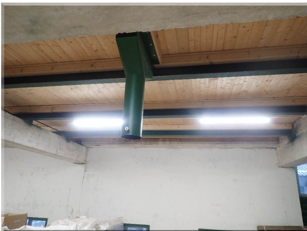
Foto PB266070: 02-h - sklad šišek - podlahy v 1. NP až 5. NP (nosná konstrukce části podlah)
