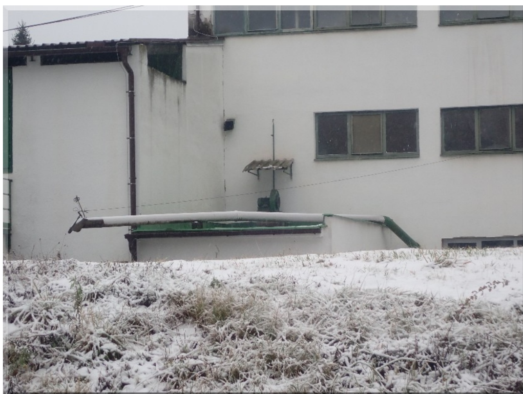
Foto PB266178: 04-l - lušτίrna - markýza nad ventilátorem nad akumulacími nádržemi (šiškomet) (východní strana, cca 2. NP)
