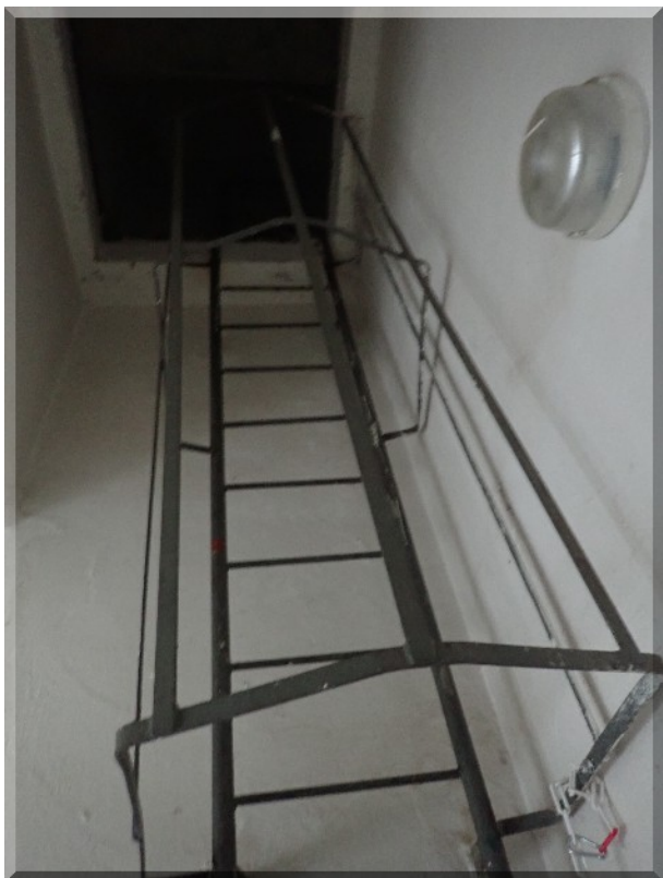
Foto PB266109: 04-b - luštírna - žebřík do strojovny výtahu s poklopem a pomocnou konstrukcí pro zdvih břemene (5. NP)
