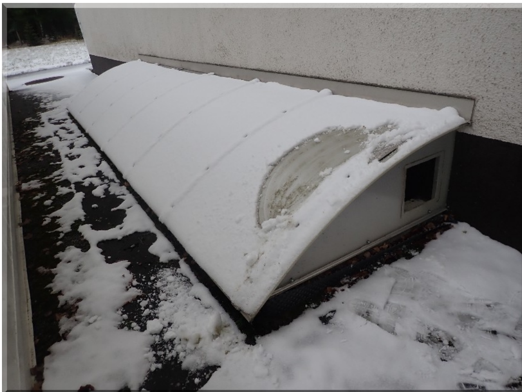
Foto PB266045: 02-s - sklad šišek - anglický dvorek na západní straně (přístup ze sklepa)
