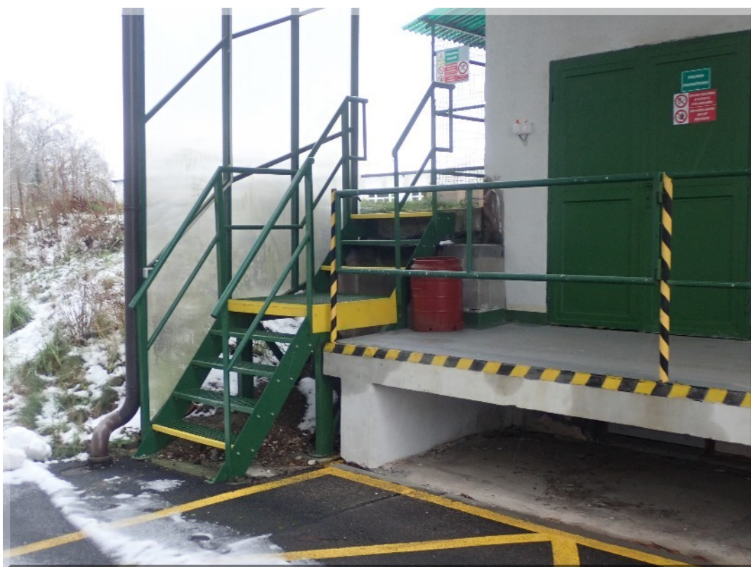
Foto PB266064: 04-j - luštírna - schodiště ke strojovně chlazení boxu č. 6 a zábradlí (severní strana, vedle nakládací rampy)
