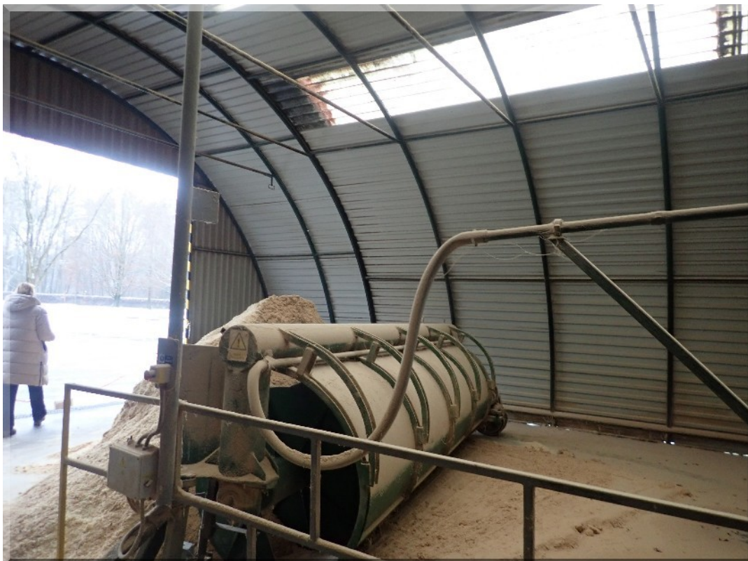
Foto PB266130: 05-e - kotelna - sklad pilin před kotelnou a zábradlí zdvihací plošiny BELET (hlavní nosná konstrukce haly před kotelnou)
