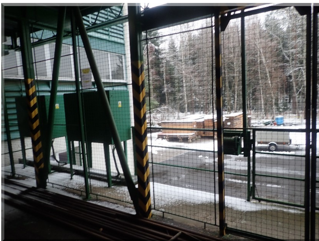
Foto PB266091: 02-n - sklad šišek - sklad "U" - štítová stěna (štítová stěna na východě včetně zábradlí)
