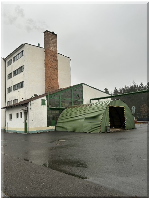
Foto kotelna-pristavba: 05 - kotelna (sklad pilin před kotelnou, kotelna, sklad vyluštěných šišek a akumulční nádrže, cca 24 * 18 m)
