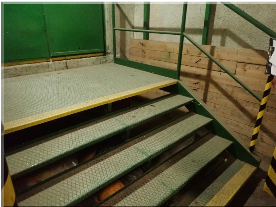
Foto PB266093: 02-l - sklad šišek - schodiště od příjmu suroviny do skladu "U" (přízemí, západní strana)
