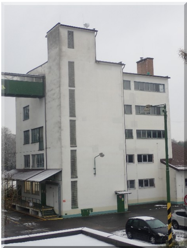
Foto PB266199: 04 - luštírna (rozměry cca 17 * 18 m, 5 NP, hlavní nosná konstrukce železobetonová)
