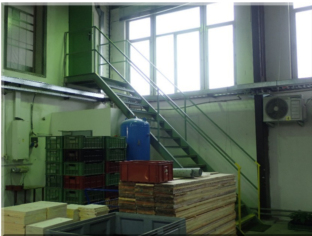
Foto PB266166: 06-d - mrazírenská hala - schodiště (uvnitř na východní straně)
