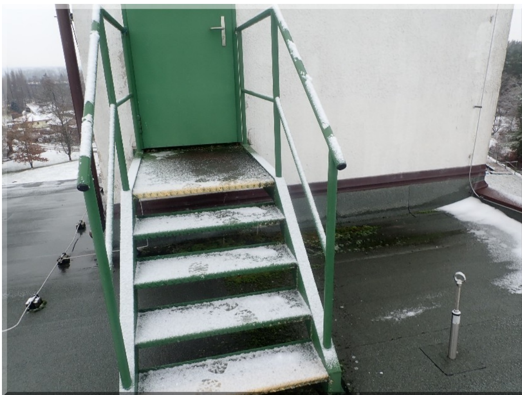
Foto PB266111: 04-a - luštírna - schodiště s podestou na střechu (střecha u výtahu)
