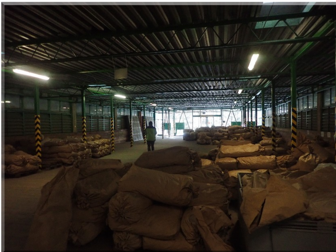
Foto PB266088: 02-m - sklad šišek - sklad "U" - hlavní nosná konstrukce (střední budova, 1. a 2. NP, cca 12 * 34 m)
