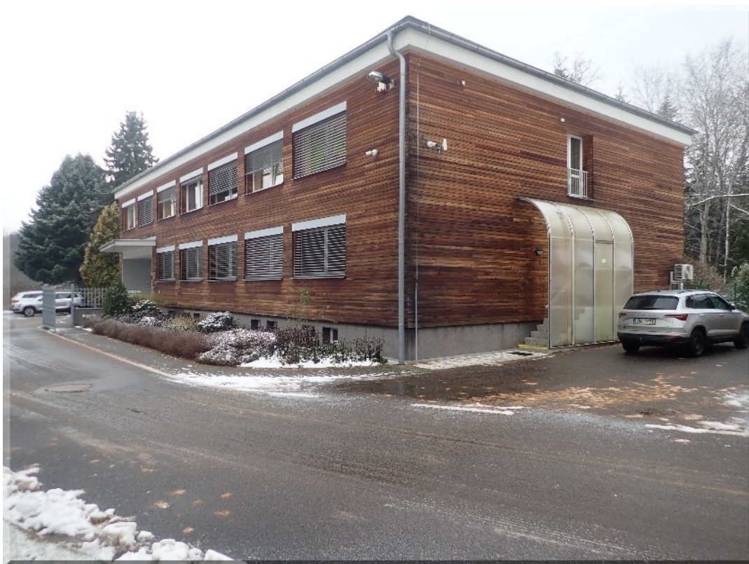
Foto PB266041: 01 - administrativní budova (budova se nachází u vstupu do areálu, ocelovými konstrukcemi jsou přístřešek a zábradlí)
