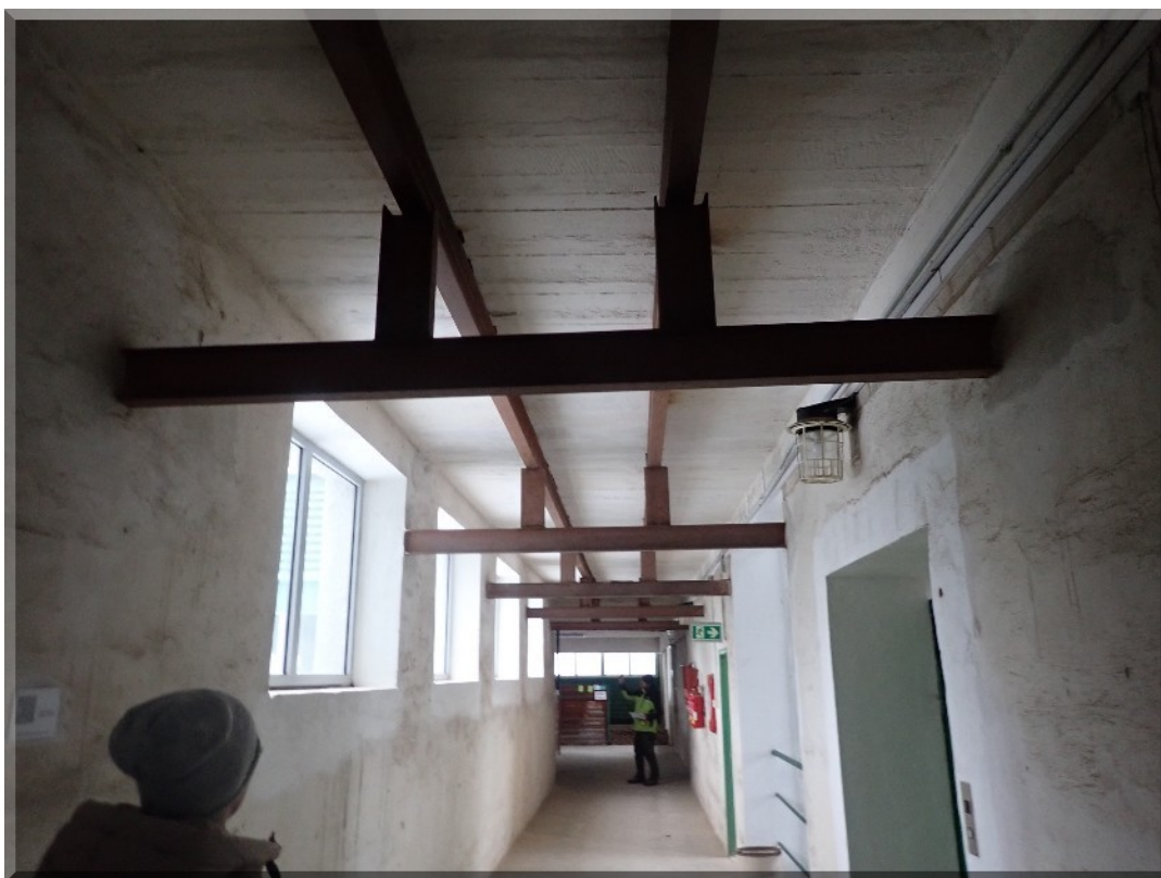
Foto PB266097: 02-j - sklad šišek - výztuhy pod stropem v chodbě 4. NP (zesíleno cca 12 m chodby)
