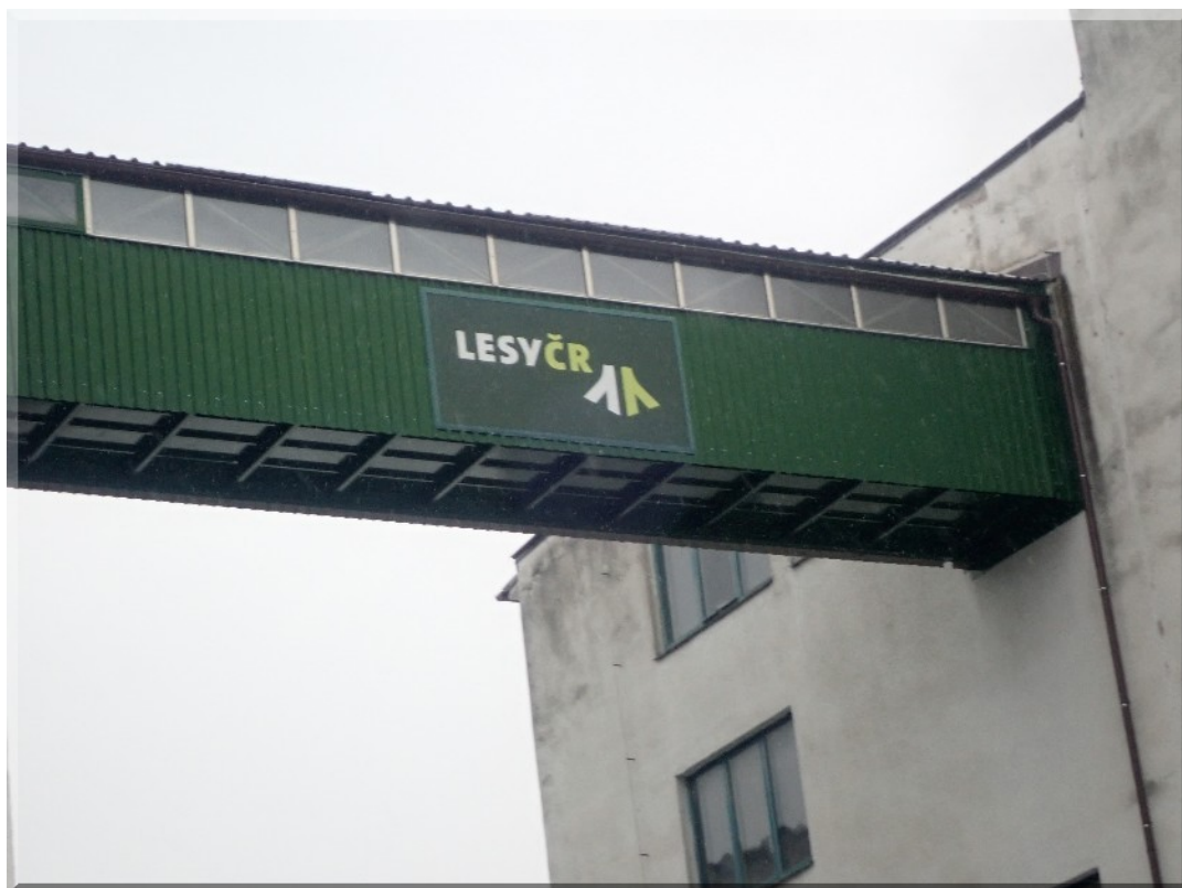
Foto PB266192: 04-c - luštírna - spojovací most (mezi luštírnou a skladem šišek v 5. NP)
