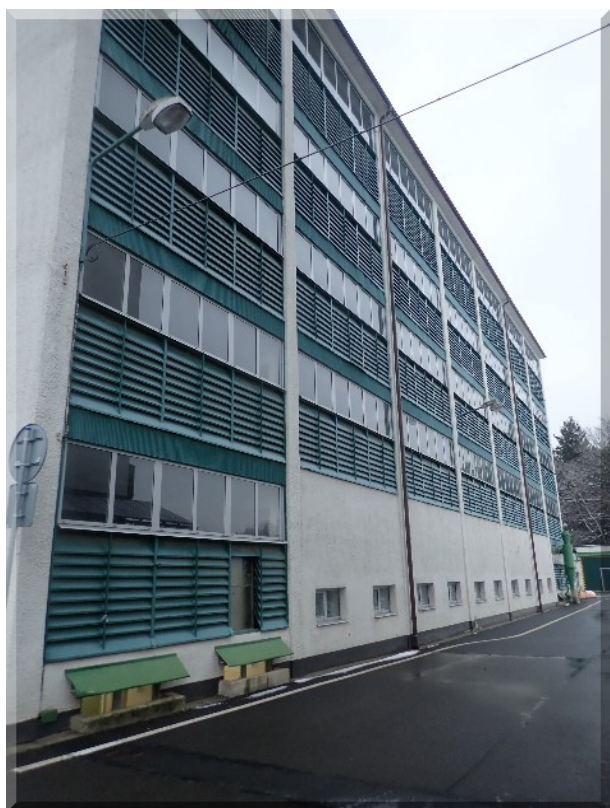
Foto PB266053: 02-r - sklad šišek - fixní ocelové žaluzie (4 stěny po celé výšce)
