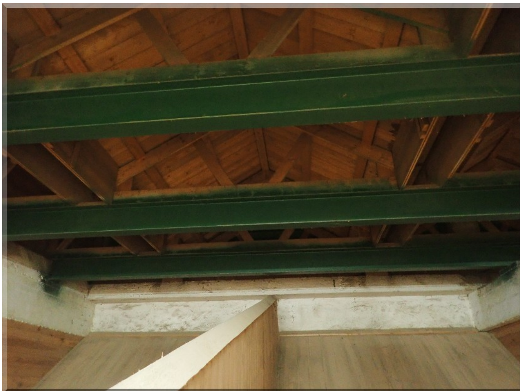
Foto PB266068: 02-g - sklad šišek - násypky v 1. NP až 5. NP (cca 20 násypek na každém patře)
