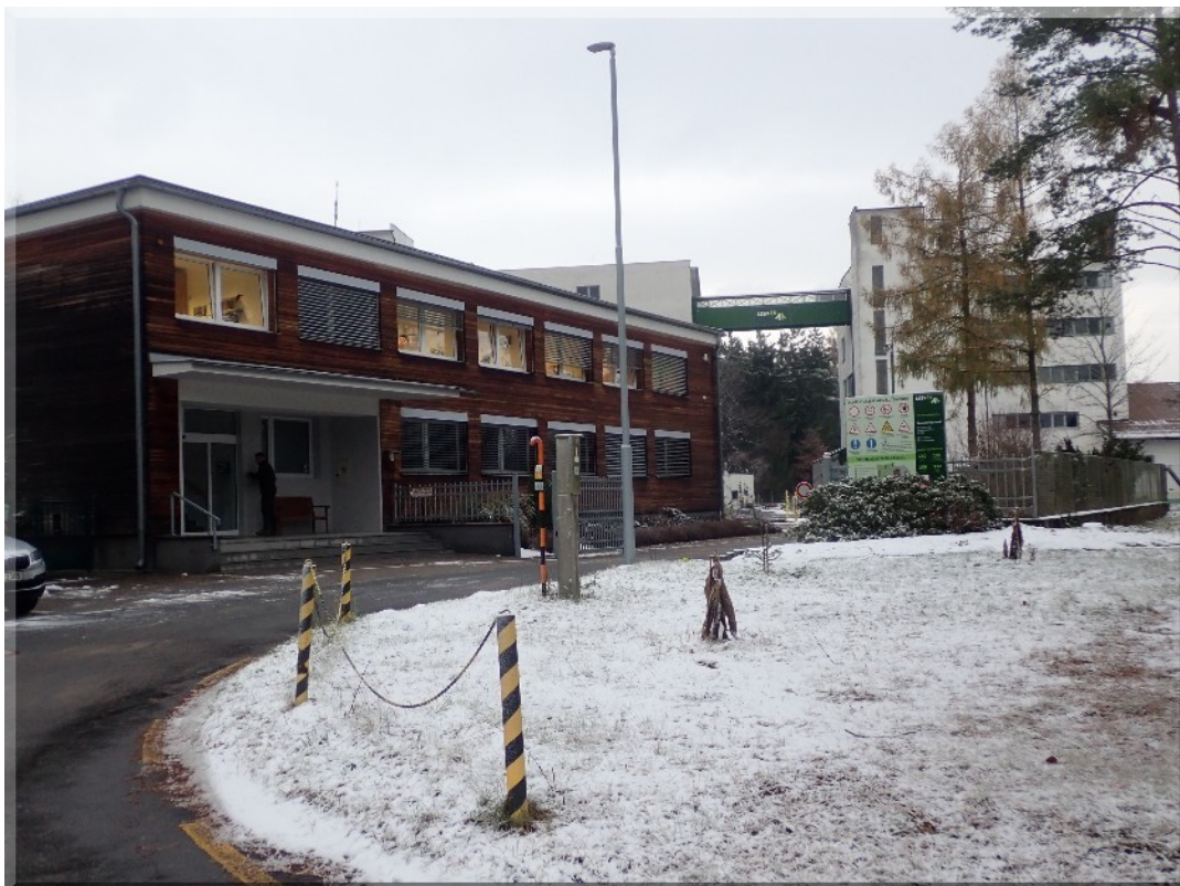
Foto PB266019: 09 - ostatní stavby (souhrn všech ostatních výše nezařazených objektů)
