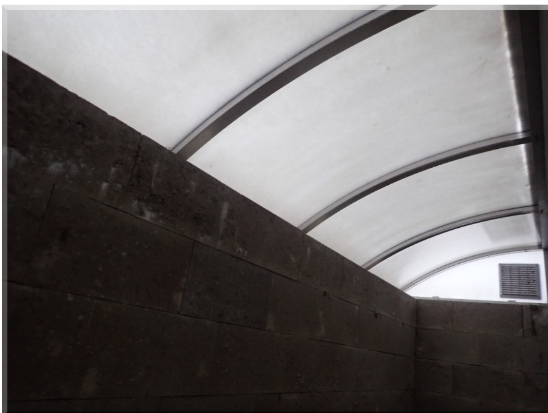
Foto PB266082: 02-s - sklad šišek - anglický dvorek na západní straně - pohled zevnitř (přístup ze sklepa)
