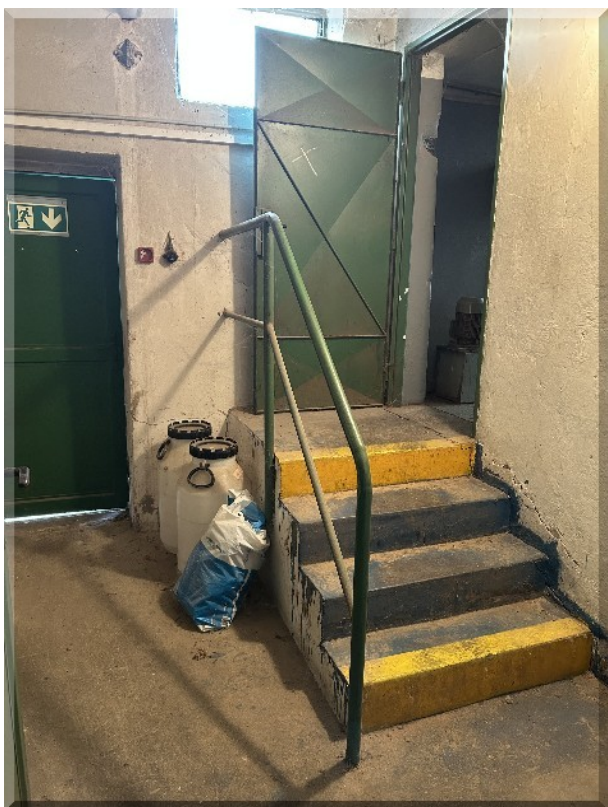
Foto schodiste_u_AKU_nadrzi: 05-f - kotelna - schodiště u vstupu k akumulčním nádržím (zábradlí na schodišti)
