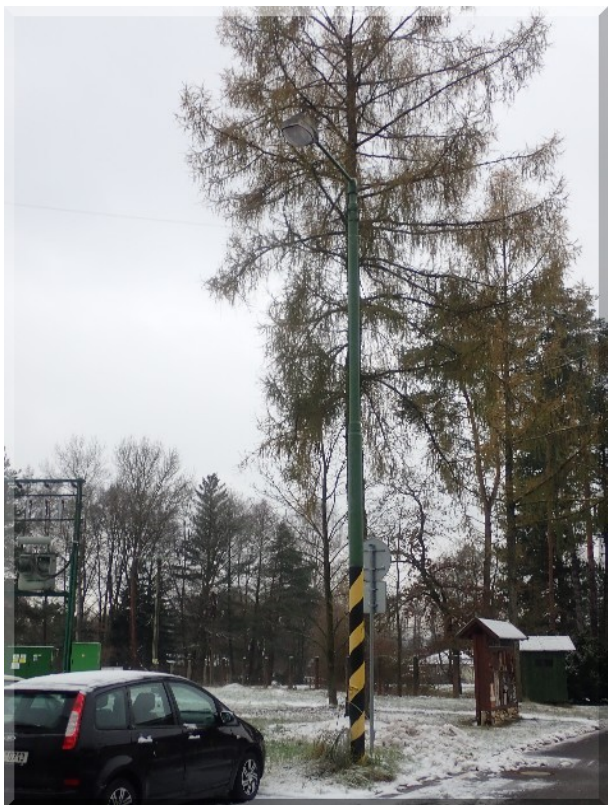
Foto PB266055: 09-i - ostatní stavby - sloupy pouličního osvětlení v areálu (cca 10 kusů + 6 výložníků na budovách)
