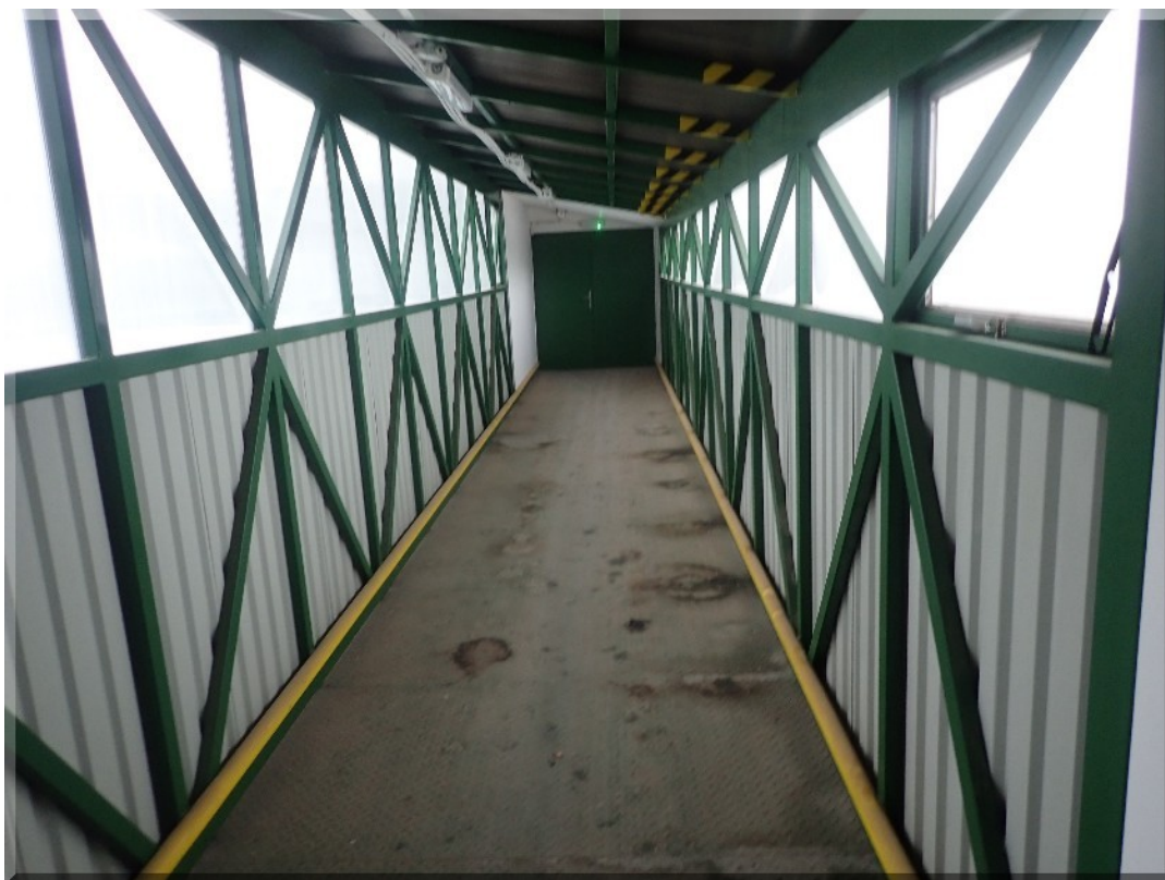
Foto PB266107: 04-c - luštírna - spojovací most (mezi luštírnou a skladem šišek v 5. NP)
