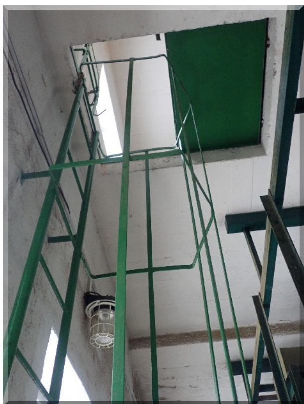
Foto PB266105: 02-a - sklad šišek - žebřík do strojovny výtahu s poklopem (5. NP)
