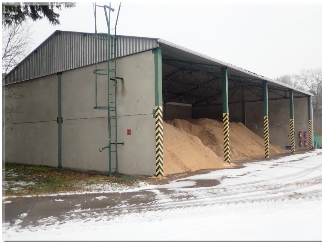
Foto PB266150: 09-l - ostatní stavby - sklad pilin - hlavní nosná konstrukce (cca 12 * 20 m)
