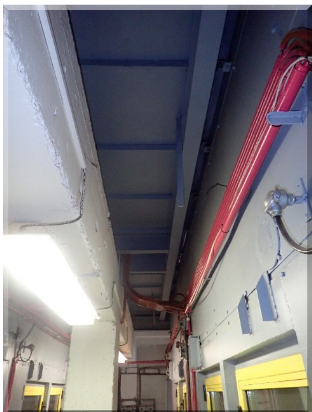
Foto PB266115: 04-d - luštírna - ocelové podlahy (cca 5 pater)
