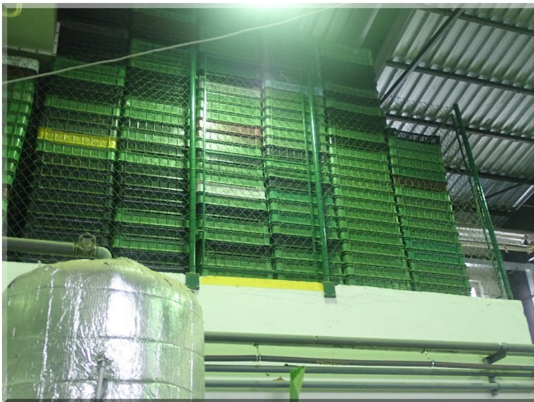
Foto PB266162: 06-c - mrazírenská hala - skladiště PVC přepravek (2 kusy, sloupky a branky na střeše vestavku)
