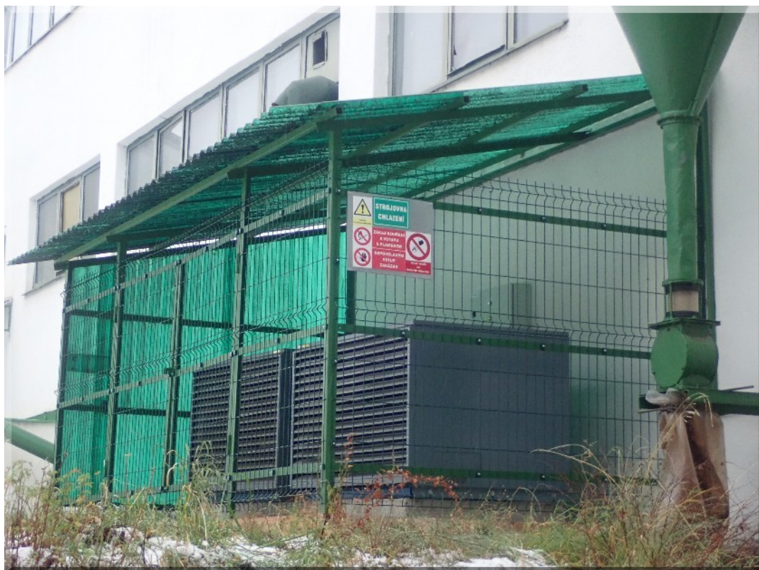
Foto PB266066: 04-k - lušτίrna - přístřešek nad chladícími agregáty boxu č. 6 (východní strana)
