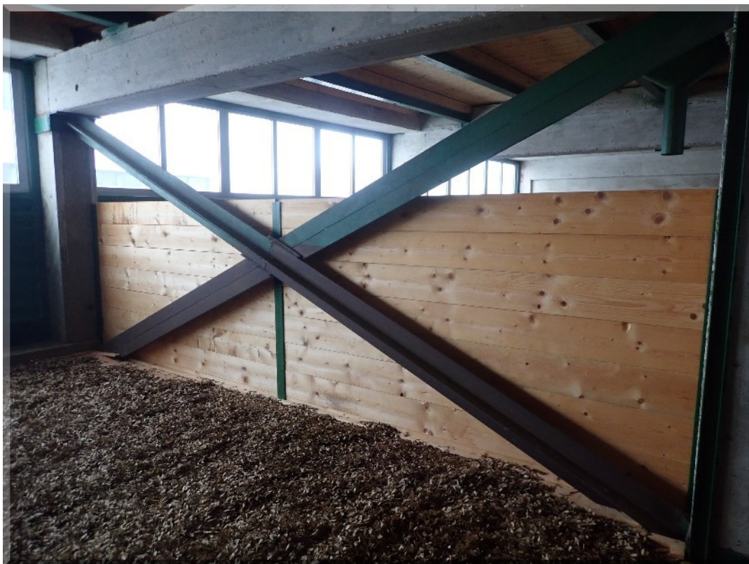
Foto PB266095: 02-i - sklad šišek - svislé ztužení budovy (cca 5 pater, na 4 místech v každém patře, vesměs skryto za dřevěným obložením)
