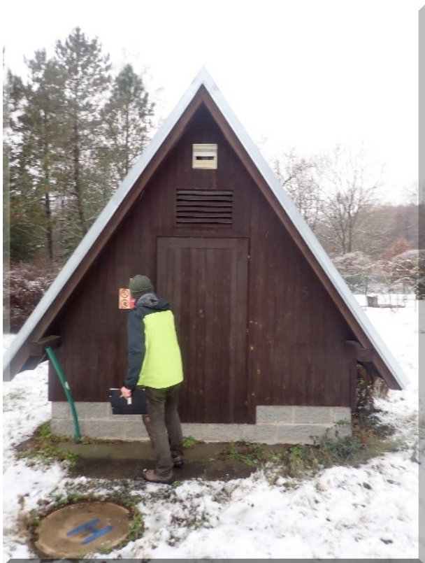
Foto PB266037: 09-b - ostatní stavby - čistírna odpadních vod - pohled zvenku (dvě patra plošin a žebřík)
