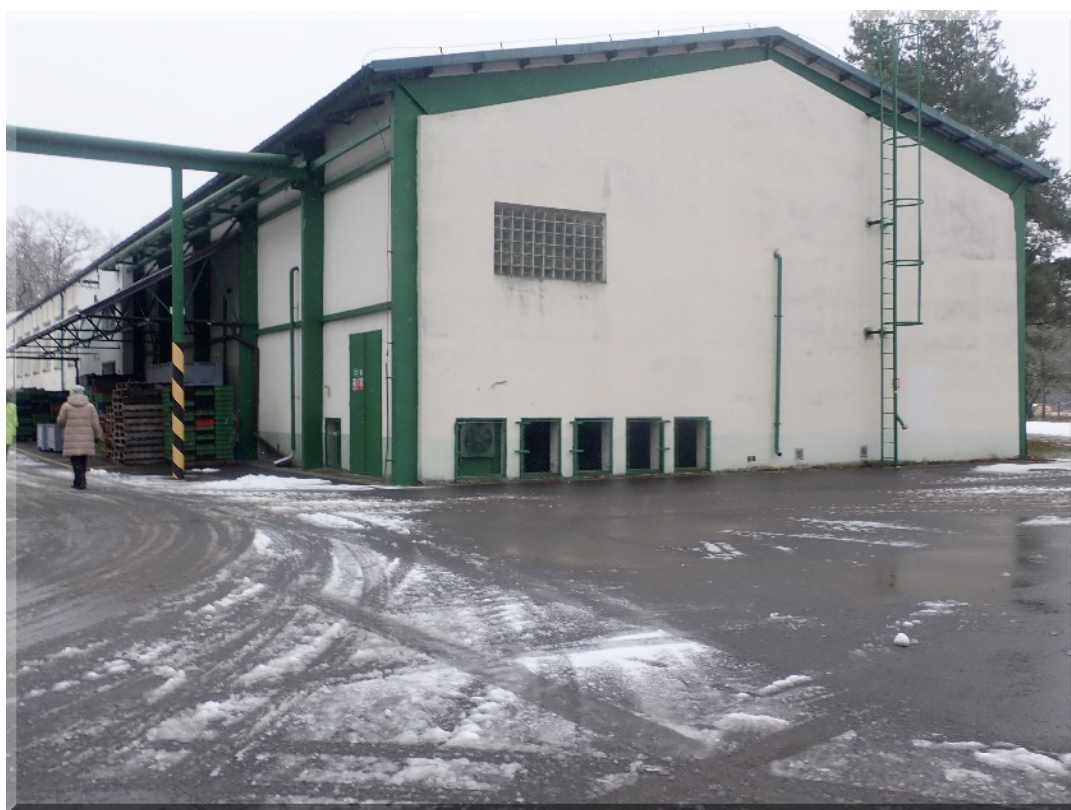
Foto PB266156: 06 - mrazírenská hala (část plnostěnné vazníky, část příhradová)
