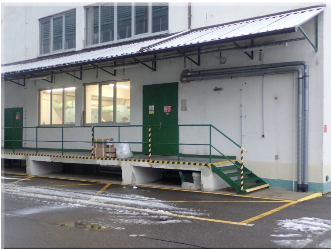
Foto PB266062: 04-i - luštírna - nakládací rampa vč. zábradlí, schodů a markýzy (severní strana)
