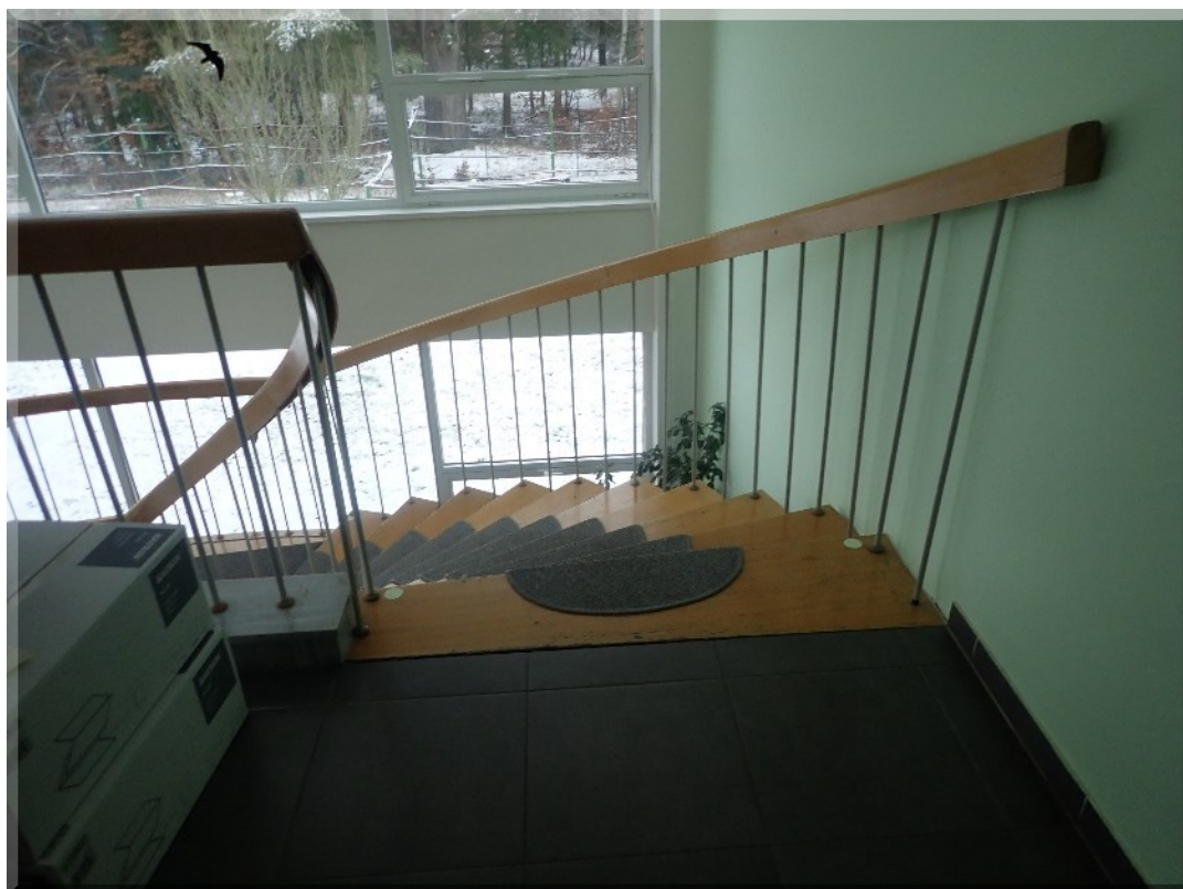
Foto PB266023: 01-b - administrativní budova - zábradlí schodiště (mezi přízemím a 1. patrem)
