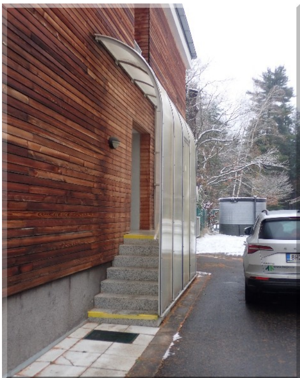
Foto PB266039: 01-a - administrativní budova - přístřešek u zadního vchodu (uvnitř areálu)
