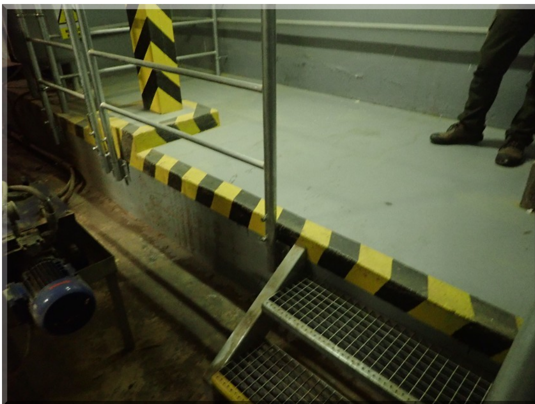
Foto PB266142: 05-c - kotelna - lávka, schody a zábradlí v suterénu - jiný pohled (lávky, cca 3 schodiště a zábradlí, částečně odnímatelné)
