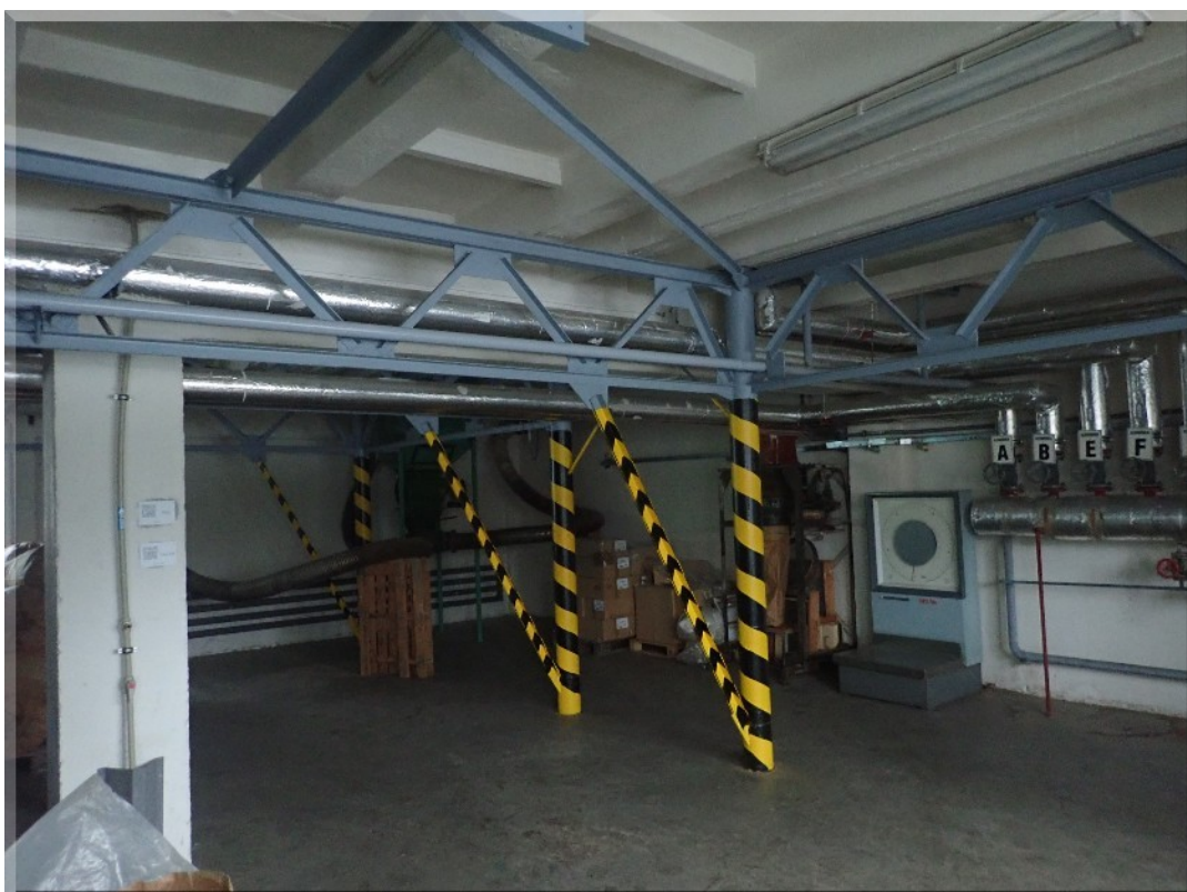
Foto PB266122: 04-f - luštírna - přízemí (konstrukce podepírající technologii)
