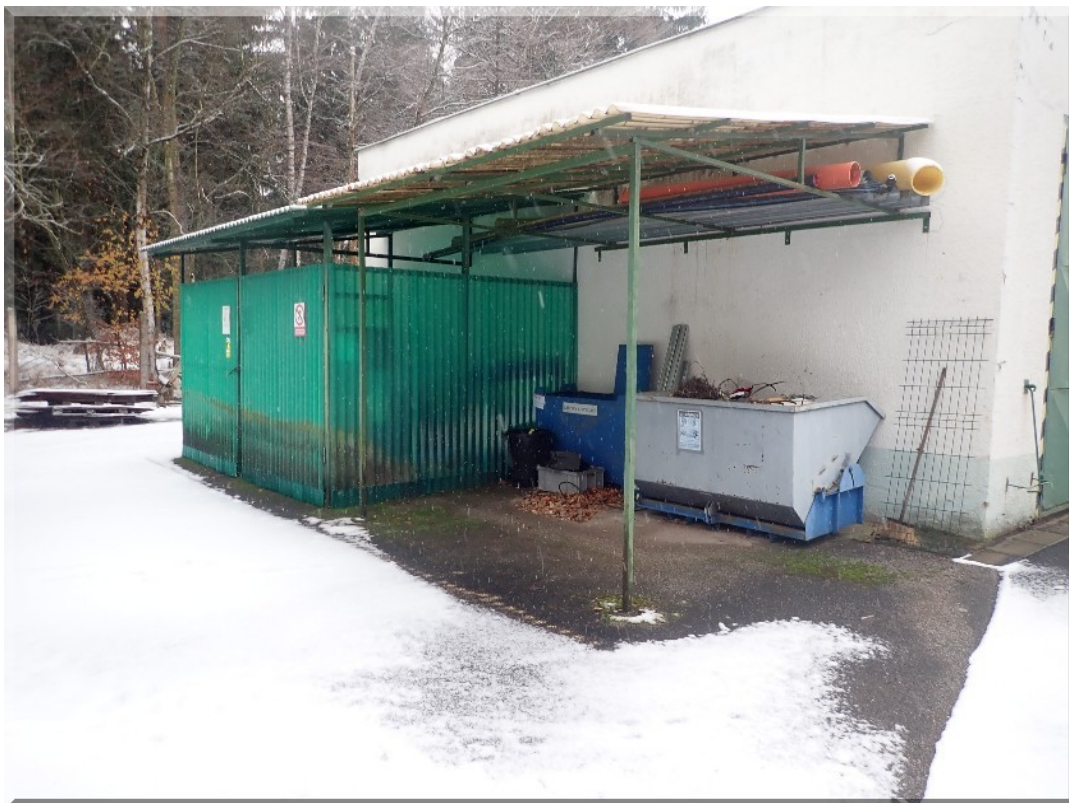
Foto PB266182: 03-a - dílna strojní údržby - přístřešek nebezpečných odpadů (severní strana)
