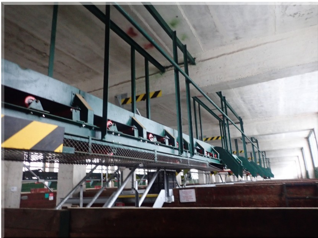
Foto PB266099: 02-b - sklad šišek - konstrukce zavěšení pásových dopravníků (5. NP, cca 200 m)
