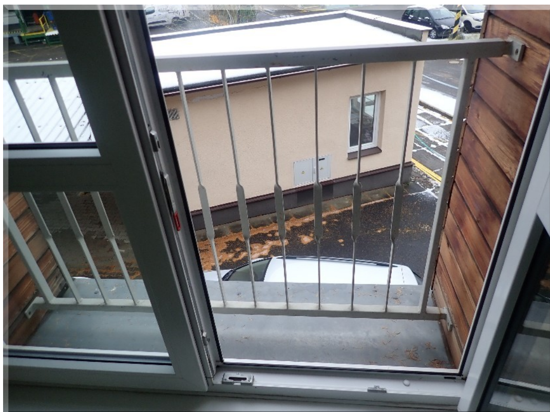
Foto PB266021: 01-c - administrativní budova - zábradlí francouzského okna (1. patro na konci chodby)
