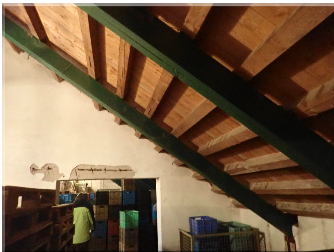
Foto PB266078: 02-p - sklad šišek - šikmé konstrukce násypek (ve sklepě)
