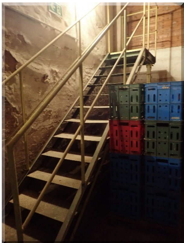
Foto PB266080: 02-q - sklad šišek - schodiště s podestou v 1. PP (severní část sklepa)
