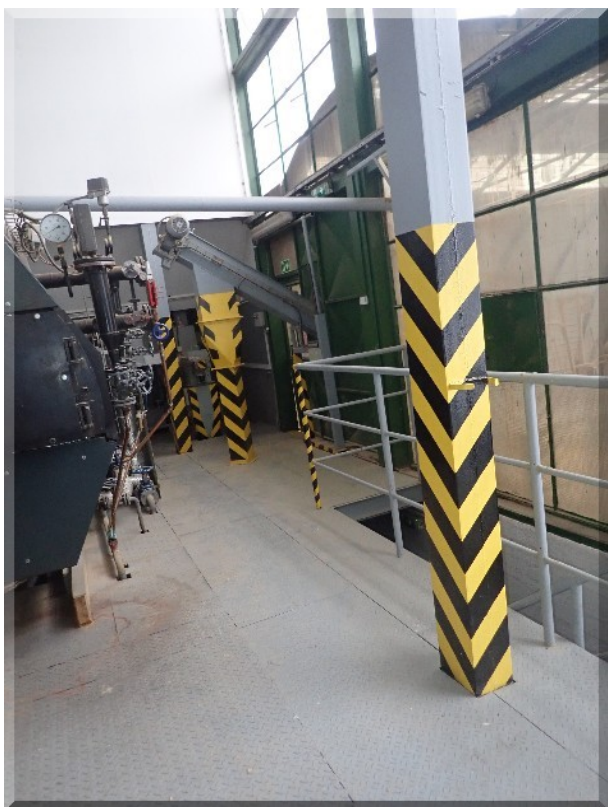
Foto PB266126: 05-a - kotelna - konstrukce přízemí a suterén - pohled shora (hlavní nosná konstrukce)
