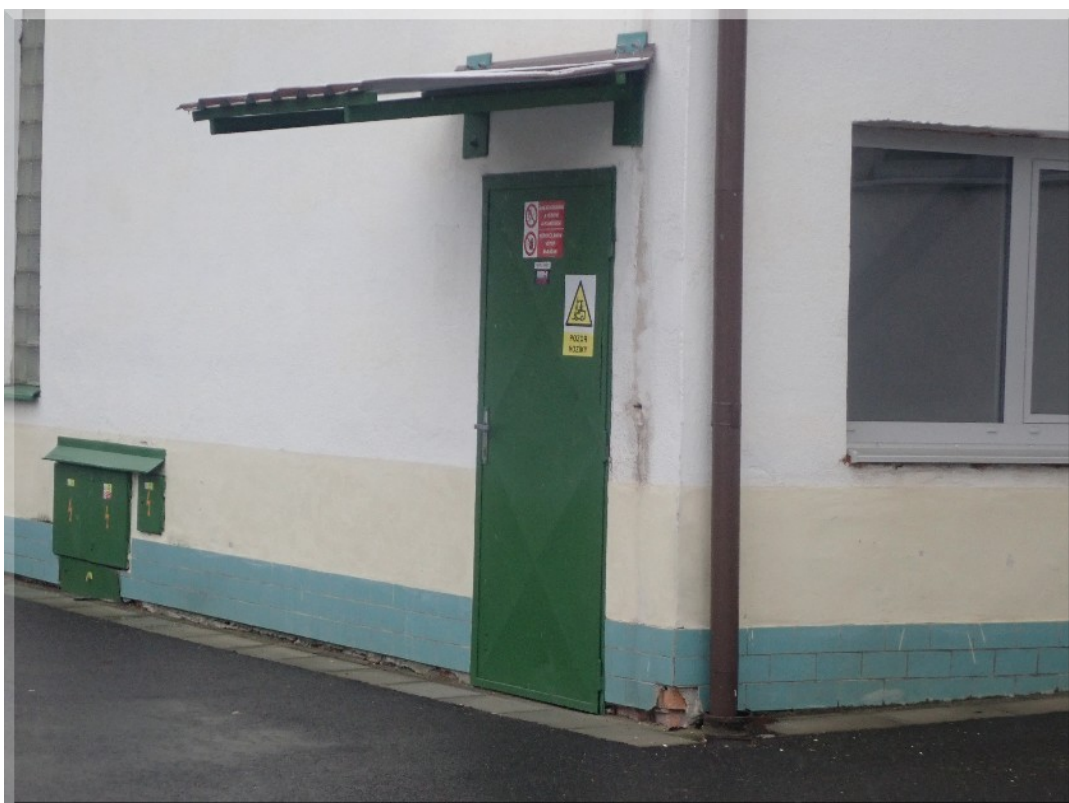
Foto PB266148: 04-h - lušτίrna - markýza před vstupem na schodiště (západní strana)
