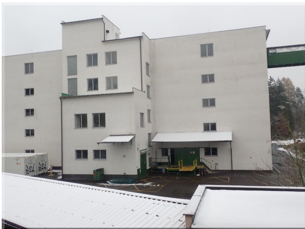
Foto PB266198: 02 - sklad šišek (rozměry cca 42 * 44 m, 5 NP, hlavní nosná konstrukce železobetonová s ocelovými ztužidly)
