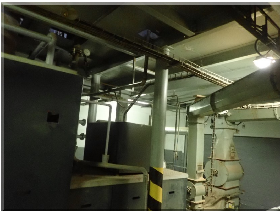
Foto PB266140: 05-a - kotelna - konstrukce přízemí a suterén (hlavní nosná konstrukce)
