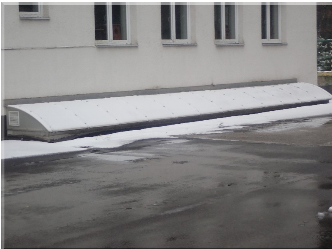
Foto PB266180: 02-x - sklad šišek - anglický dvorek na východní straně (přístup ze sklepa)
