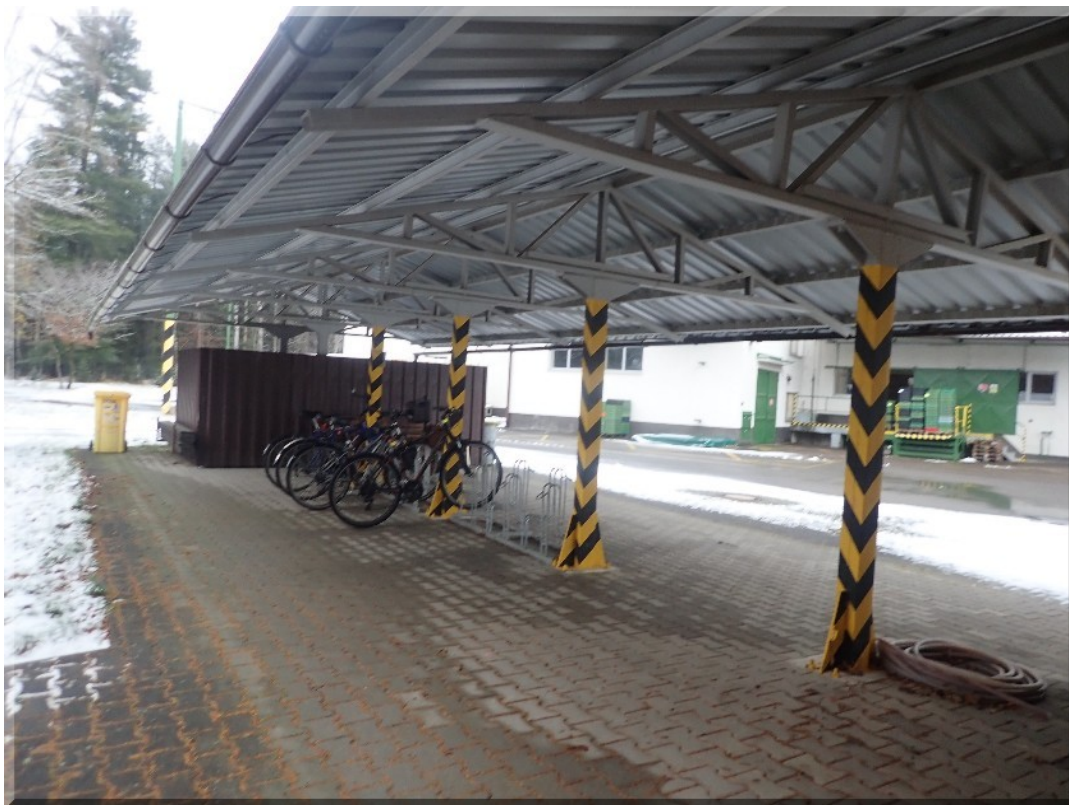
Foto PB266043: 09-h - ostatní stavby - přístřešek na kola (cca 8 * 15 m, jeho součástí je i objekt popelnic)
