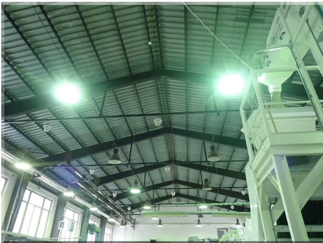
Foto PB266164: 06-a - mrazírenská hala - hlavní nosná konstrukce (cca 18 * 88 m)
