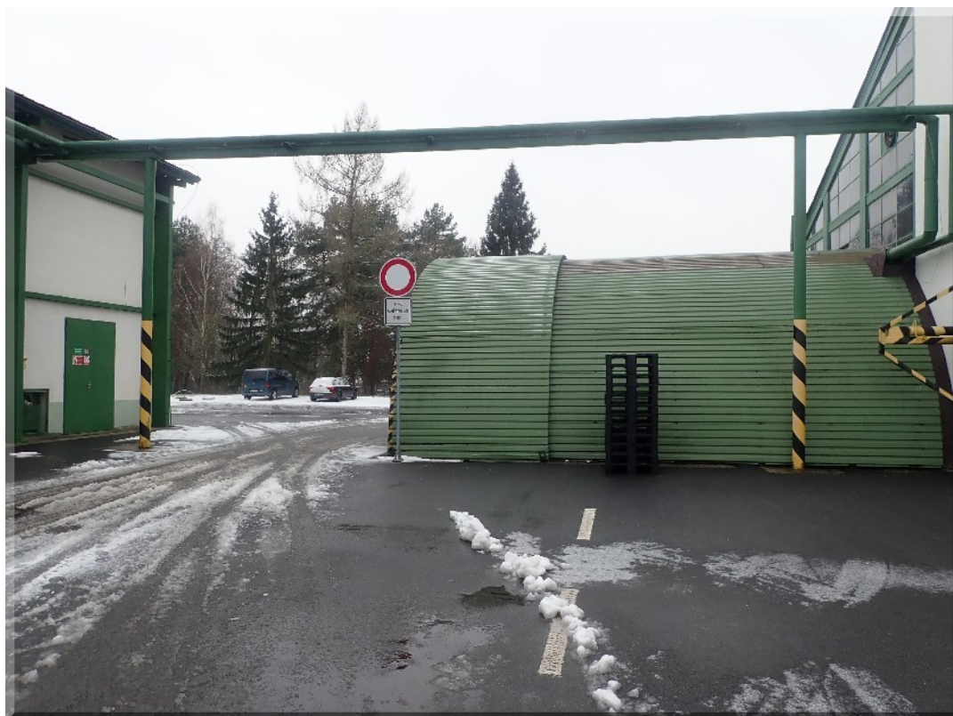
Foto PB266144: 09-j - ostatní stavby - parovod (cca 16 m potrubního mostu)
