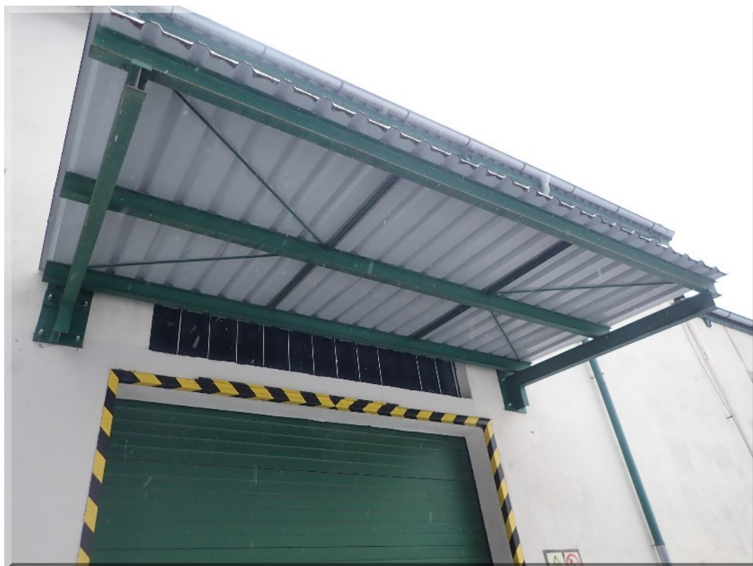
Foto PB266168: 06-e - mrazírenská hala - východní markýza (pouze zastřešení)
