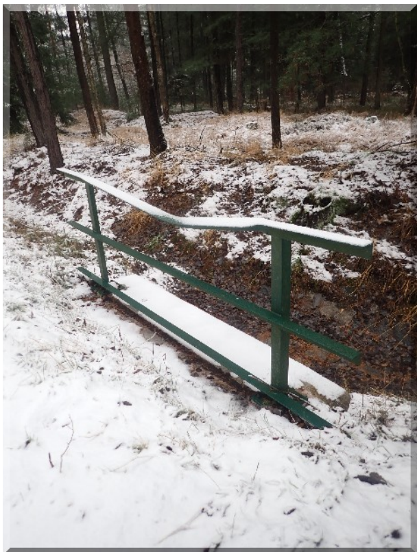
Foto PB266190: 09-n - ostatní stavby - zábradlí propustku za branou za skladem šišek (bývalá železniční vlečka, za branou do lesa mimo areál)
