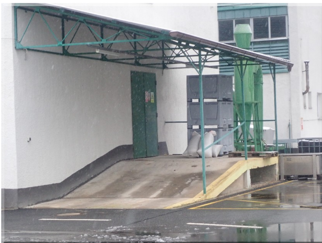
Foto PB266176: 02-w - sklad šišek - markýza a zábradlí rampy (východní strana)
