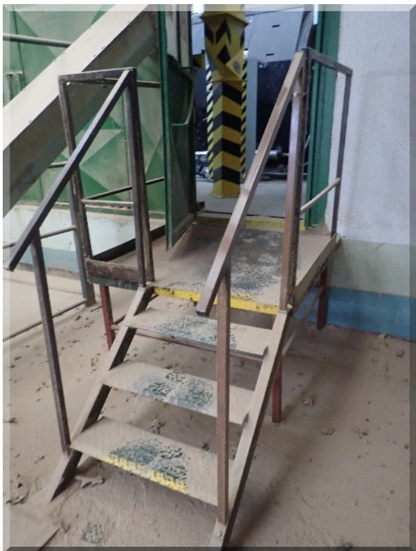
Foto PB266128: 05-d - kotelna - schodiště s podestou ze skladu pilin do kotelny (před kotelnou)
