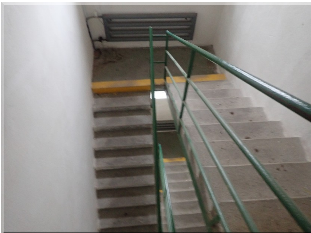
Foto PB266113: 04-e - luštírna - centrální schodiště vč. zábradlí (cca 5 pater)
