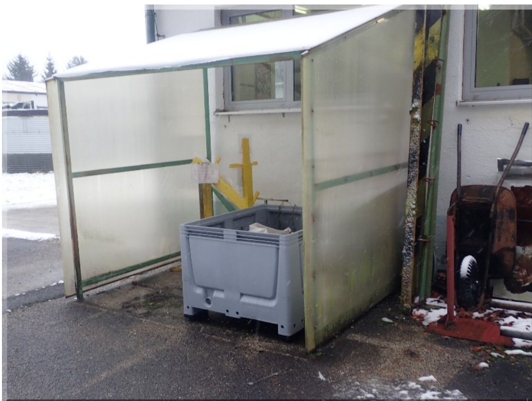
Foto PB266184: 03-b - dílna strojní údržby - mobilní přístřešek (východní strana)
