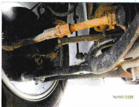
foto č.15 – pohled na zavěšení předního kola s manžetou kloubu řízení
