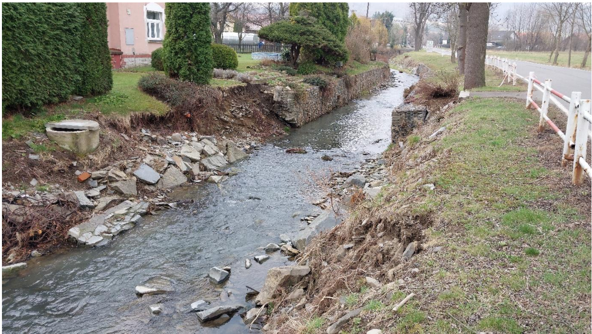
Kobylí potok km 3,270-5,600 (PŠ 2024)
