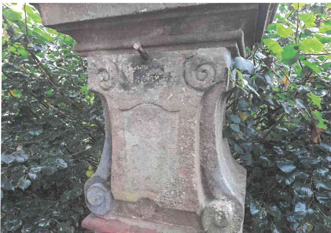
Detail podstavce s ocelovým čepem, na kterém byla osazená kamenná kartuš.
