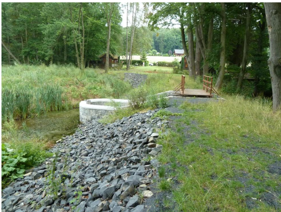
Obr. 1 Zátoka rybníka zůstala při rekonstrukci neodbahněná
