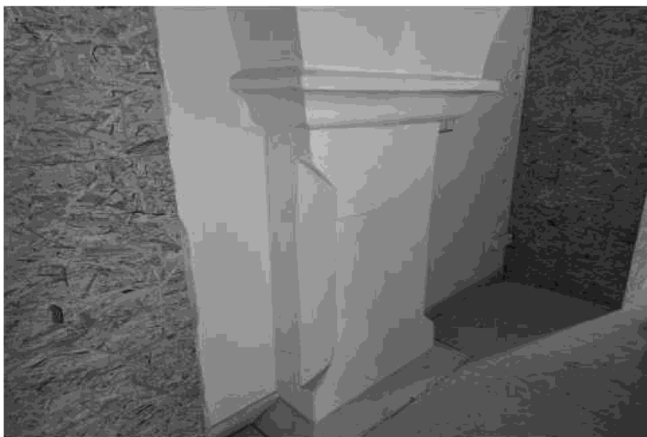
Zazděný sloup č. 5
