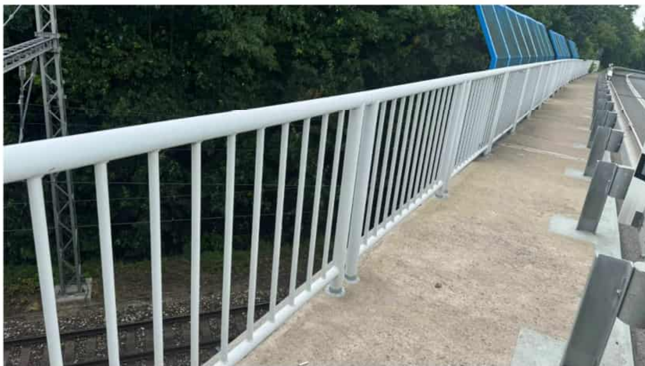
Obr. 4 – svodidla – obnova PKO – 30,0 m
