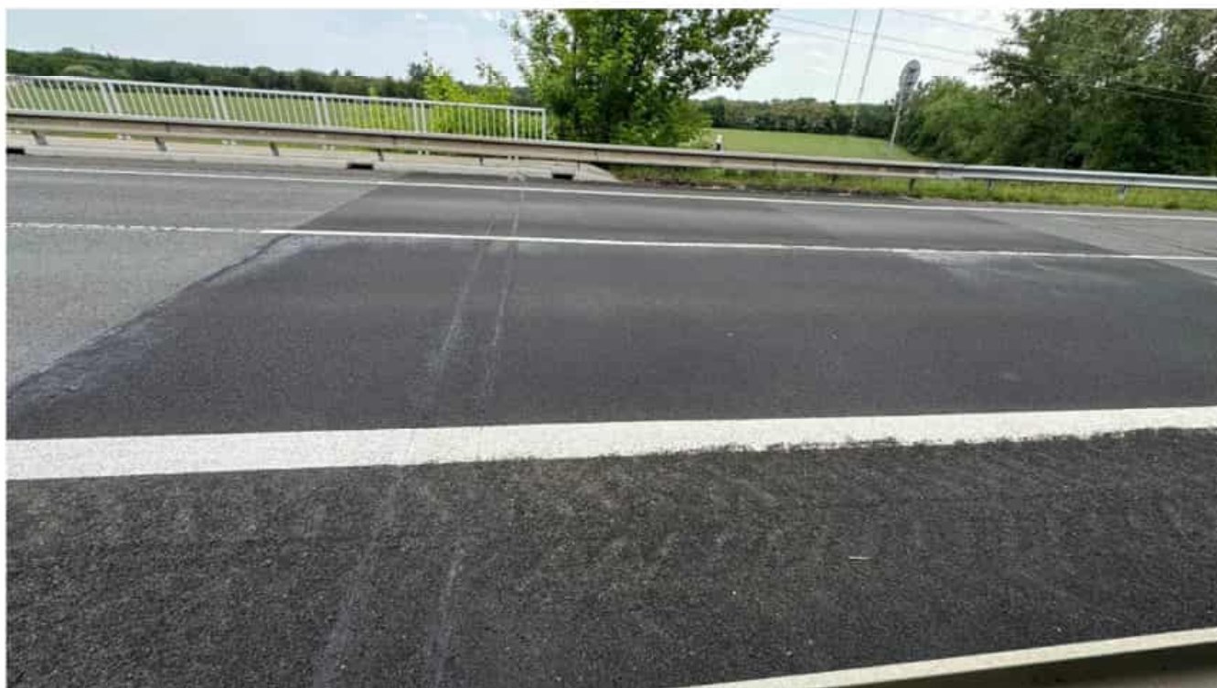
Obr. 6 - oprava stávajících MZ - 240,0 m 2
