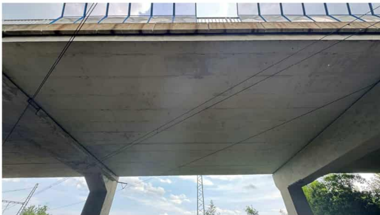
Obr. 2 – reprofilace vodorovných ploch sanační maltou – 11,250 m 2
