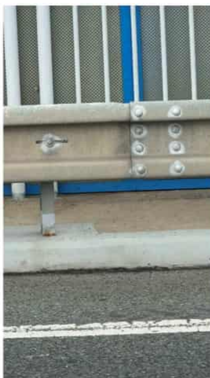
Obr. 4 – svodidla – obnova PKO – 30,0 m
