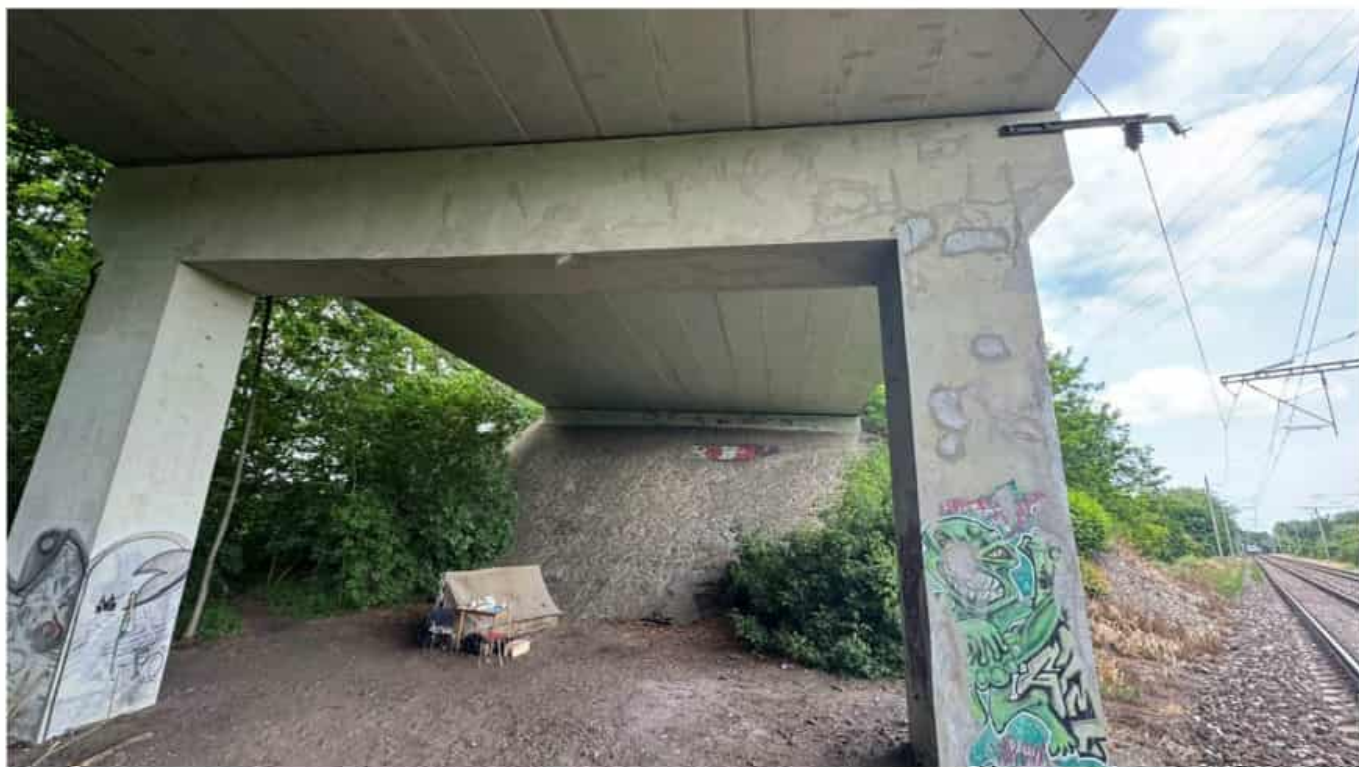
Obr. 8 – reprofilace podhledů sanační maltou – 5,250 m2 (ZBV)
