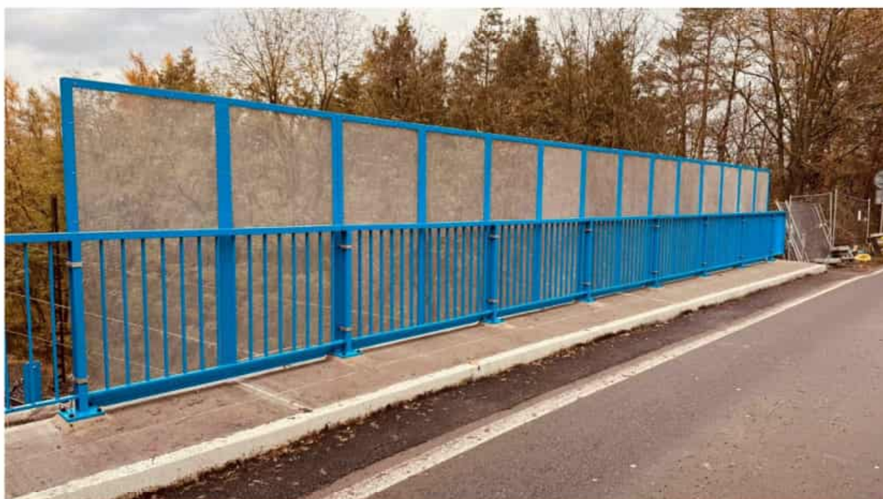
Obr. 8 – protidotykové zábrany – 60,0 m 2
