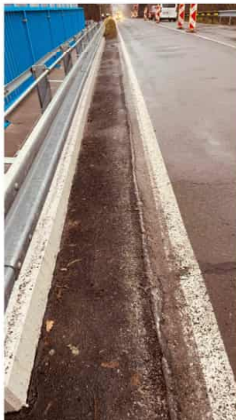
Obr. 10 – doplnění odvodňovacího pruhu živice – 19,2 m2 (ZBV)
