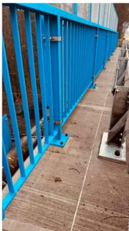
Obr. 8 – protidotykové zábrany – 60,0 m 2
