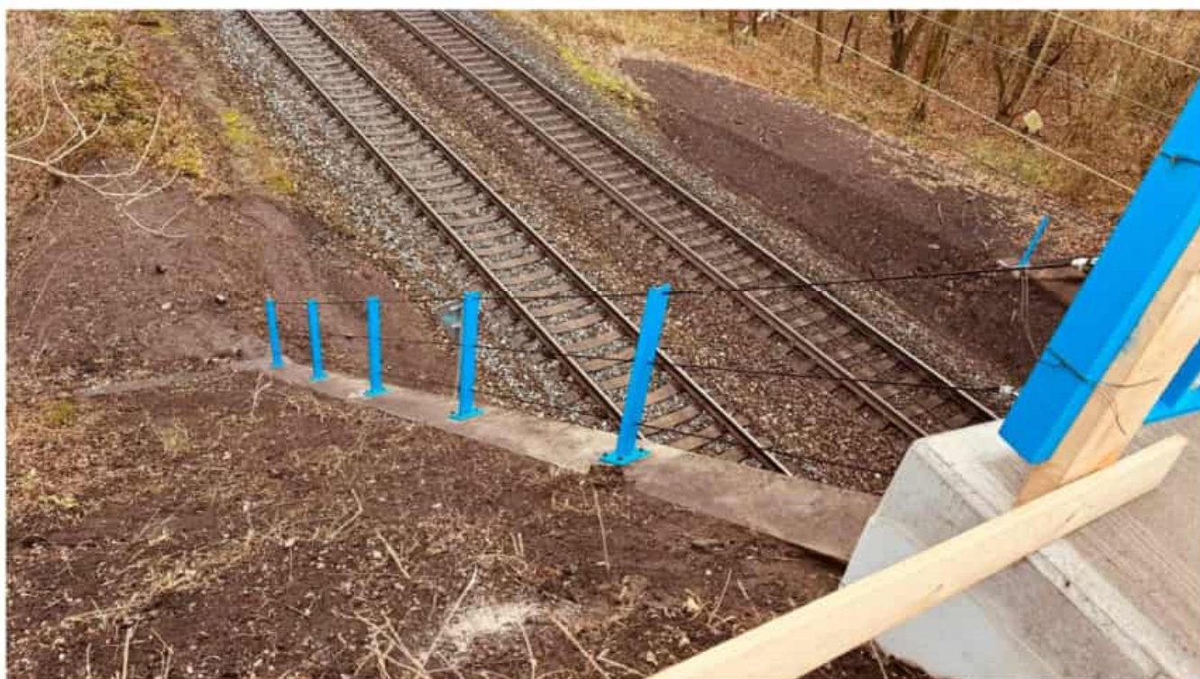
Obr. 6 – svodidlo mostní jednostranné – 62,0 m (ZBV)
