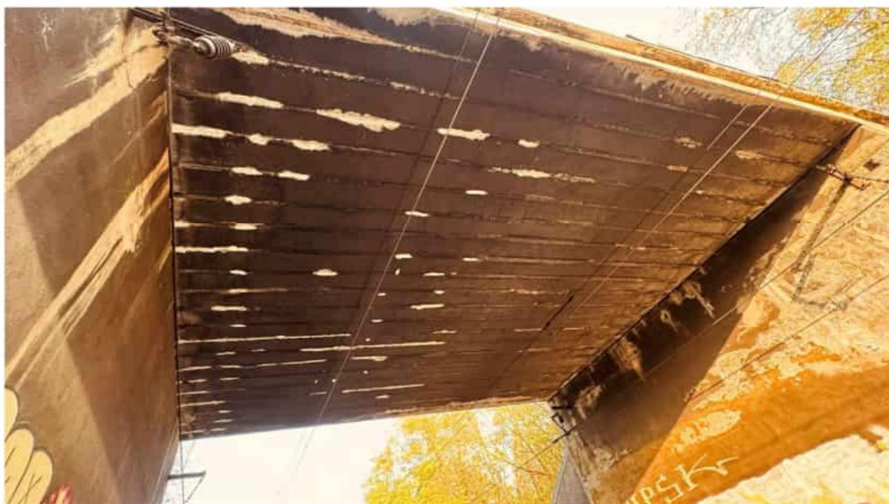
Obr. 3 – reprofilace podhledů cementovou maltou do 20mm – 10,4 m 2
