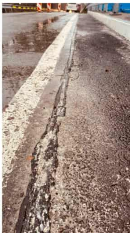
Obr. 11 - doplnění těsnících zál. podél říms – 68,0 m (ZBV)
