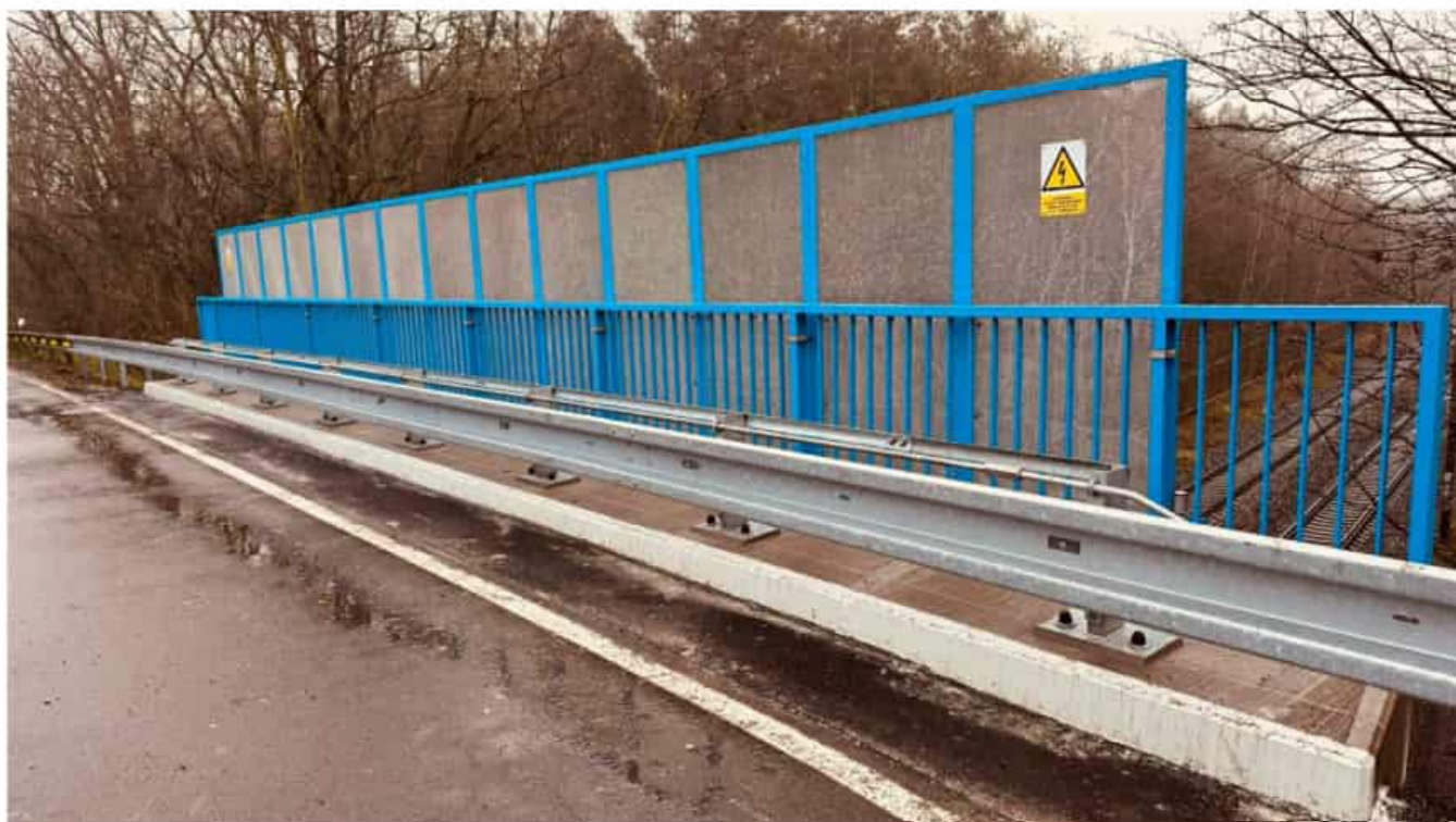
Obr. 6 – svodidlo mostní jednostranné – 62,0 m (ZBV)
