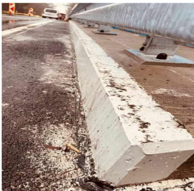
Obr. 4 – nátěr odrazné hrany římsy – 10,2 m 2
