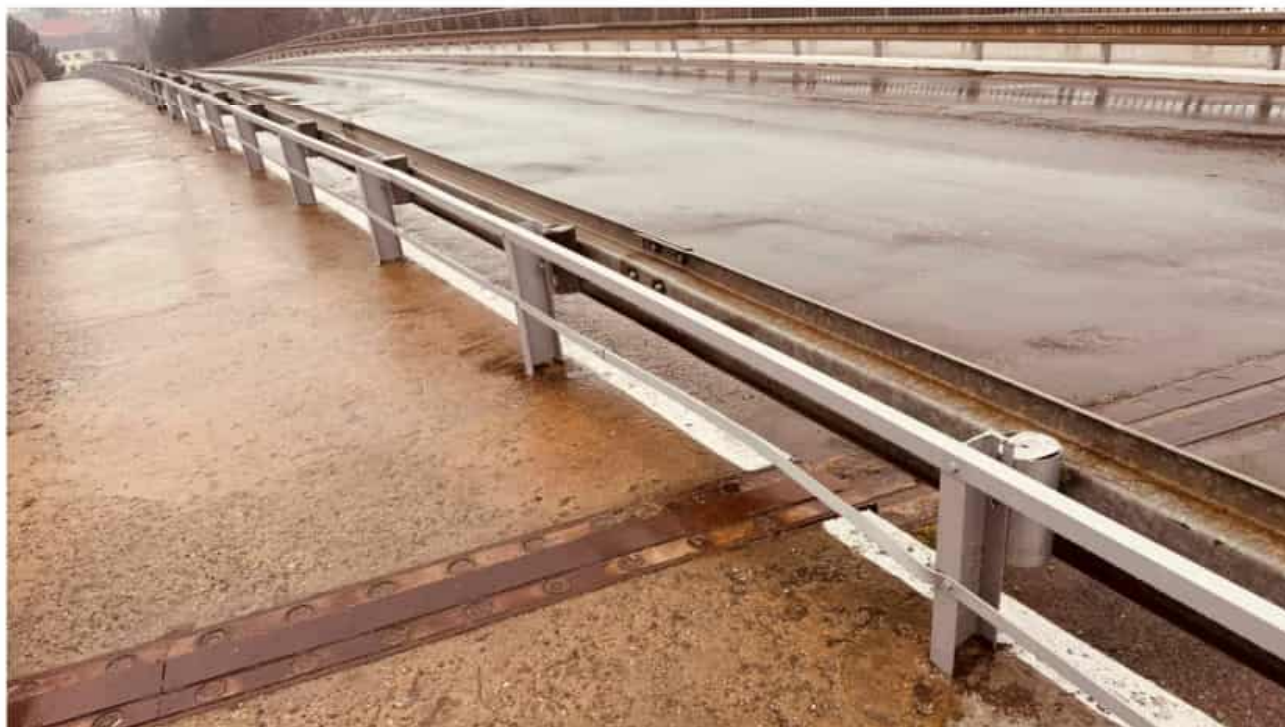
Obr. 6 – svodidlo mostní – obnova PKO, spoj.mat. – 88,0 m
