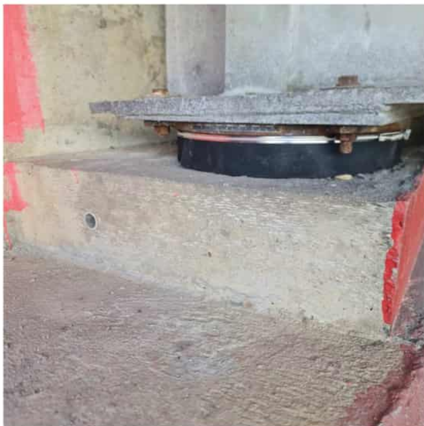
Obr. 9 – repase ložisek – čištění ÚP + výměna prachovek - 12ks (ZBV)
