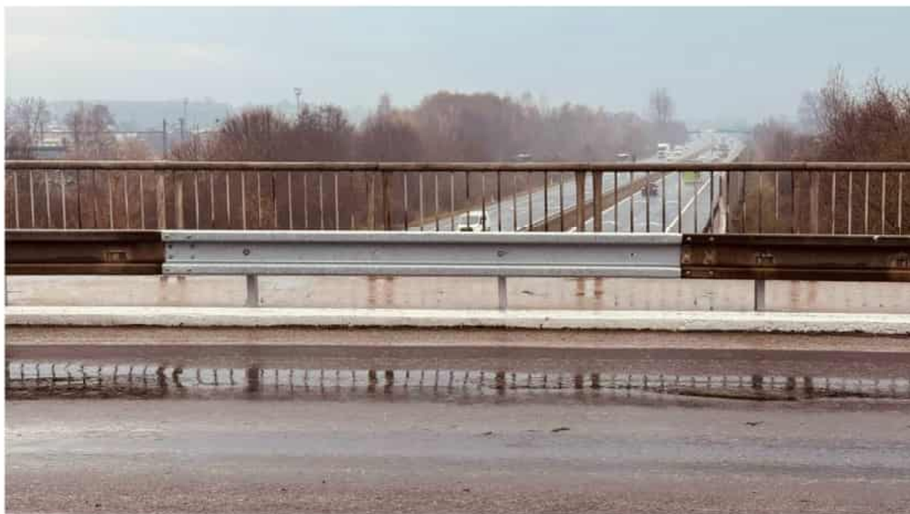
Obr. 6 – svodidlo mostní – obnova PKO, spoj.mat. – 88,0 m
