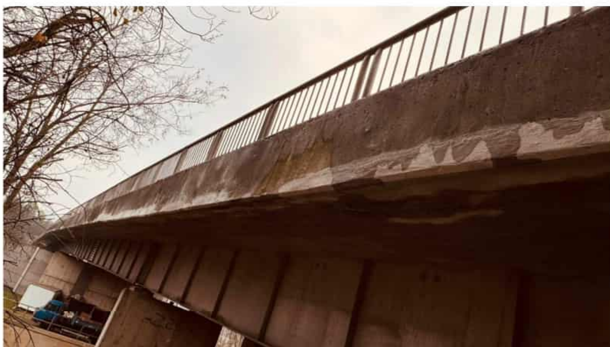
Obr. 2 - reprofilace podhledů svislých ploch – 96,8 m 2
