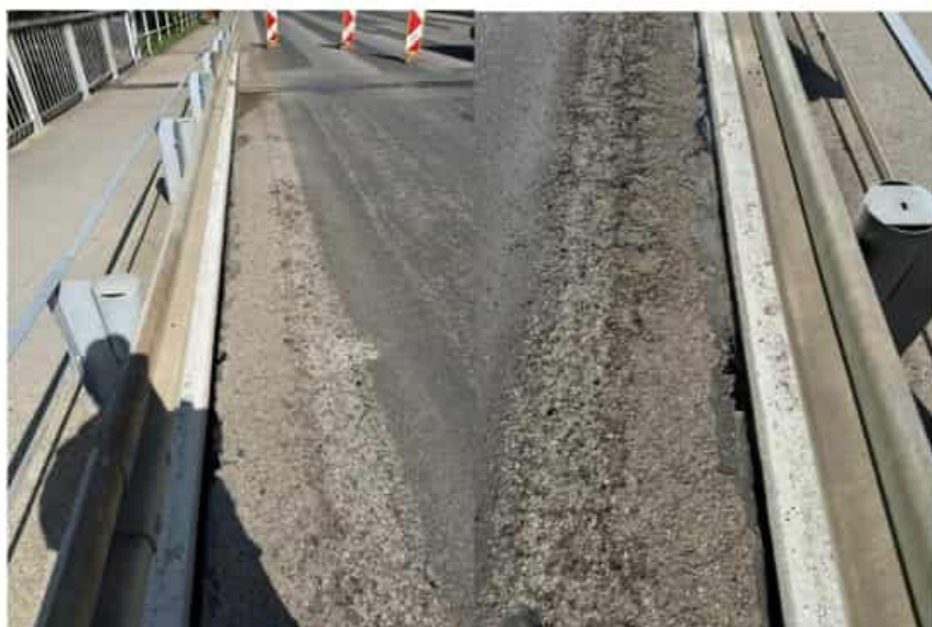
Obr. 10 – oprava asfaltových zálivek podél říms + MZ – 336,0 m (ZBV)
