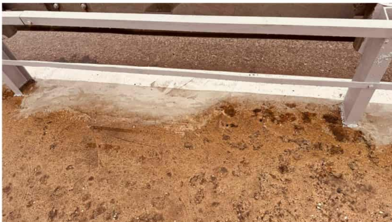
Obr. 4 – nátěry betonových kcí typ S4 (OS-C) – 66,0 m 2
