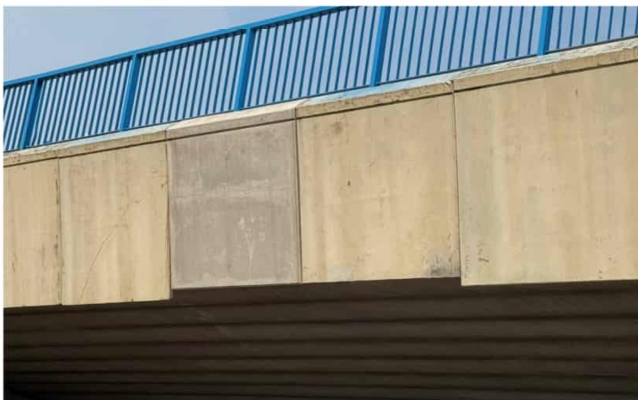
Obr. 4 – nový lícový prefabrikát - 0,811 m 3 (ZBV)
