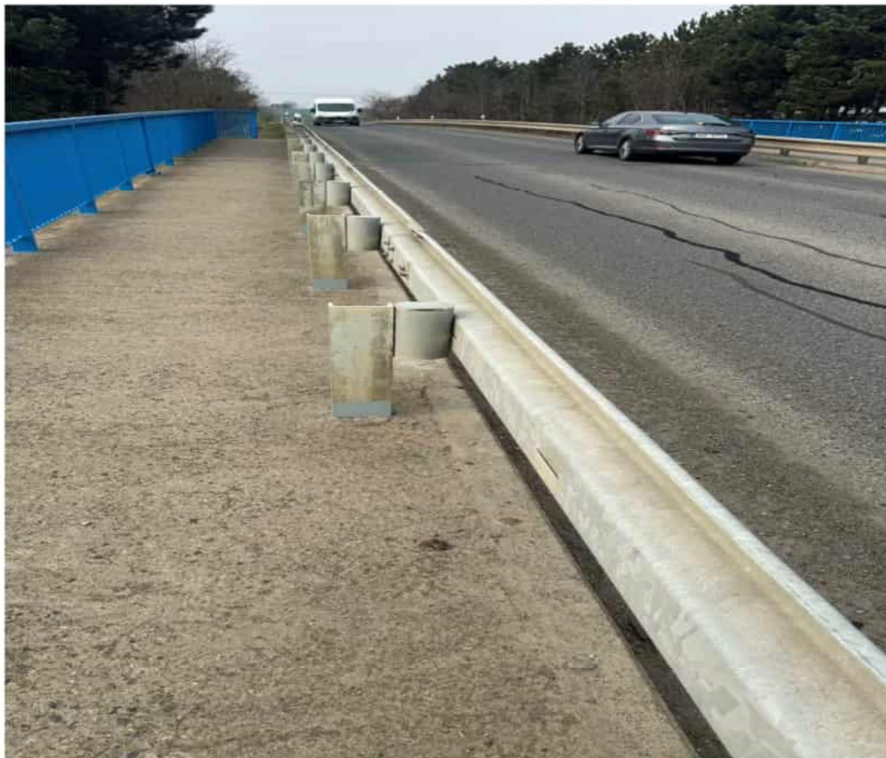
Obr. 5 – svodidlo oprava PKO + spoj.mat. – 9m
