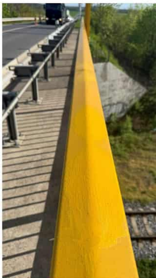
Obr. 4 – zábradlí mostní – obnova PKO – 15,0 m
