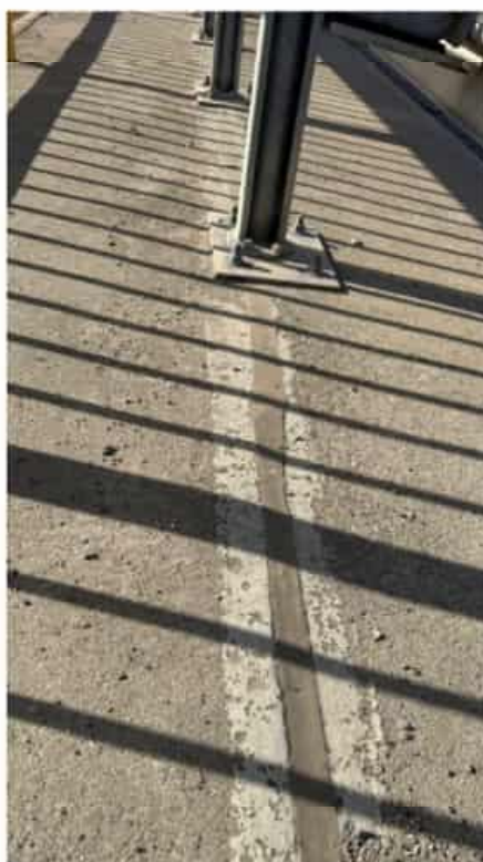
Obr. 6 – těsnění dilatačních spár – 20,0 m
