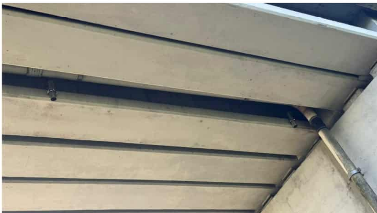
Obr. 8 – mostní odvodňovací trubka – 24,0 ks
