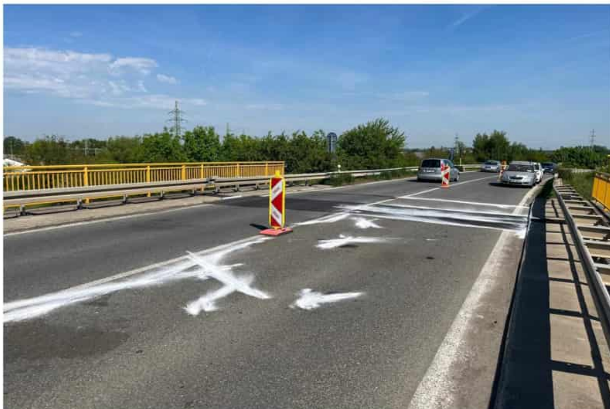
Obr. 10 – doplnění těsnících zál. podél říms + otevřených spár ve vozovce - 198,0 m (ZBV)
