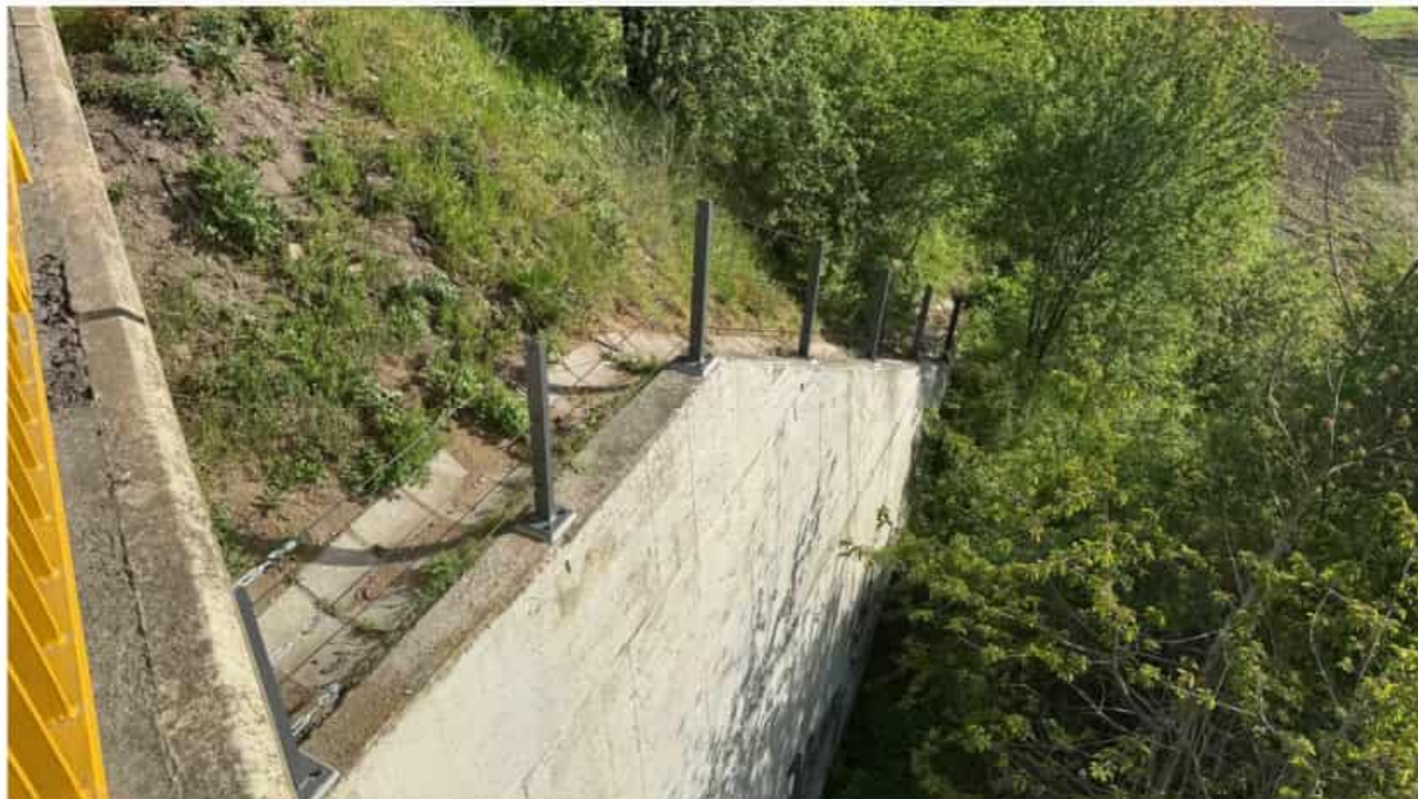
Obr. 3 – zábradlí lankové – 40,0 m
