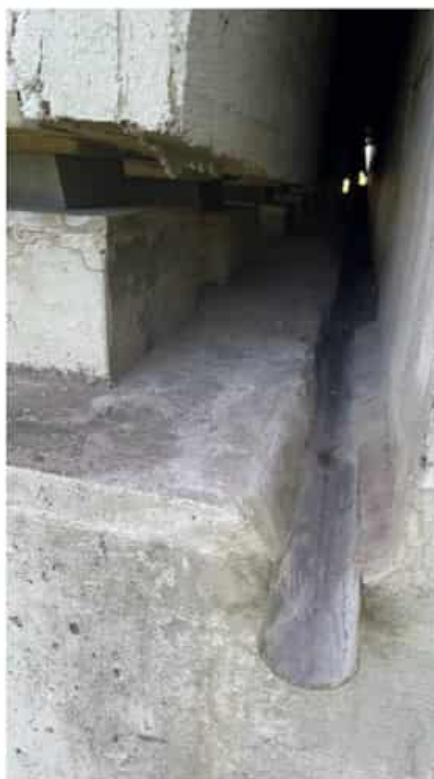
Obr. 8 – mostní odvodňovací trubka – 24,0 ks
