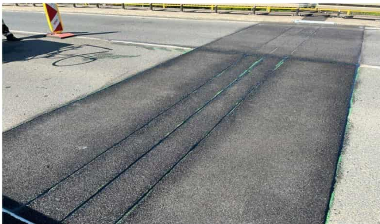
Obr. 11 – oprava stávajících EMZ – 50,0 m 2 (ZBV)
