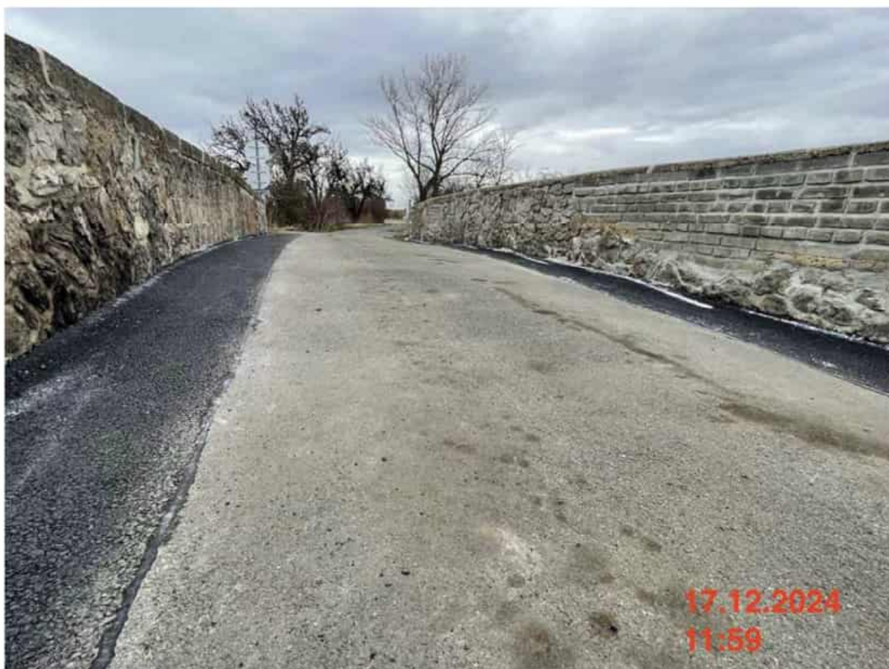
Obr. 5 – přespárování parapetních zídek – 43,6 m 2 (ZBV)
