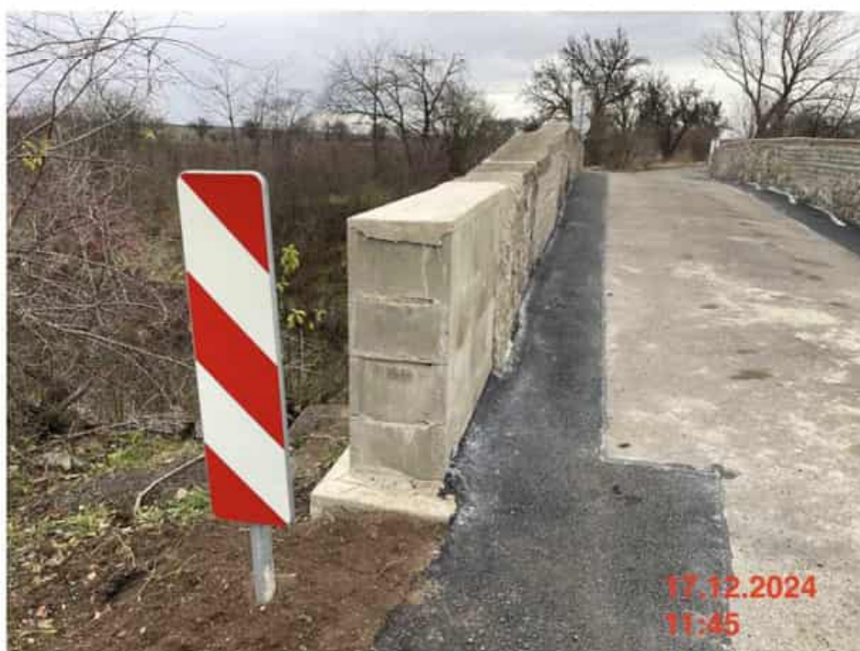
Obr. 4 – doplnění asfaltových zálivek – 98,0 m (ZBV)
