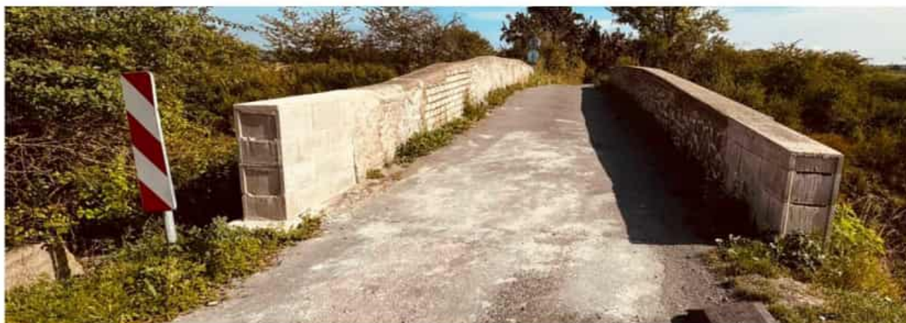
Obr. 6 – dozdění konce parapetní zídky – 0,780 m 3 (ZBV)
