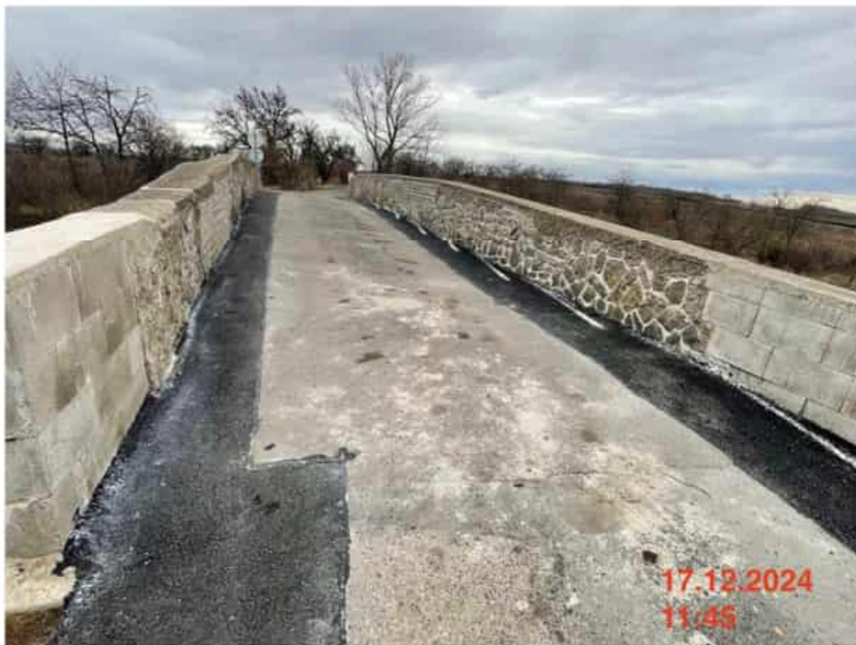
Obr. 4 – doplnění asfaltových zálivek – 98,0 m (ZBV)
