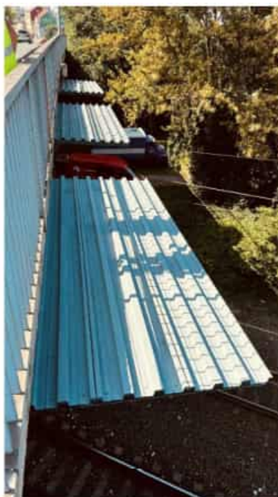
Obr. 2 – oprava PKO protidotykové zábrany – 54,0 m 2
