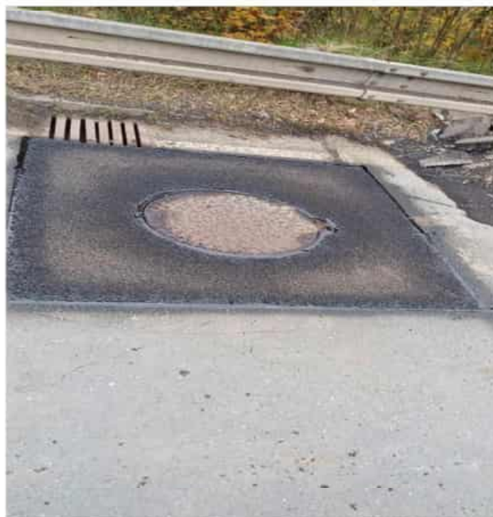
Obr. 8 – vyrovnání kanalizační šachty – 1 ks (ZBV)
