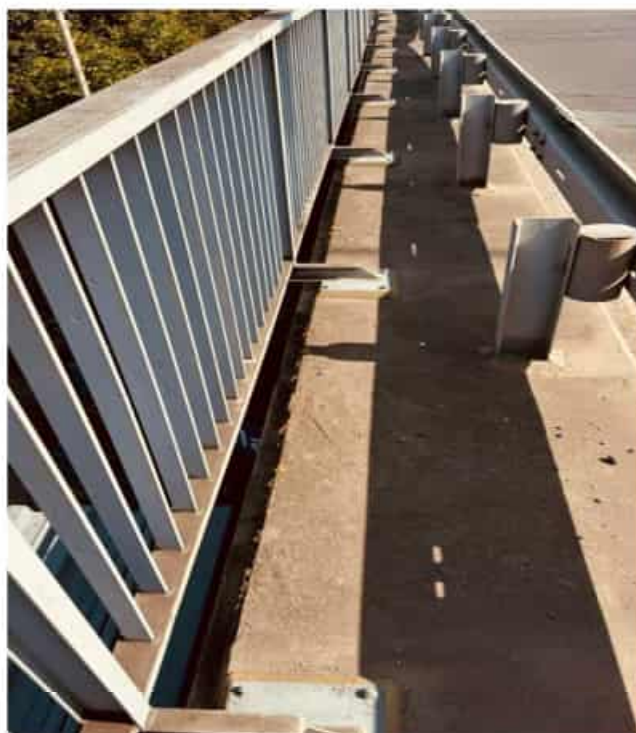
Obr. 10 – oprava epoxidové výplně patek sloupků zábradlí + svodidel – 48ks + 46ks (ZBV)
