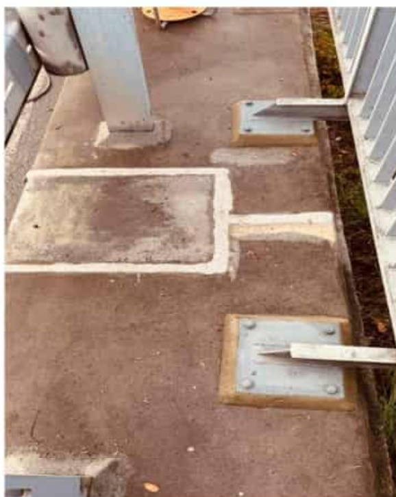
Obr. 6 – těsnění spár polyuretanovým tmelem – 20,0 m
