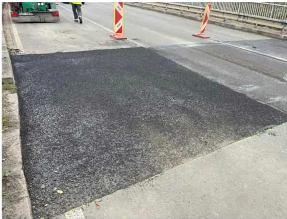
Obr. 7 – oprava MZ – 54,0 m 2 (ZBV)
