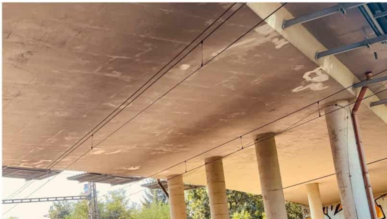
Obr. 2 – oprava PKO protidotykové zábrany – 54,0 m 2
