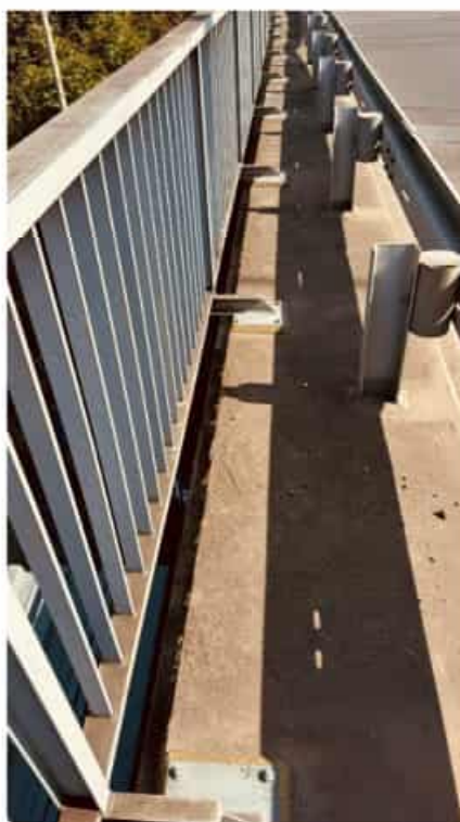
Obr. 3 – zábradlí mostní – obnova PKO – 22 m
