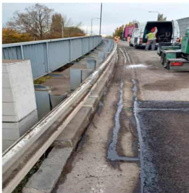
Obr. 10 – oprava epoxidové výplně patek sloupků zábradlí + svodidel – 48ks + 46ks (ZBV)
