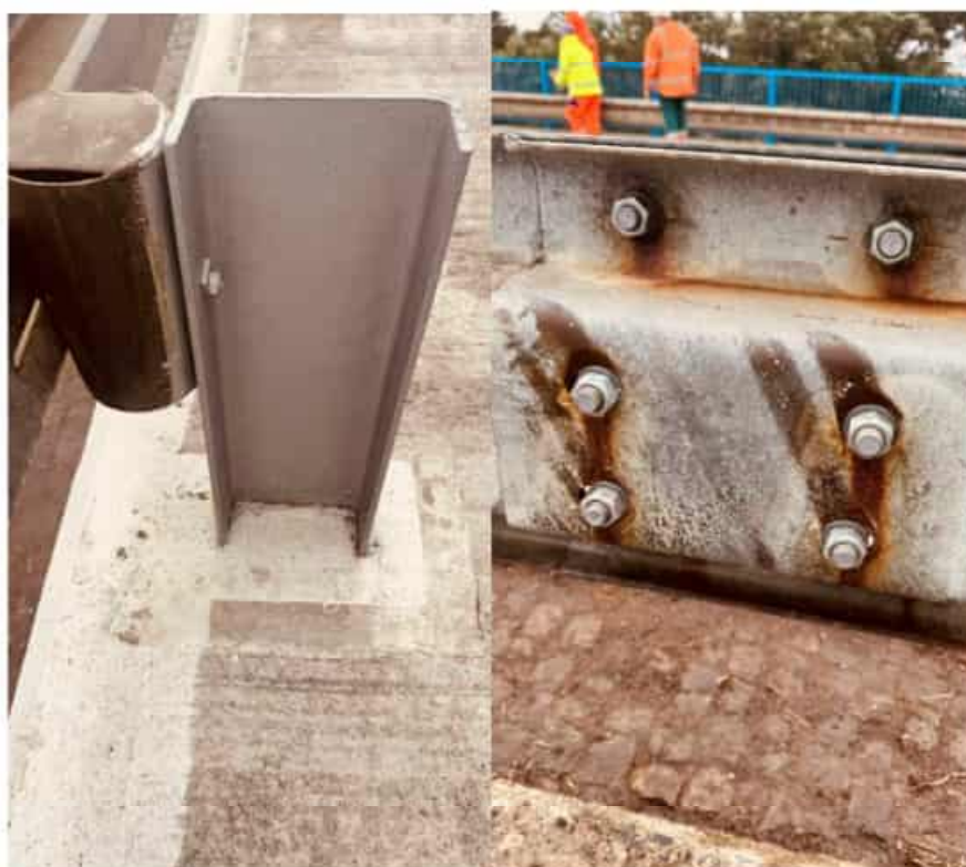
Obr. 4 – svodidla – obnova PKO+spoj.mat - 36,6 m 2
