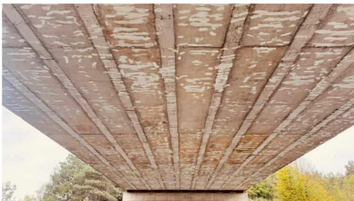
Obr. 2 – reprofilace spodního líce NK – 81,130 m 2
