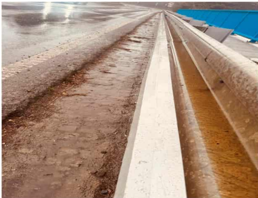
Obr. 6 – Přibetonávka levé římsy – 9,76 m 3 (ZBV) celkem 12,51 m 3
