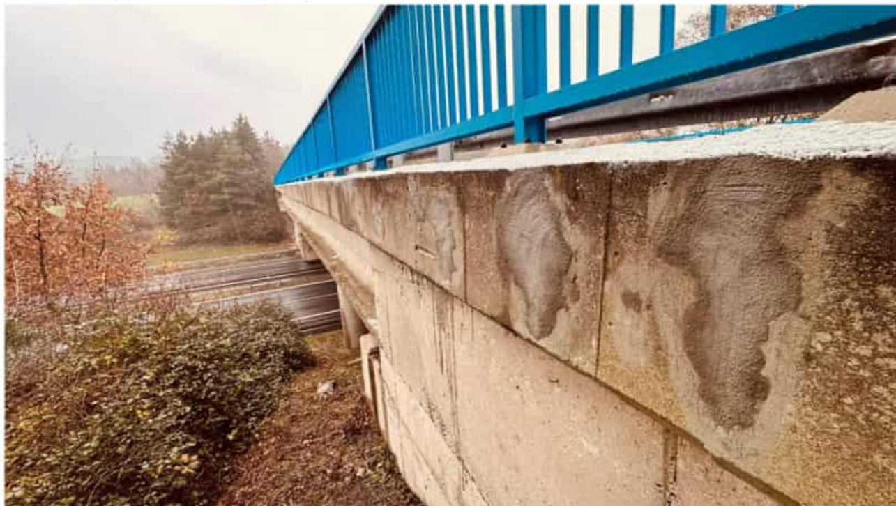
Obr. 1 – reprofilace svislých ploch říms – 7,3 m 2
