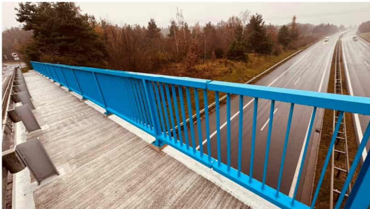
Obr. 4 – svodidla – obnova PKO+spoj.mat - 36,6 m 2
