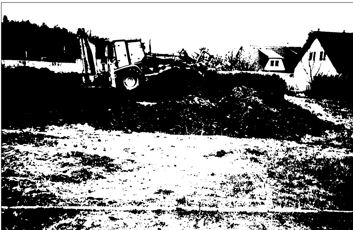
Obrázek č. 13 – Stavební realizace hřiště – zemní práce (zdroj: FK TJ Háje JM)
