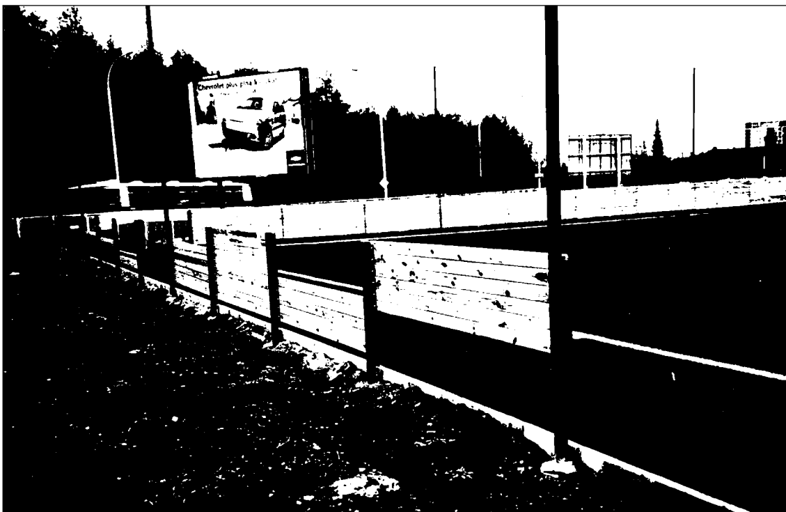
Obrázek č. 17 – Stavební realizace hřiště – montáž ohrazení (zdroj: FK TJ Háje JM)
