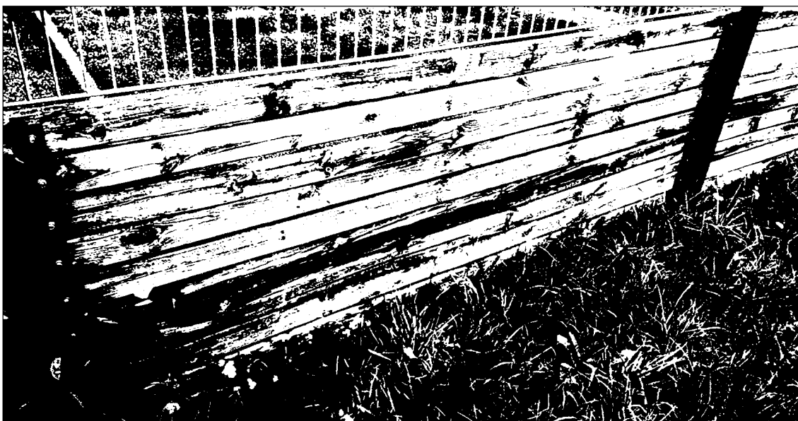
Obrázek č. 5 – Poškození latí dřevěného ohrazení (zdroj: Znalec)
