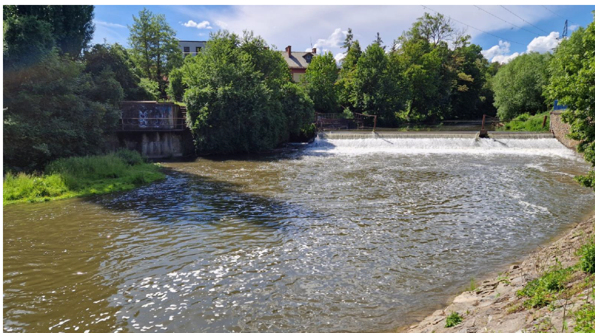
Obr. 1 - Stávající stav jezové konstrukce
