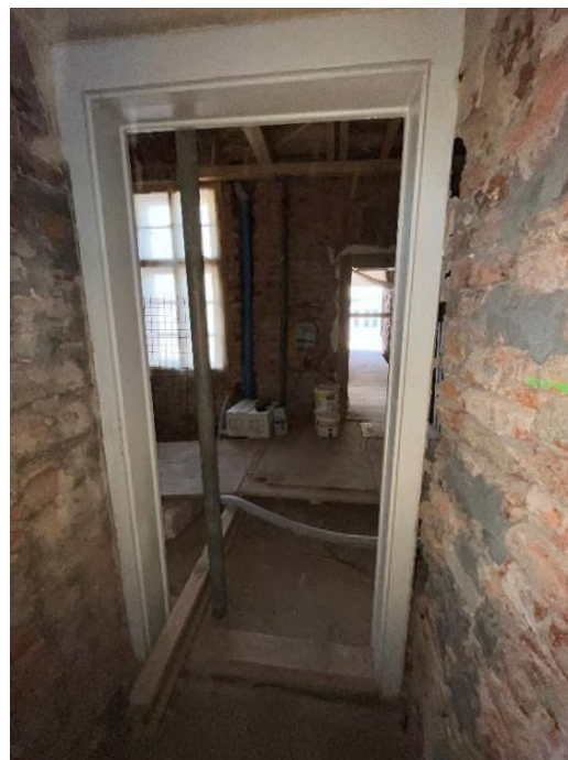
Obrázek 1 původní zárubně dveří
