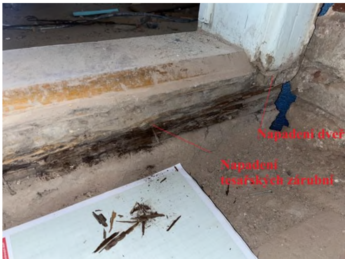
Obrázek 2 Napadení dveří
