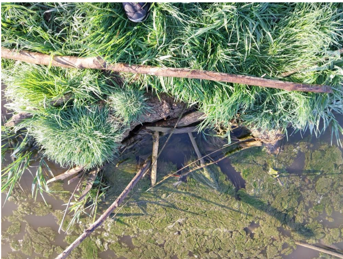
Obr. 4: Zatopený vtokový objekt spodní výpusti
