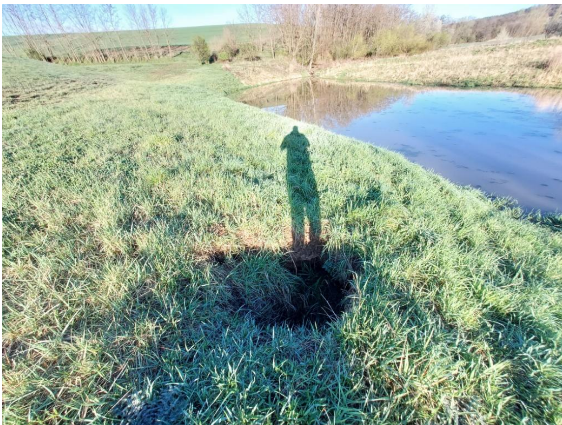
Obr. 3: Propadliny v hrázi
