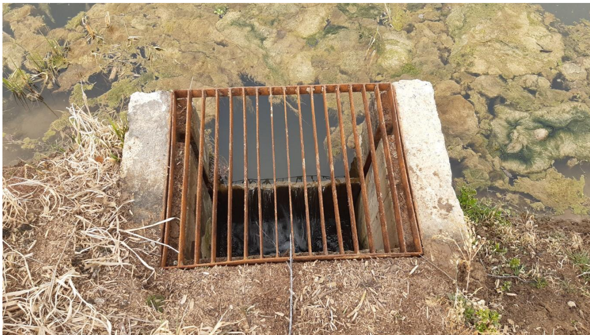
Obr. 5: Vtokový objekt při normálním stavu vody
