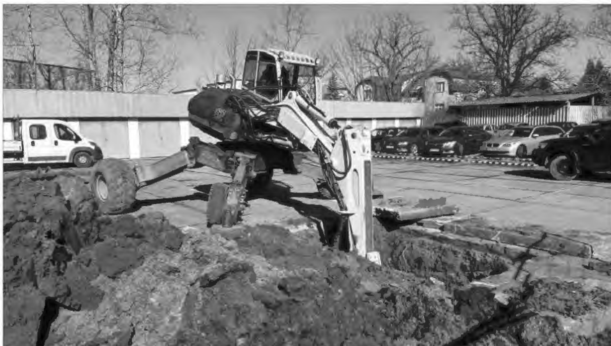
Obr. 3 Hloubení sondy SČB-1 (pohled od JV).
