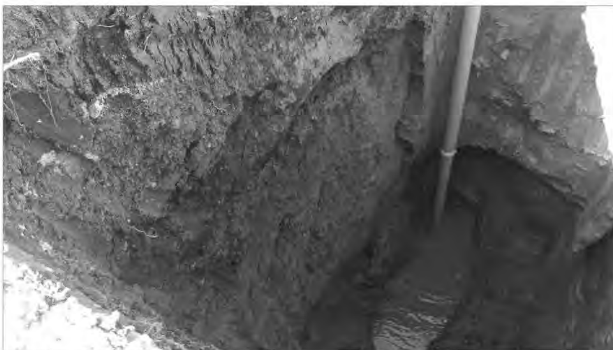
Obr. 4 Před záhozem byla do sondy trvale vložena perforovaná PVC pažnice DN125 pro monitorování hladiny podzemní vody. Dno sondy v 5,5 m p.t. je okamžitě zaléváno podzemní vodou.
