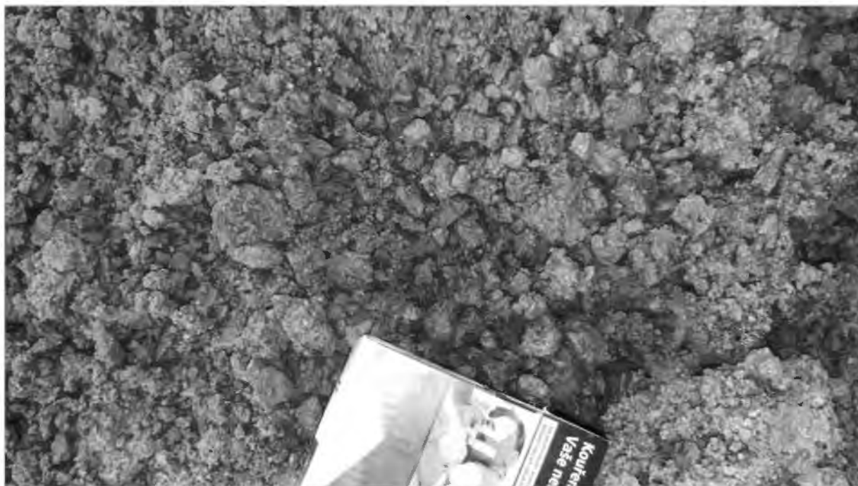
Obr. 9 Silně zvětralý prachovec.
