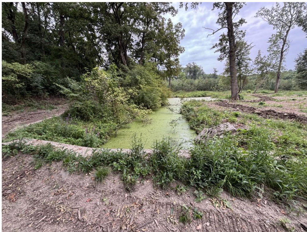
Obr. 3: Pohled na zvodněnou část propojovacího kanálu
