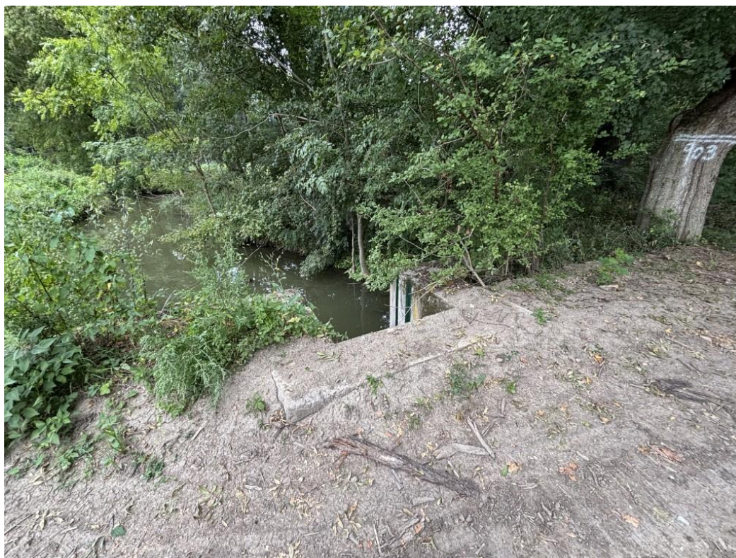
Obr. 2: Stávající manipulační objekt na zvodnělé části kanálu, v horní části obr. napojení na VT Teplý járek
