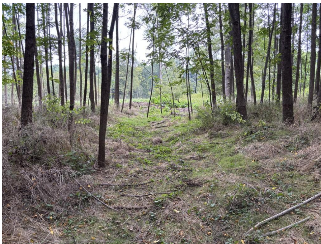
Obr. 4: Pohled na nezvodněnou, avšak v terénu patrnou část kanálu
