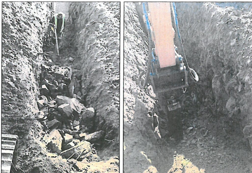
hrubě blokovitě rozpojené bazalty a prokřemenělé prachovce rozpojování hornin těžkým impaktorem
