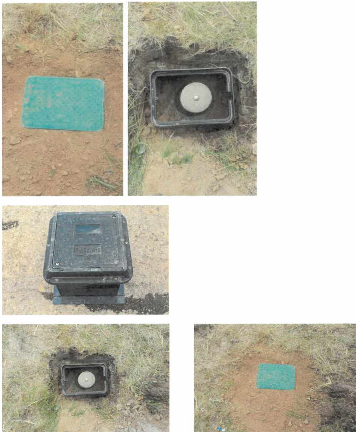
Obrázek 10: Osazení ochranné šachty
