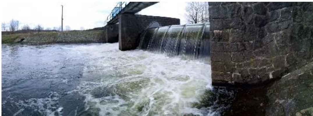
Obrázek 1 – Pohled na jez Jíno, limnigrafická stanice měří ve spodní vodě
