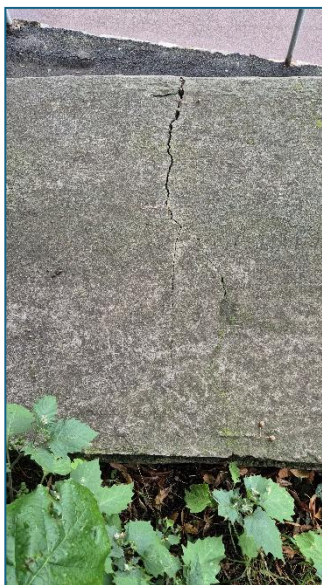
Obrázek 5 – poruchy římsy v místě severního nároží a vzrostlé lípy na jižním konci
