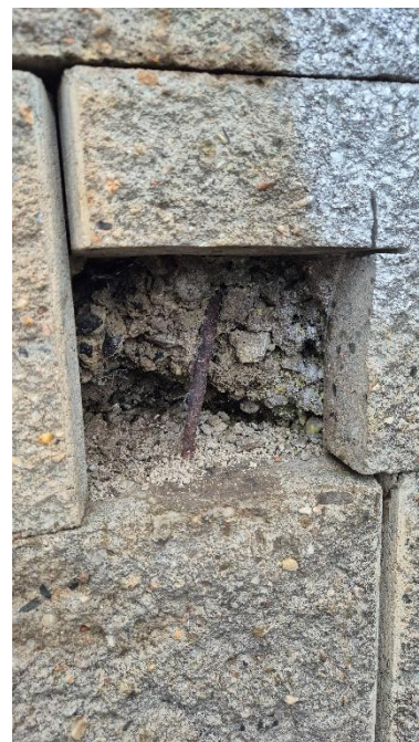
Obrázek 3 – postup degradace výztuže a výplně z betonu
