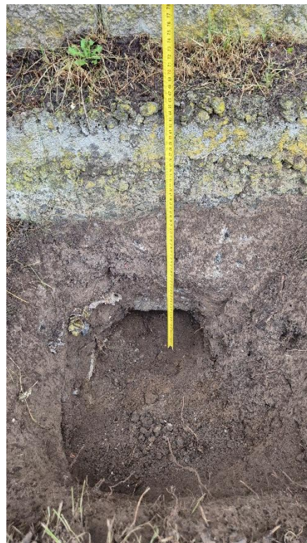
Obrázek 1 – hl. založení přízdívky
