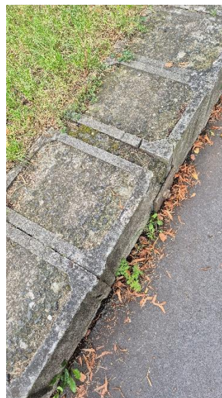
Obrázek 7 – kotevní blok táhla
