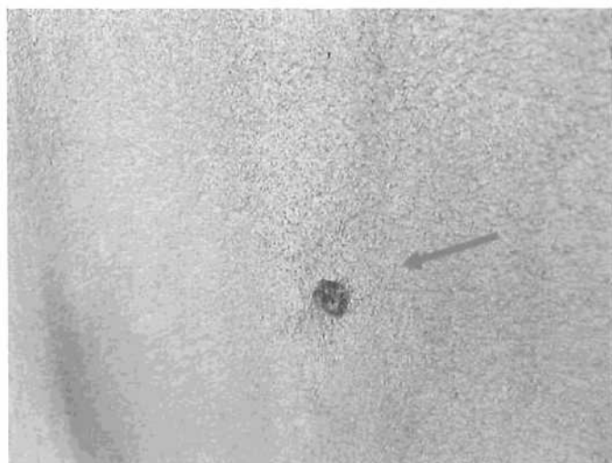
foto/81/ Otvor v ploše fasády
