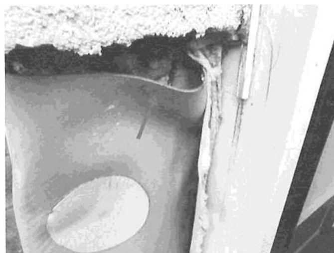
foto/77/ Netěsné provedení detailu
