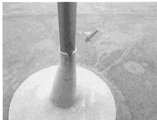
foto/72/ Absence PU tmelu na kotevním bodu
