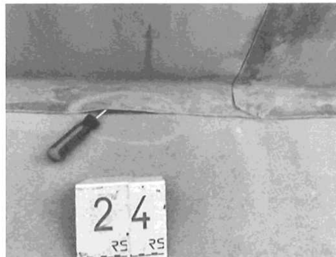
foto/15/ Porucha ve sváru folie
