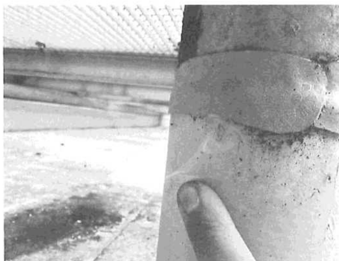
foto/41/ Únik dýmu v místě vytažení na prostup
