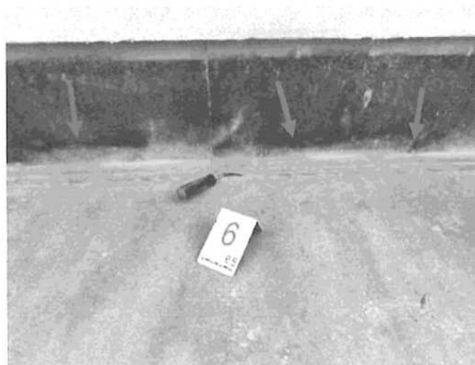
foto/29/ Čtyři poruchy ve sváru
