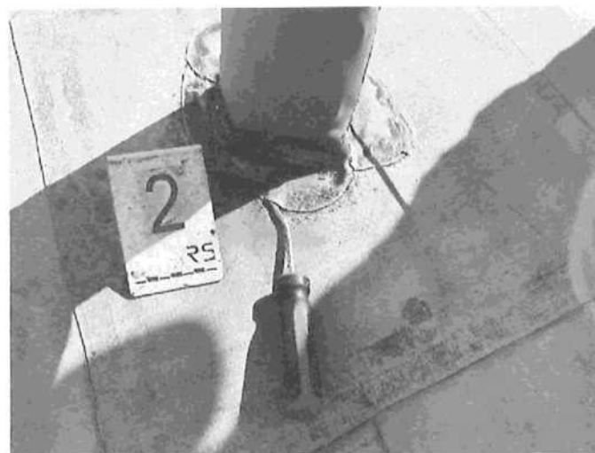
foto/09/ Porucha ve sváru detailové folie
