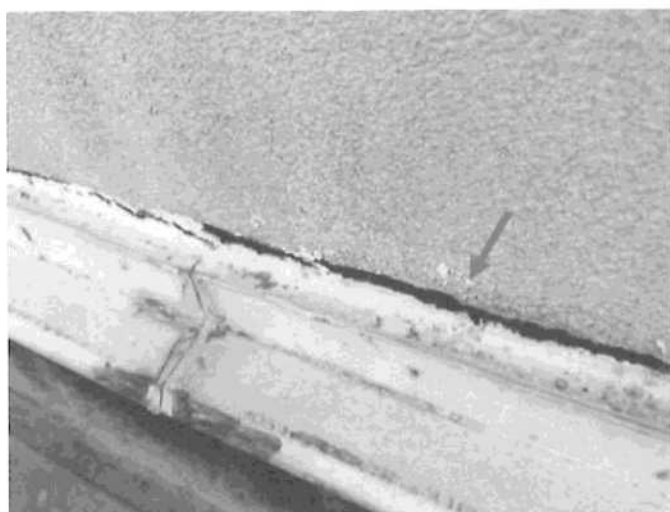
foto/75/ Degradace či absence tmelené spáry
