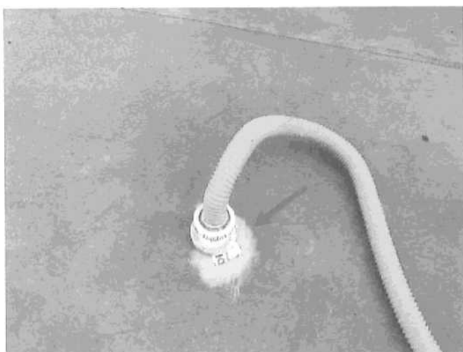
foto/04/ Zavedení trysky T1 dýmové zkoušky
