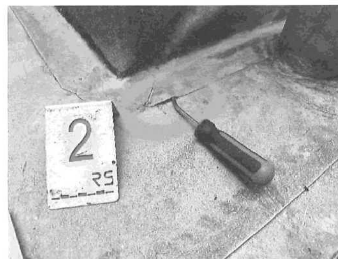
foto/27/ Únik dýmu – připojovací spára fasáda
