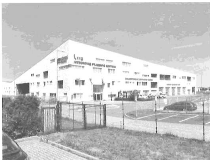
obr/02/ Pohled na předmětný objekt (zdroj: mapy.cz)
