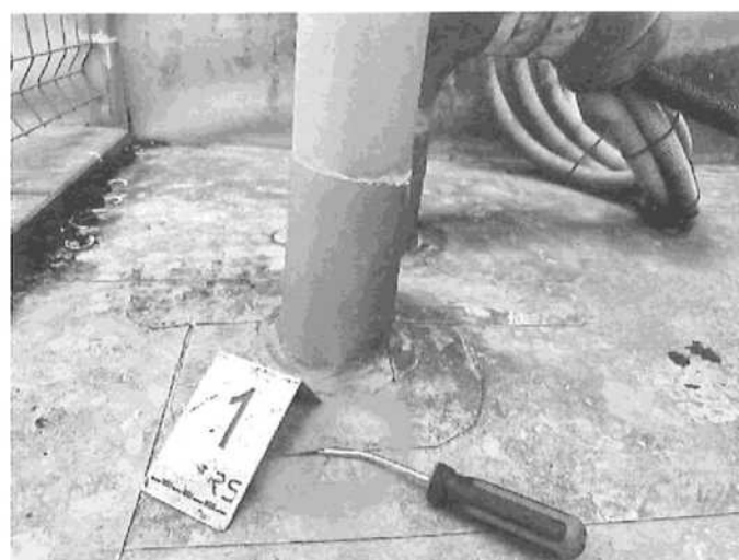
foto/26/ Únik dýmu – spoj fasádních prvků
