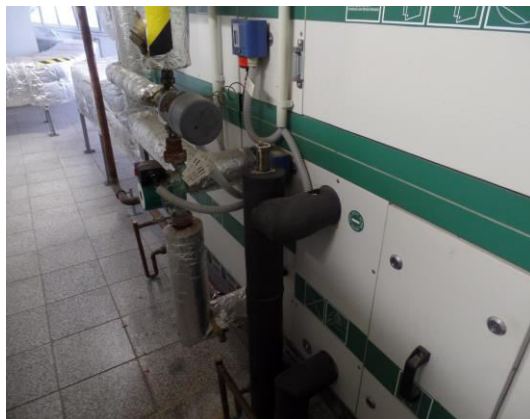
Obrázek 18: Napojení VZT na topnou a chladnou vodu
