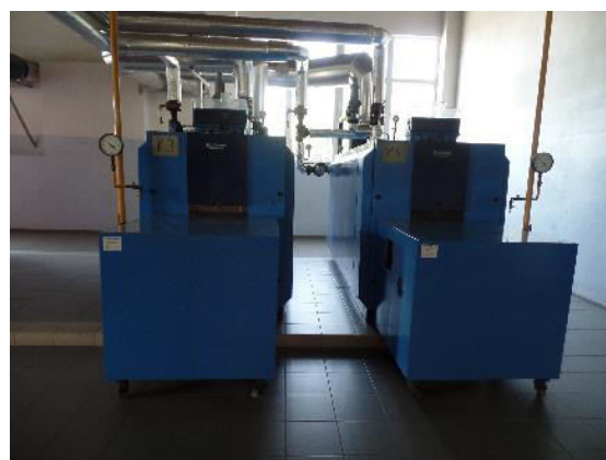
Obrázek 5: Teplovodní zdroj tepla
