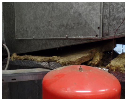
Obrázek 24: Izolace VZT jednotky
